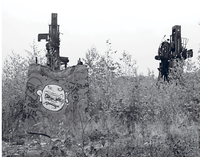
KUVA 4. Penttilän sahan aluetta vuodelta 2004. Saharakennuksesta jäivät jäljelle vain raamit tuhoisan tulipalon jälkeen. Kuvaaja Kaisu Kortelainen.
