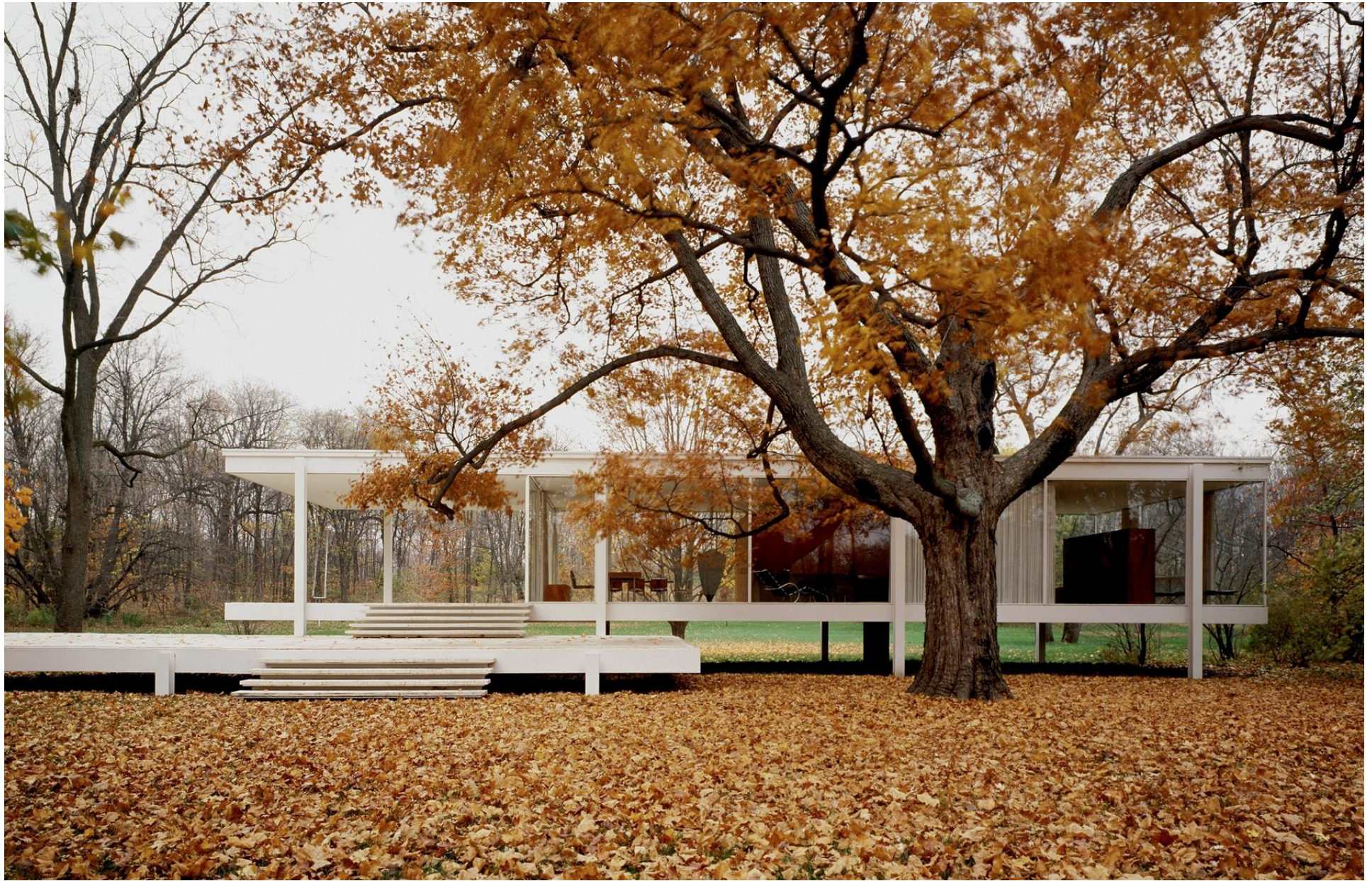
Mies van der Rohe / Farnsworth house 1945 - 1951
