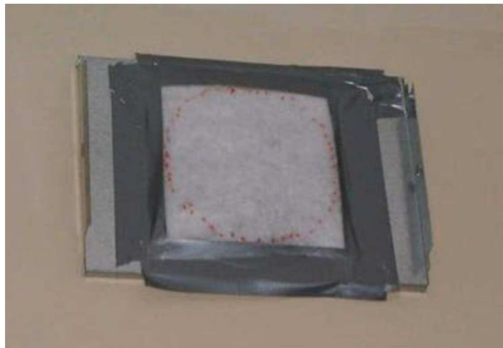
Kuva 5 Polypropyleenisuodatinkangas kiinnitettynä tuloilmalaitteen paikalle (Kovanen et al., 2006)
