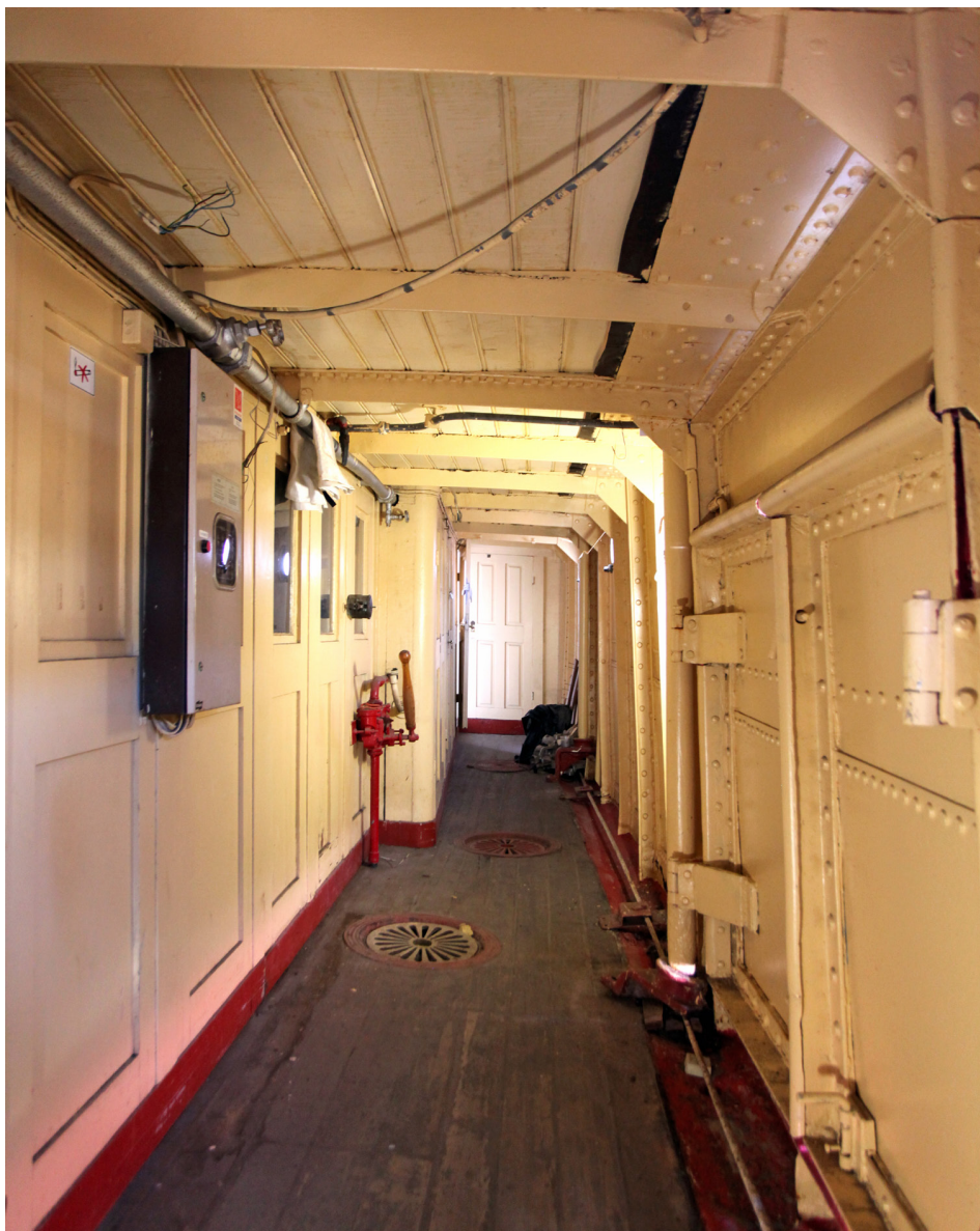
Paapuurin puoleista käytävää (203) perään päin kuvattuna. Tilahahmo on säilynyt alkuperäisen kaltaisena. Oikealla kaksilehtinen teräsovi, jonka kautta laivaan on tuotu kaikenlaisia tarvikkeita.
