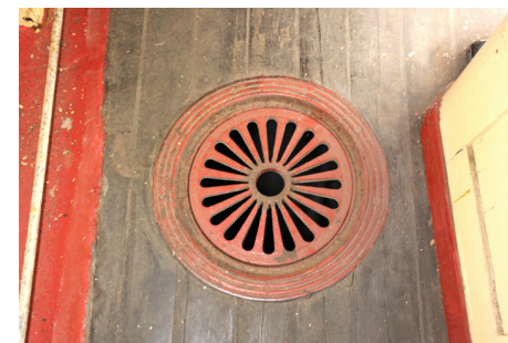
Lattiasa olevista aukoista on tiputettu hiiltä alapuolella olevaan hiilivarastoon (003).
