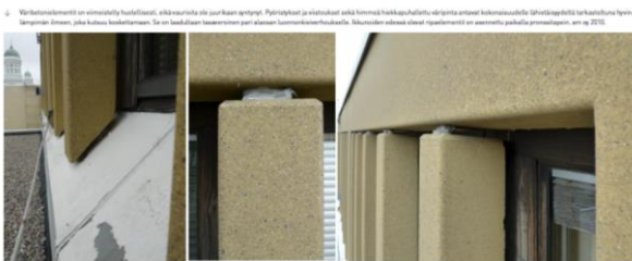
4. Valtioneuvoston on elementit tehdäkseen, eikä vauriota joka puoleen arkkitehti. Piirrokset ja elementit sekä toteutus tekijänsä luottamusta ja luottamusta. Sivellä on kuvattu työt ja työt. Olli Heltavuori, am. sy 2010.
