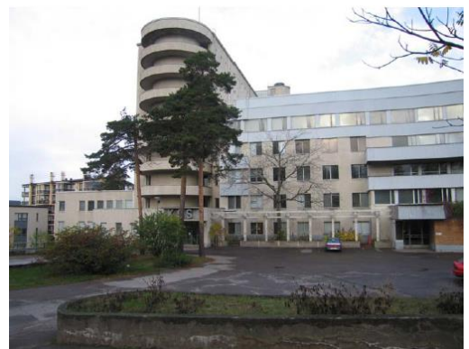
TILKAN ENT. SOTILASSAIRAALA, HELSINKI. RHS 2006 .ARKKITEHTITOIMISTO SCHULMAN OY.
