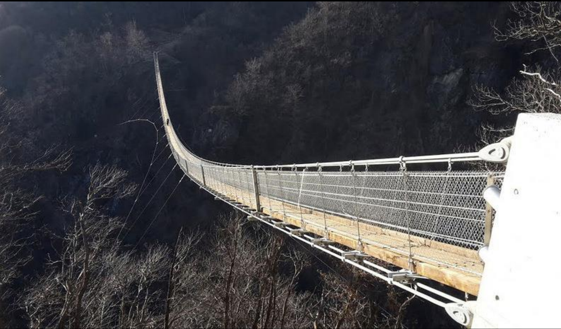
Bridge Sementina & Monte Carasso
