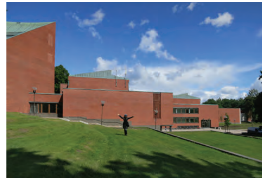
Entisen TKK:n päärakennuksen nurmetettua terassointia, joka laskeutuu Alvar Aallon puistoon.
