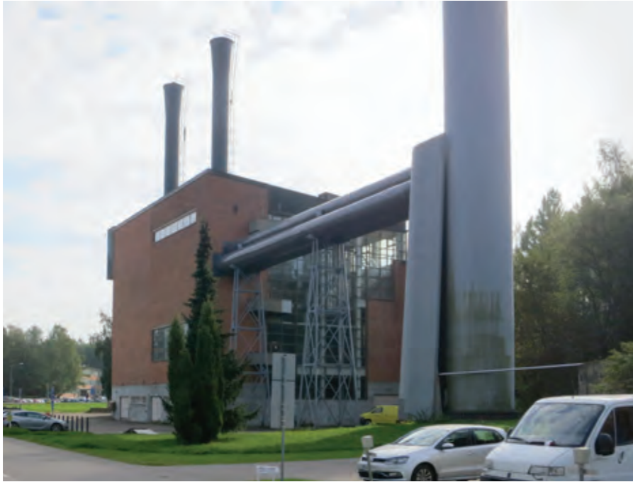
K2. Voimalaitos ja sen uusi teräspiippu tukiosineen.
