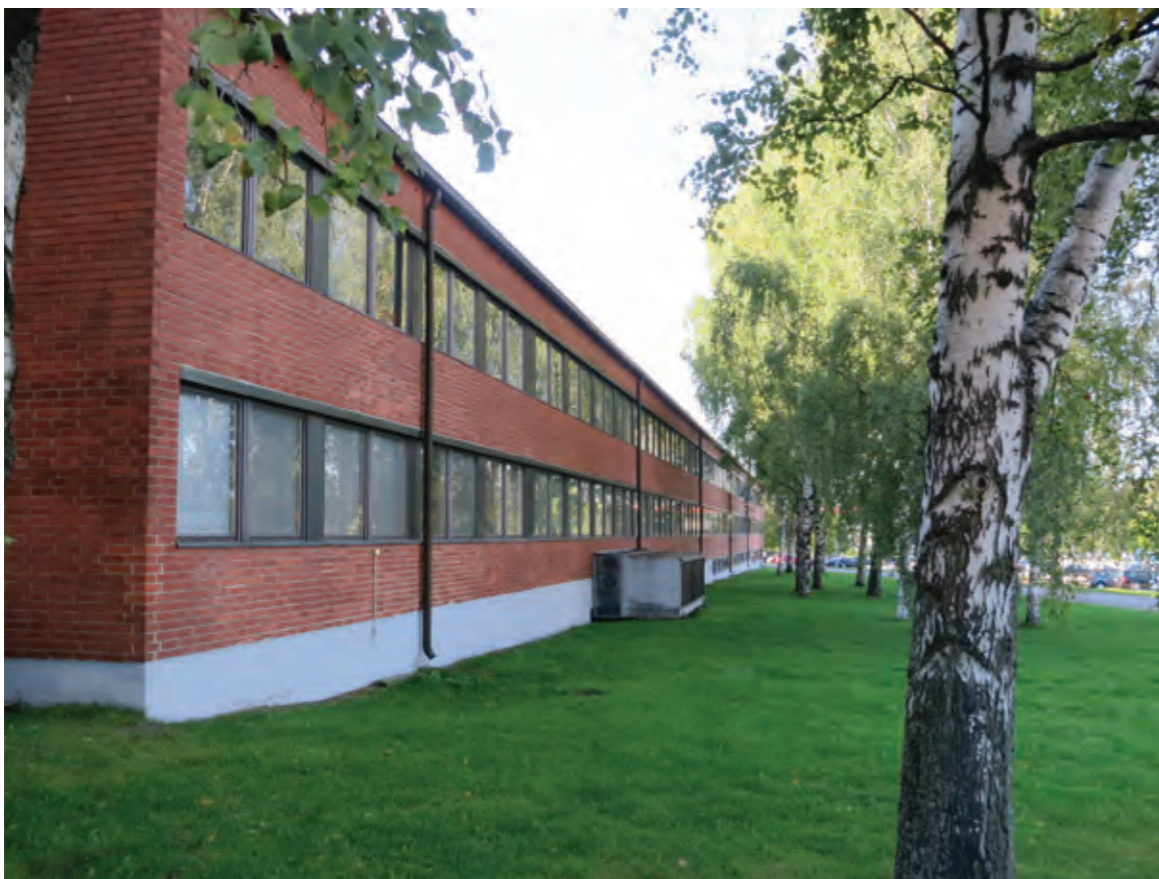
V3. VTT:n entisen elintarvikelaboratorion Otaniementien-puoleinen julkisivu vuonna 2014.
