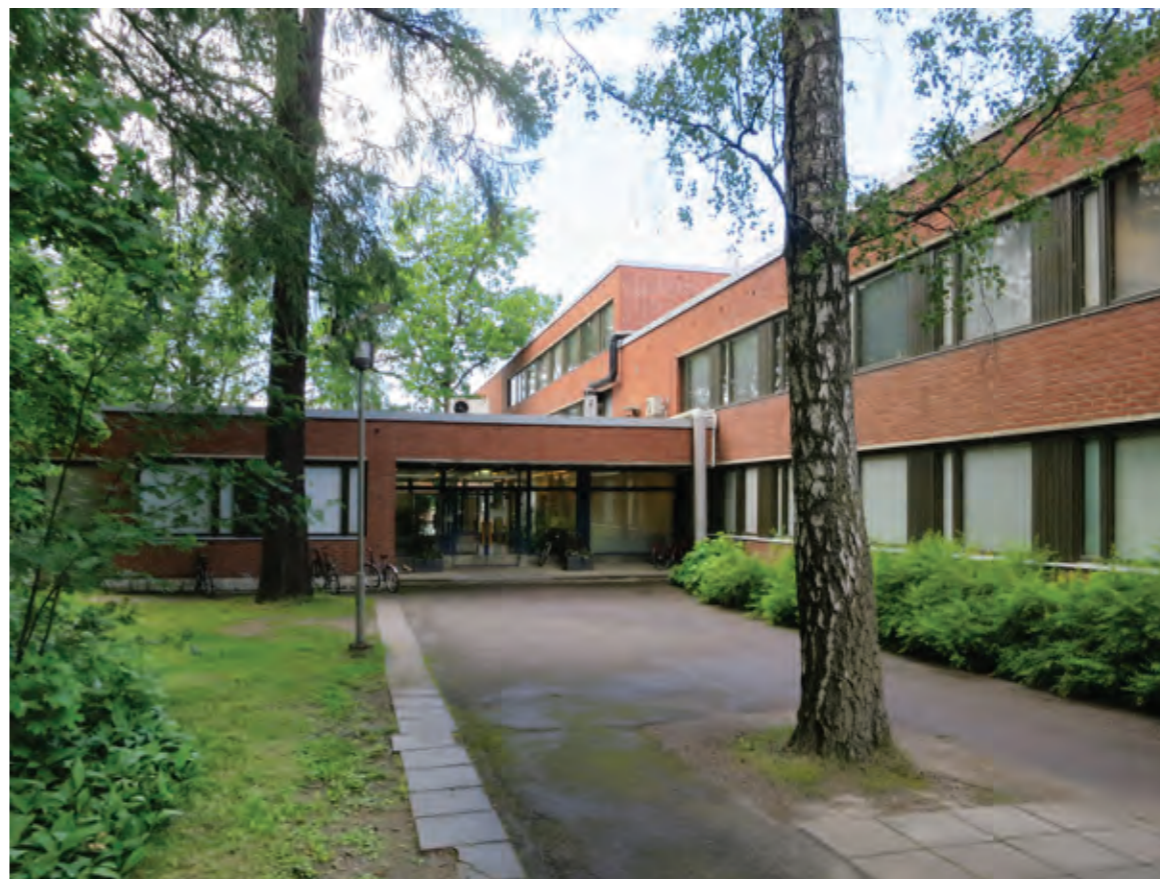
V7. VTT:n kemiallisteknisen laboratorion eli kemian laboratorion pääsisäänkäynti ja julkisivua Hagalundinpuiston suuntaan vuonna 2014.
