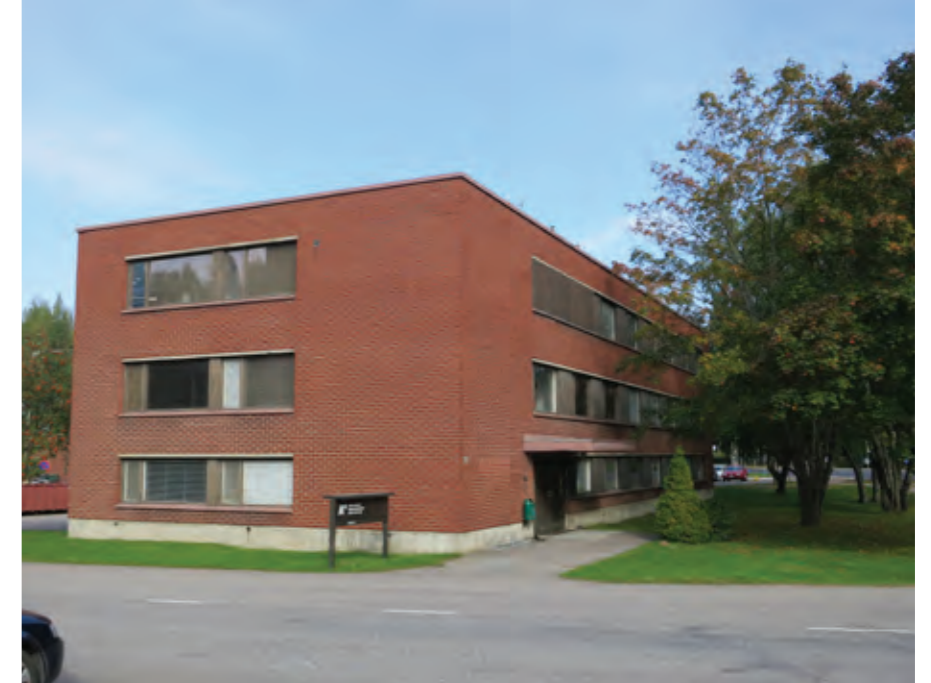
K8. Entisen Otaniemen hoitokunnan rakennuksen eteläpääty ja Otakaaren-puoleinen julkisivu vuonna 2014.
