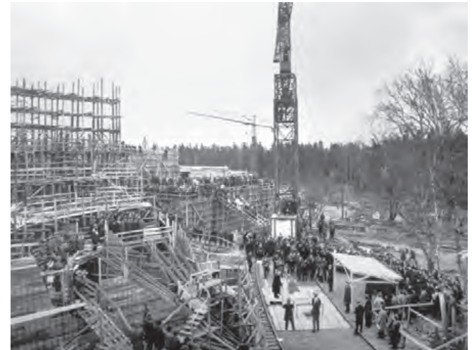
TKK:n päärakennuksen juhlallinen peruskivenmuuraustilaisuus vuoden 1962 lopulla. Rakennus valmistui vuonna 1964. Lähde: AYA.
