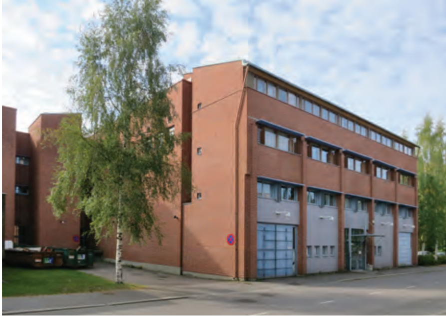
K7. Entisen TKK:n virtauslaboratorion ja VTT:n laivatekniikan laboratorion uusi osa Sähkämiehentien ja Konemiehentien kulmassa vuonna 2014, jolloin rakennus tunnetaan Aalto-yliopiston Konetekniikka 4:nä.
