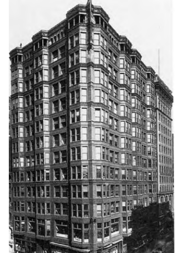
Holabird & Roche: The Tacoma Building, Chicago (1887). Rautarunko koottiin niittaamalla ja ilman telineitä ahtaassa kaupunkitilassa.
