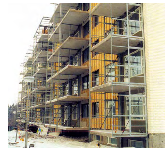
Uusia parvekkeita vanhaan betonielementti-kerrostaloon
