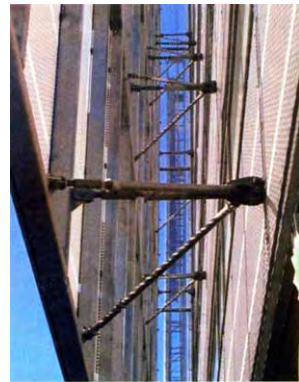
Kaksoisjulkisivun ripustuskiinnitys
