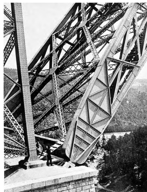
Vanha kuumaniitattu rakenne. Gustave Eiffel: Viaduc Garabit
