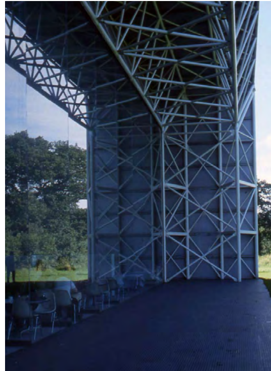
Norman Foster: Sainsbury Center (1978). Suuresta jännevälisestä huolimatta hitsattu avaruusristikkokehä antaa keveän vaikutelman.
