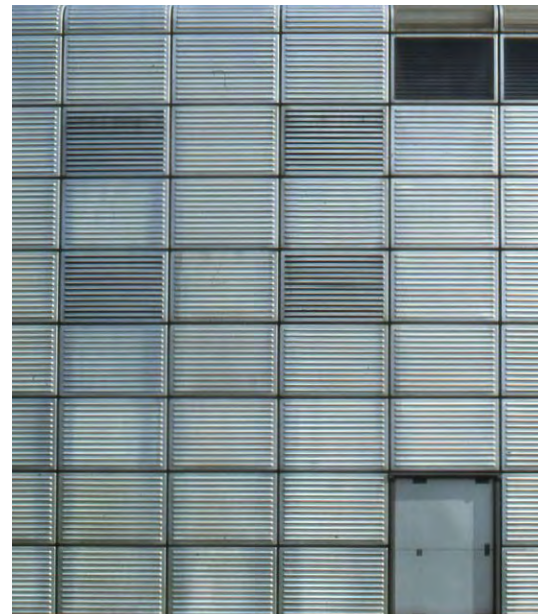
Alumiiniverhottu julkisivu. Norman Foster: Sainsbury Center (1974-78)
