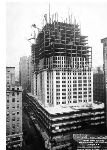
Empire State Building rakenteilla. Se valmistui 1931 ja oli pitkään maailman korkein rakennus.
