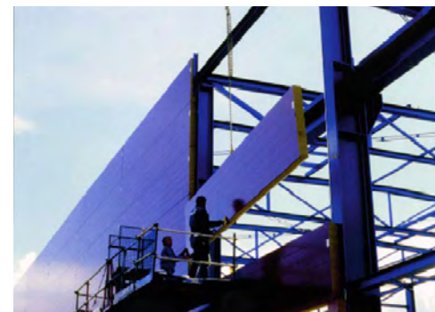
Kevytelementtejä asennetaan runkoon.
