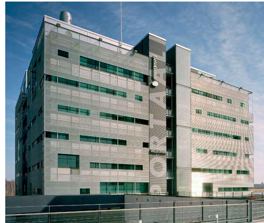
Levyverkko (expand-verkko) valmistetaan venyttämällä lävistettyä teräslevyä.
