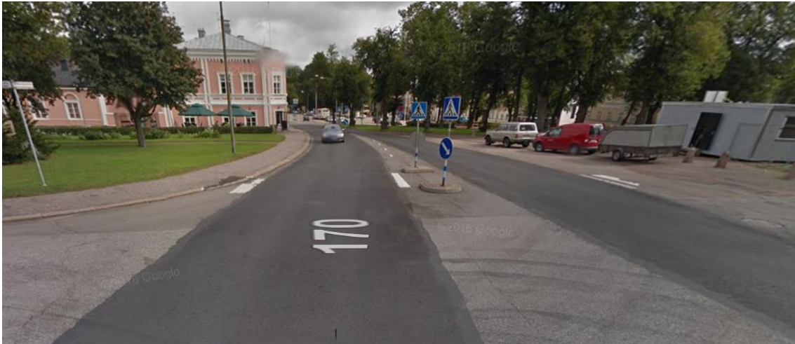
Kuva 8 Suunnitteluohjeiden vastainen tien ylitys Loviisassa. Kuva ei ole onnettomuuspaikalta. (Google Maps 2017)
