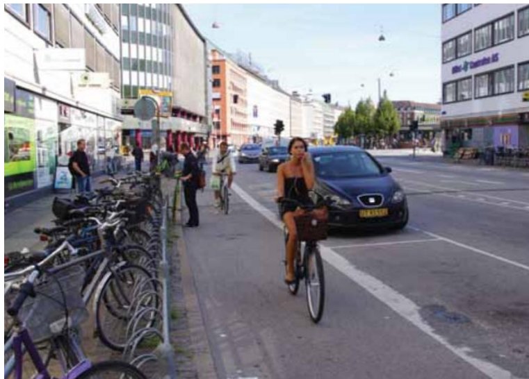
Kuva 8 Pyöräkaista, jonka vieressä on pysäköintikaista (Cycling Embassy of Denmark 2012, s. 63).
