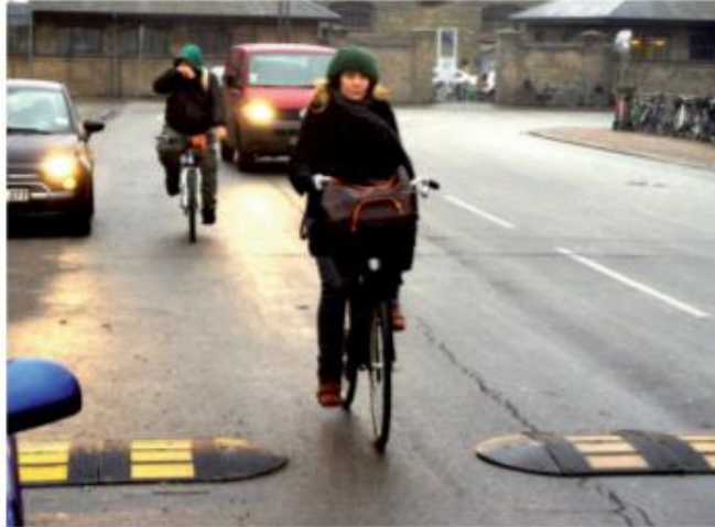
Kuva 9 Hidaste, joka on pyöräilijän väistettävissä (City of Copenhagen 2013, s. 18).
