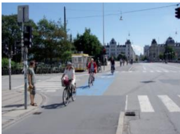
Kuva 7 Poikkeuksellisen leveä, 4 metriä leveä pyörätie (City of Copenhagen 2013, s. 12).
