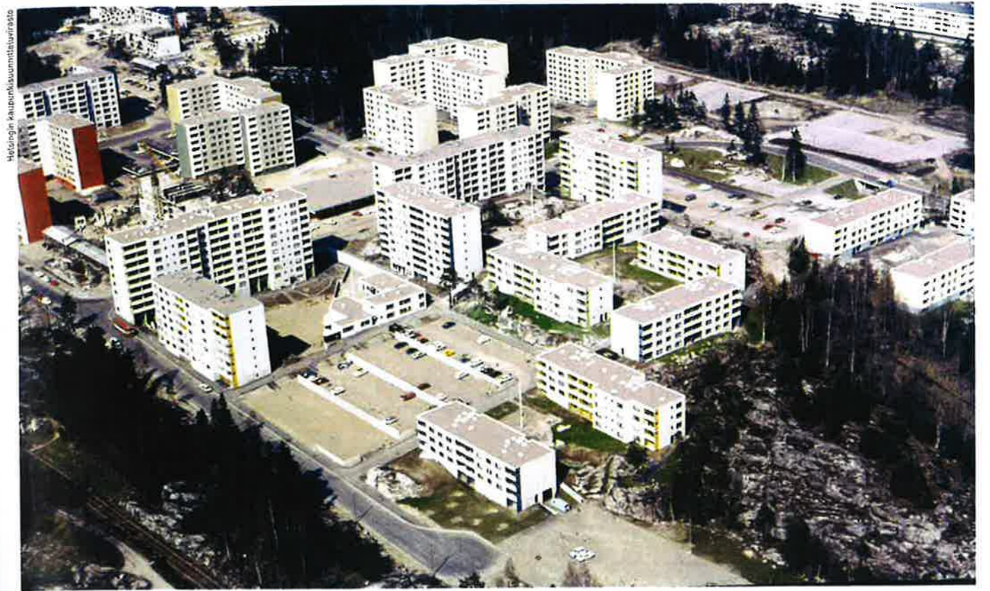
1960-luvulta eteenpäin lähiörakentaminen perustui teolliseen betonielementtitekniikkaan ja yhdenmukaisten lamelli- ja pistetalojen toistoon. Rakennusten koko kasvoi ja ulkoarkkitehtuuria leimasivat ajan esteettisten tavoitteiden mukaisesti tasakatot, nauhaikkunat tai reikäelementit. 1970-luvulle tultaessa lähiörakentaminen perustui suorakulmaiseen koordinaatistoon suunniteltuihin rationaalsiin tuulimylly- ja avonurkkakortteleihin. Pihlajisto, Helsinki.
