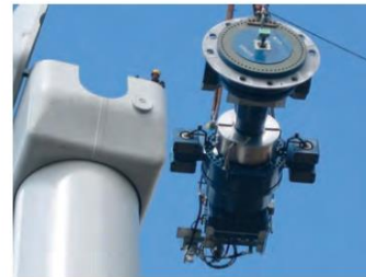
Kuva 2.54 Vaaka-akselisia tuulivoimaloita ja vaihdelaatikon ja jarrujen nosto
