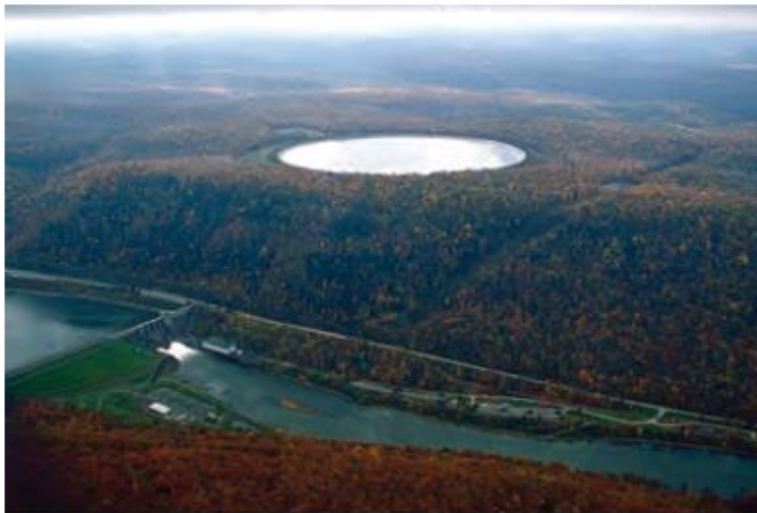
Kuva 2.76 Pumppuvesivoimalaitos, jossa vesiallasta käytetään energiavarastona.
