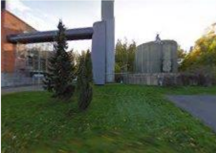
Kuva 2.69 Otaniemeen toteutettavan geolämpövoimalan sijoituspaikka on olemassa olevan voimalaitoksen vieressä ja lämmön tuottoa varten on porattu kaksi noin 6,5 km syvää reikää.
