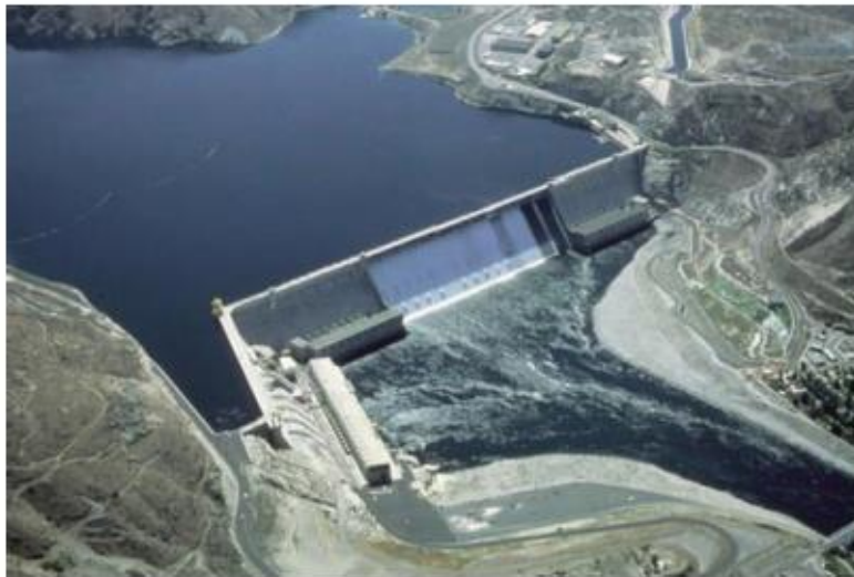
Kuva 2.5 Grand Coulee Dam ja siihen liittyvä tekojärvi USAssa lähellä Kanadan rajaa oli pitkään maailman suurin vesivoimalaitos (7 GW) ja se on rakennettu jo 1942. Padon korkeus on 170 m ja pituus 1,6 km.
