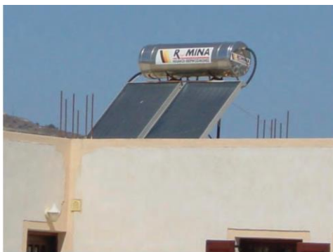
Kuva 2.18 Tyypillisesti rakennusten katolle asennettava aurinkokeräin ja periaatekuva sen toiminnasta.
