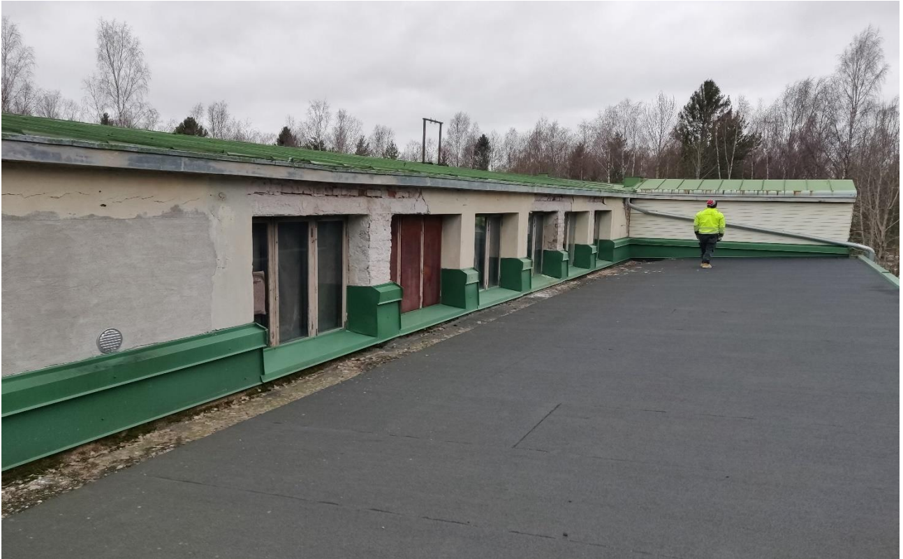
Vesikatto, osittain vanha peltikate on uusittu huopakatteeksi.
