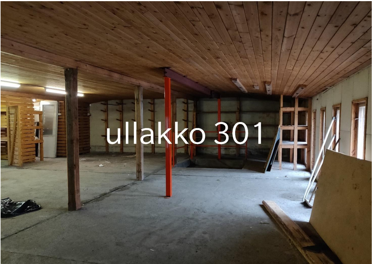
Ullakko 301, ulkoseinän sementtilevytys sisältää asbestia.
