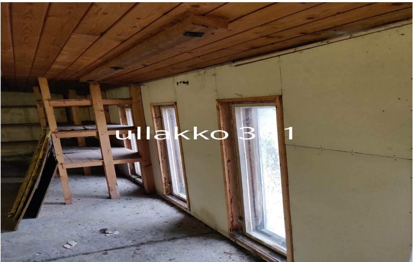
Ullakko 301, ulkoseinän sementtilevytys sisältää asbestia.
