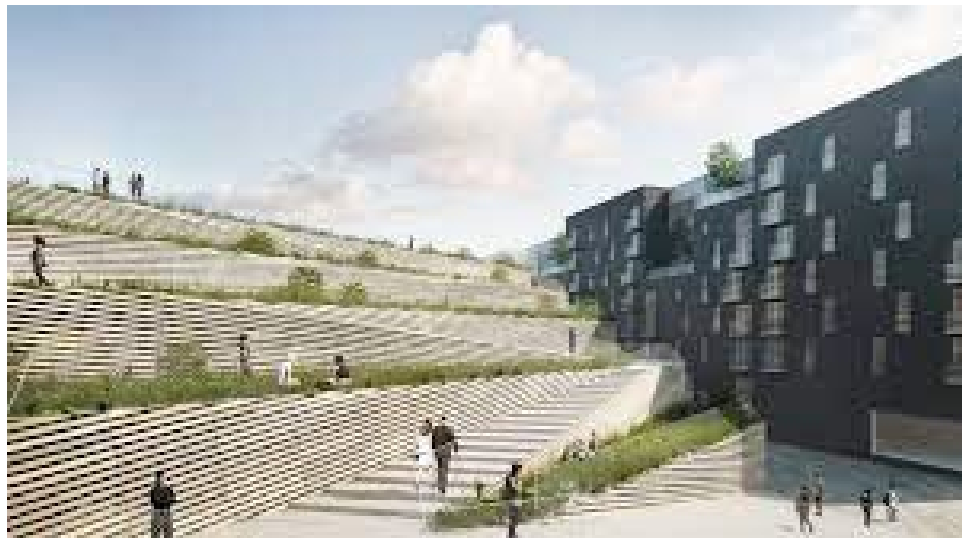
ALA Saukonlaiturin pysäköintilaitos
