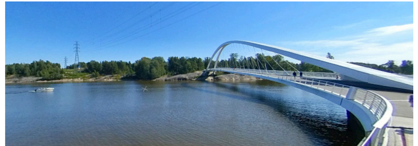
Näkymä Kalasatamasta yli Isoisän sillan
