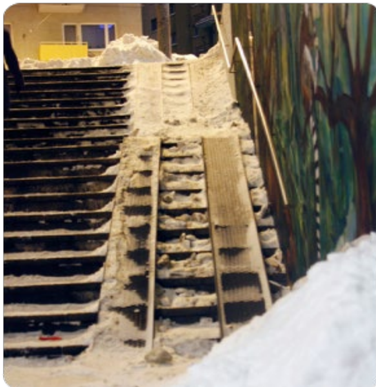
Kuva 88: Jos luiskan päälle tehdään katos, sen kunnossapito talvella ja käytön turvallisuus paranevat.
