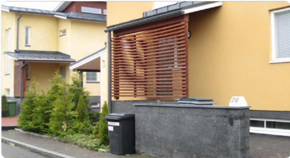
Kuvat 14 ja 15: Taloista on hyvä näkyvyys alueen sisäisille väylille ja yhteiselle leikkipaikalle. Kasvillisuutta on tarpeellista hoitaa niin, että hyvät näköyhteydet säilyvät. Sisäänkäynnit asuintaloihin ovat lähes suoraan kadulta. Puurimoitus tuo niihin kuitenkin yksityisyyttä.
