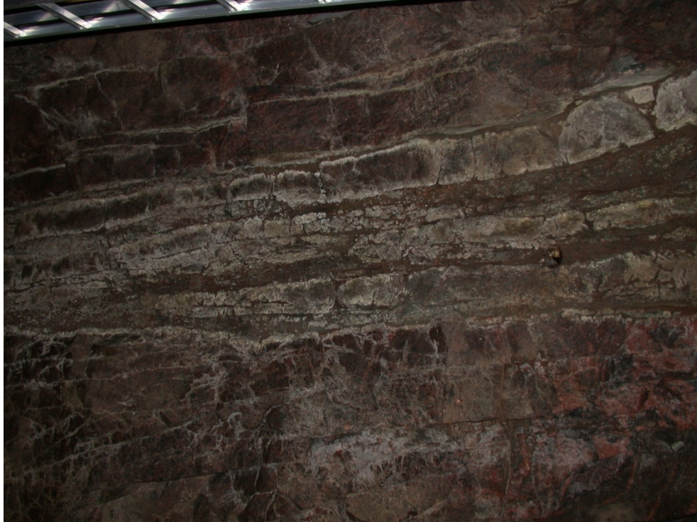
Kuva 5. Karkearakeinen, punainen graniitti, joka on rakoillut vaakakerrosmaisesti ja osittain rapautunut. Kuva: M. Wennerström
