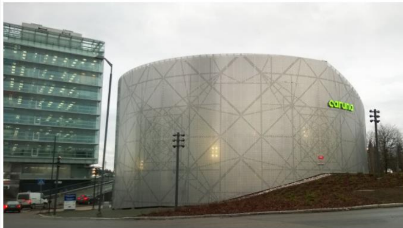
Sähköverkkoyhtiö Carunan sähköasema Espoon Keilaniemessä. Kuva: Yle
