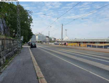
8. Puiston itäreunan kalliioleikkausta ja muuria Laivasillankatua vasten.
