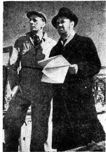
Eteläsataman uuden laiturin rakentajia: oikealla insinööri A. R. Lindroos, vasemmalla rakennusmestari V. Lindström.
