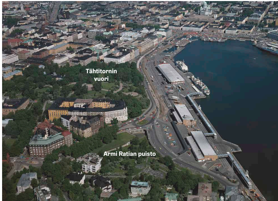
Tähtitornin vuori ja Armi Ratian puisto rajautuvat rannan puolella suoraan leveisiin katutiloihin ja kummankin puiston rajalla on jouduttu tekemään kalliioleikkauksia. Muilta osilta puistot rajautuvat ympäröiviin rakennuksiin tai puistokatuihin. Kuvaaja SKY-FOTO Möller 1977, HKM.
