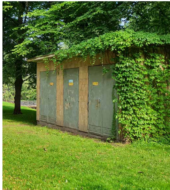
Muuntamorakennus vuodelta 1957. Vanhan, 1894-1952 käytössä olleen ratakuilun linjaus kulki täsmälleen aidan ja muuntamorakennuksen välissä. Kuva 2021.
