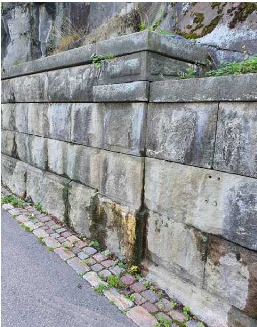
3. Laivasillankadun varren tukimuuria kallioleikkauksen yhteydessä. Tukimuuri toteutettiin kadun rakentamisen yhteydessä 1870-luvulla.
