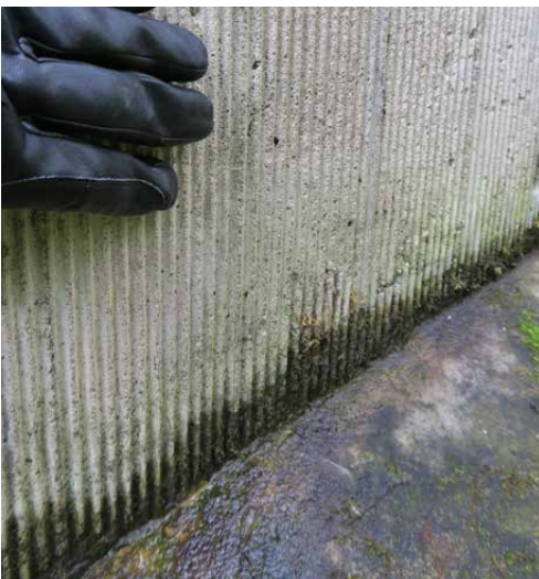
Rautatiekuilun puolella Myllytie 2:n valkobetoni ja erityisellä makkara-paneelitekstuureilla valettu sokkeli kohoaa kauniisti ja terävästi koskemattoman silokallion päältä; eleganttia Erviä!
