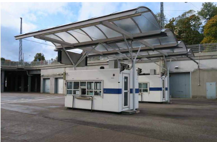
Laiturialueen lähtöselvityskopit ovat 1990-luvun alusta. Katosrakenteet toteutettiin vuonna 1996. Kuva vuodelta 2021.
