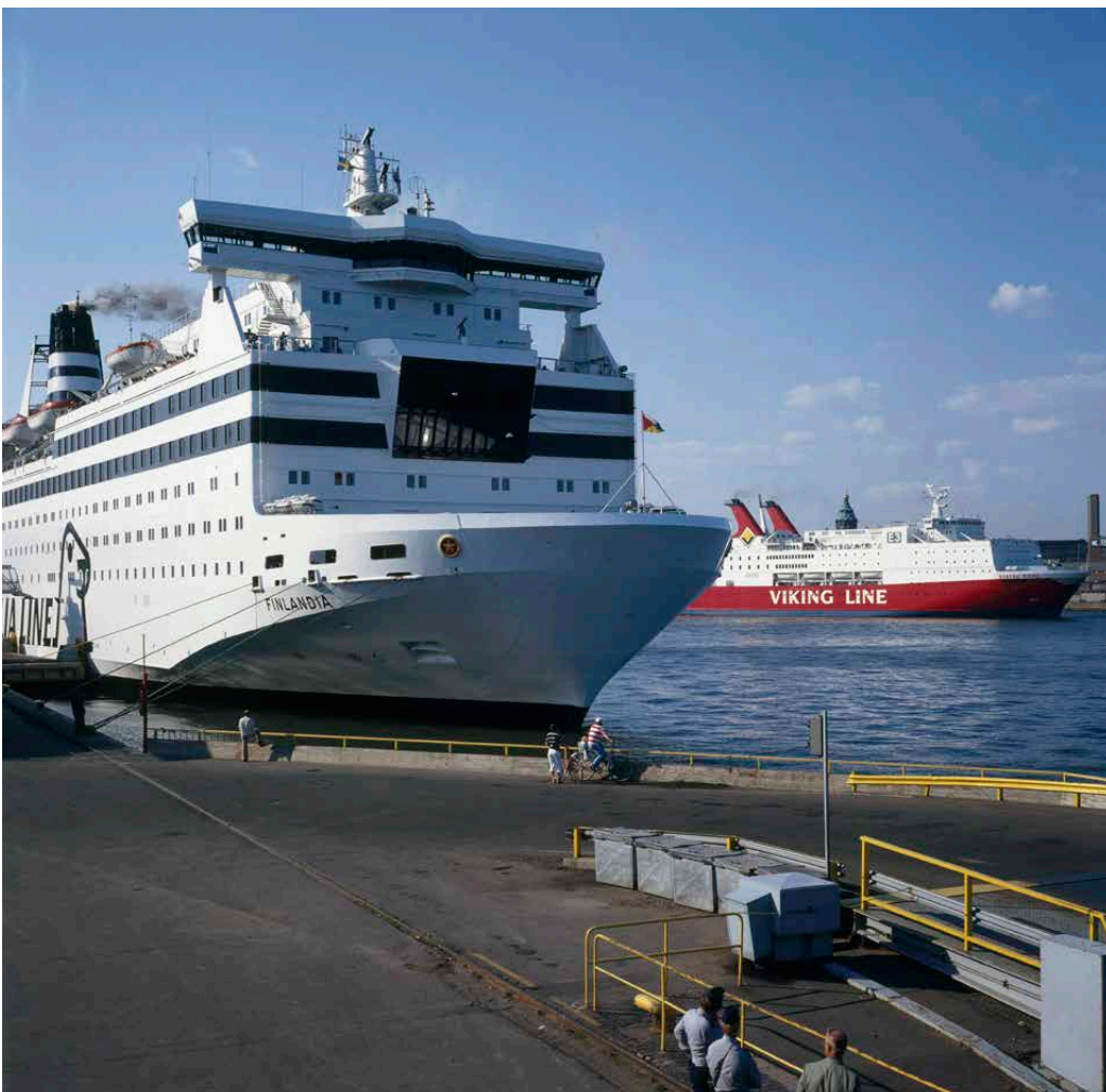
Kuvassa etualalla nk. peräportti-paikka, joka oli autolauttojen lastausta ja purkua varten rakennettu laituriuloke. Volker von Bonin, 1983-1986, HKM.
