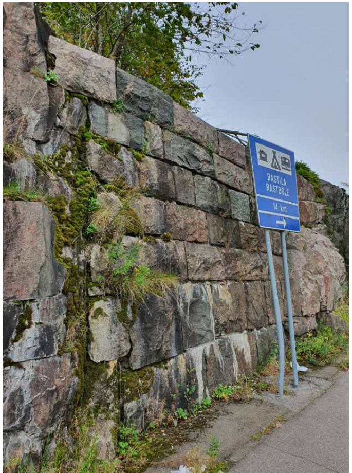
6. Ehrenströmintien vastainen kalliroleikkaus on tuettu luonnonkivistä rakennetulla tukimuurilla. Kivet sulautuvat hyvin ympäröivään kalliopintaan.
