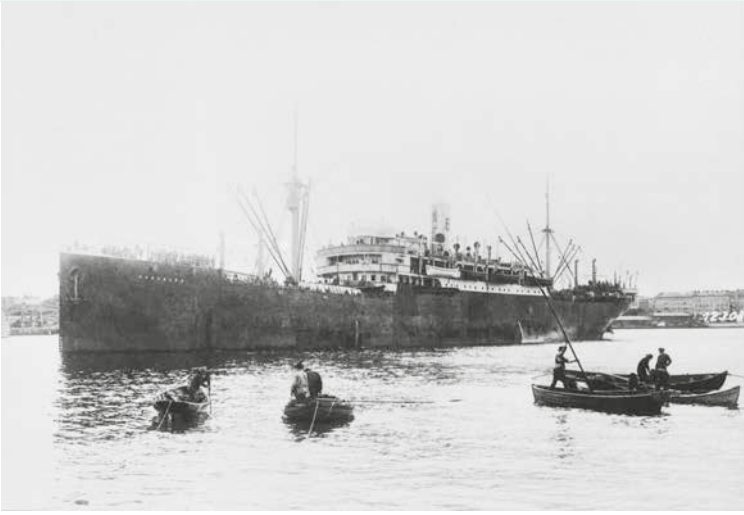
Höyrylaiva Habsburg Helsingin satamassa. Alus tuhoutui lokakuussa 1918 ja surmansa sai 123 takaisin kotimaahansa palaamassa ollutta saksalaista sotilasta. Reprokuvaus Markku Haverinen, MV.
