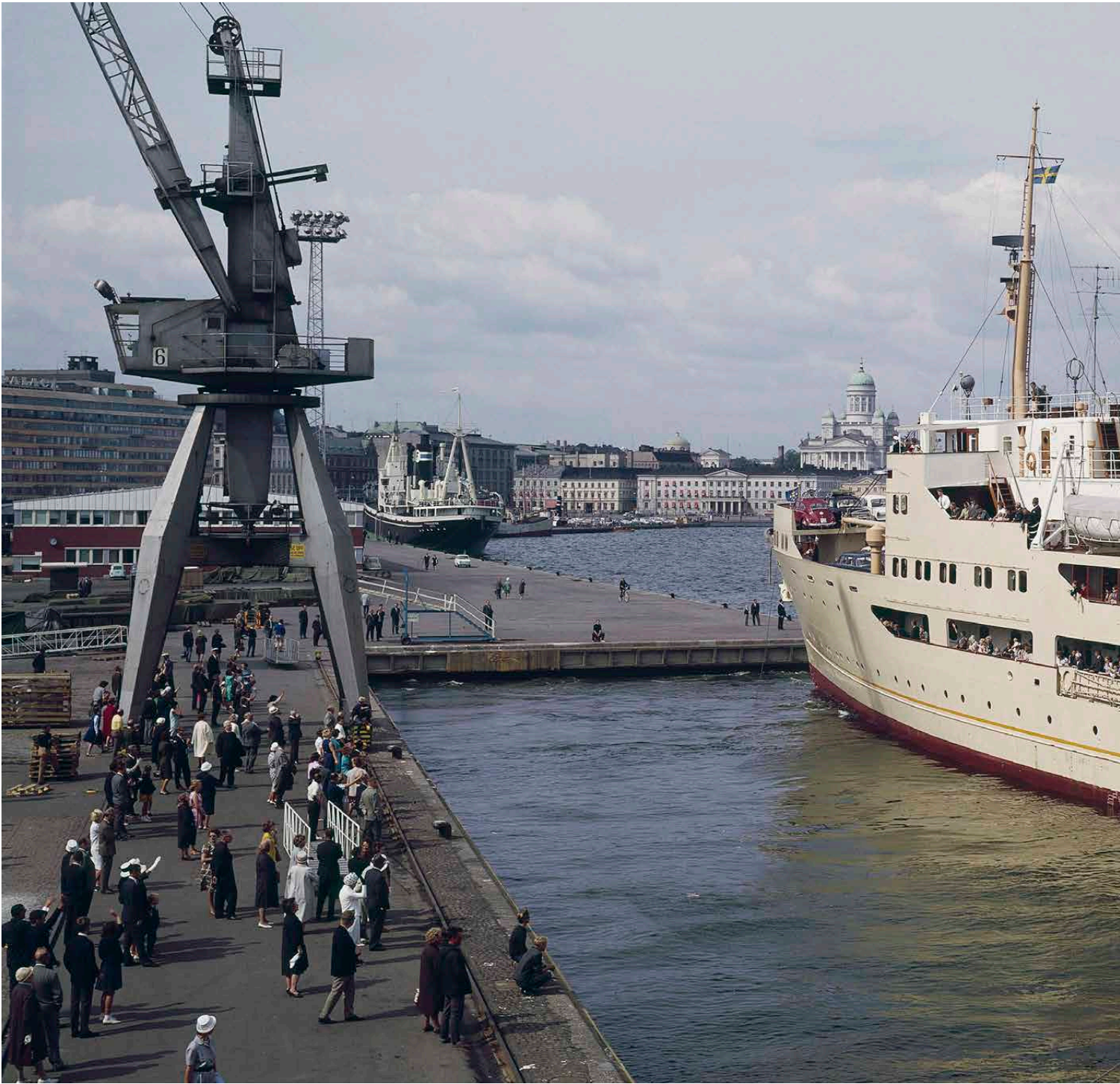
Sataman tunnusvärit. Helsingissä Eteläsataman länsipuolisen satama-alueen tunnisti hopeanharmaista nostureista. Kuvan nosturi tilattiin Turusta Crichton-Vulcanin tehtaalta. Uudella nosturilla rahti saatiin nostettua suoraan tullivaraston yläparvekkeelle. Katajanokalla nosturikopit olivat sinisiä ja Jätkäsaaressa punaisia. Volker von Bonin, 1960-luku, HKM.
