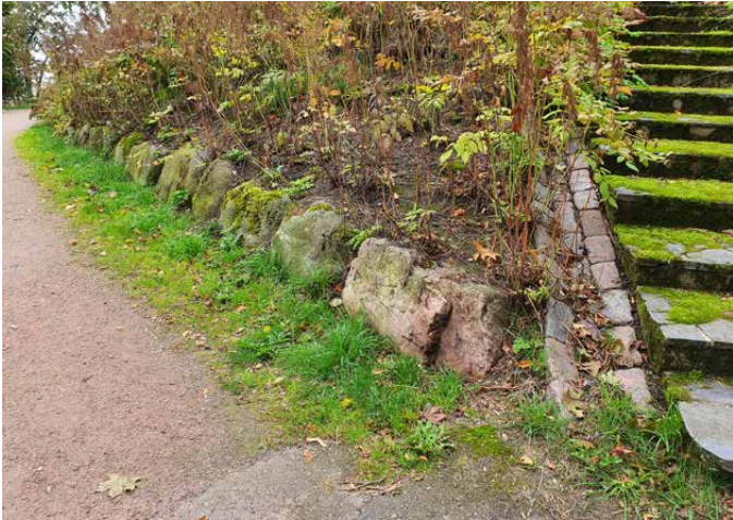
3. Perennaistutuksen pengerrys on tuettu käytävää vasten luonnonkivistä rakennetulla tukimuurilla. Vieressä liuskekivipintaiset portaat, joiden sivulla kulkee nupukivinen vesikouru.
