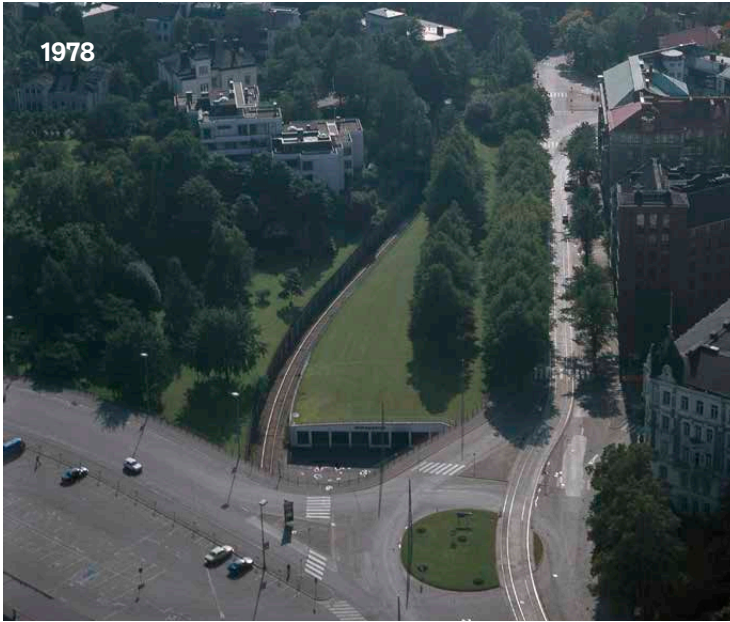
Kaupunkitilaan uurrettu kanjoni: Kaivopuisto II -tunnelista satamaan johtanut raide näkyy vuoden 1978 ilmakuvassa. Sky-Foto Möller, HKM 1978.
