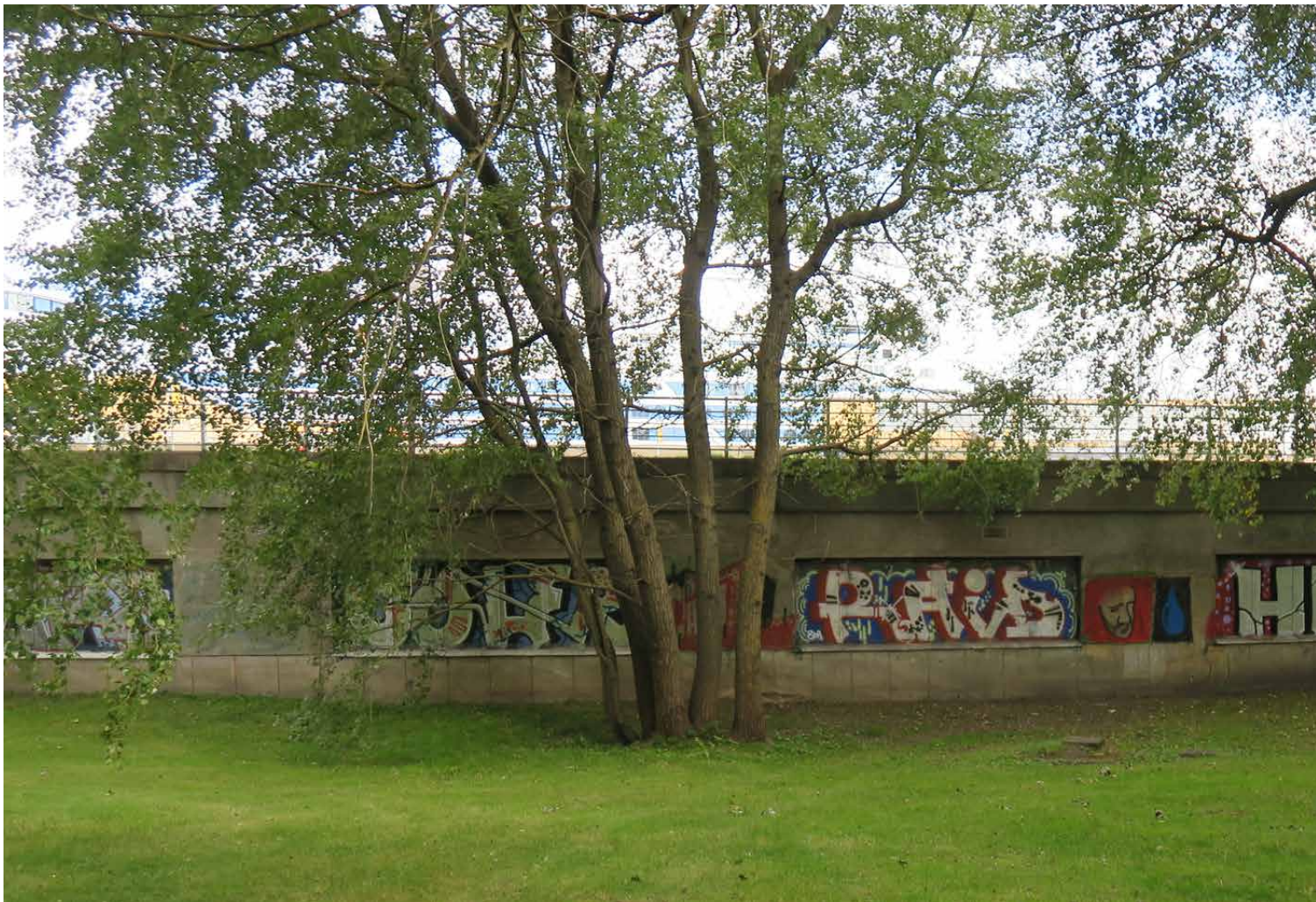
Entistä Valion vientijuustovarastoa (osa M2-rakennusta) kuvattuna Armi Ratian puistosta. Taustalla Olympiaterminaalin M1-matkustajapaviljonki. Kuva 2021.
