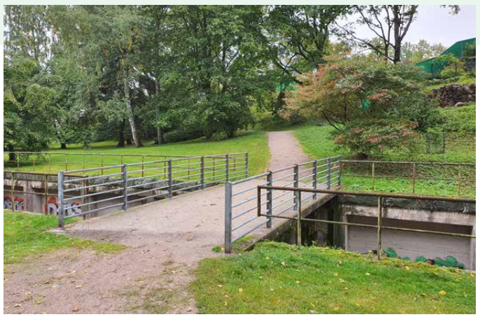
2. 1990-luvulla toteutettu silta on varustettu metallisilla putkikaiteilla ja puukannella.
