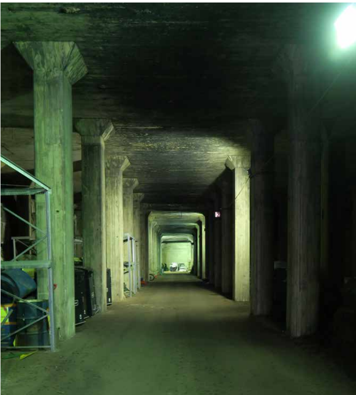
Kuva tunnelista vuonna 2021. Kuilu on Kaivopuiston päästä suljettu.
