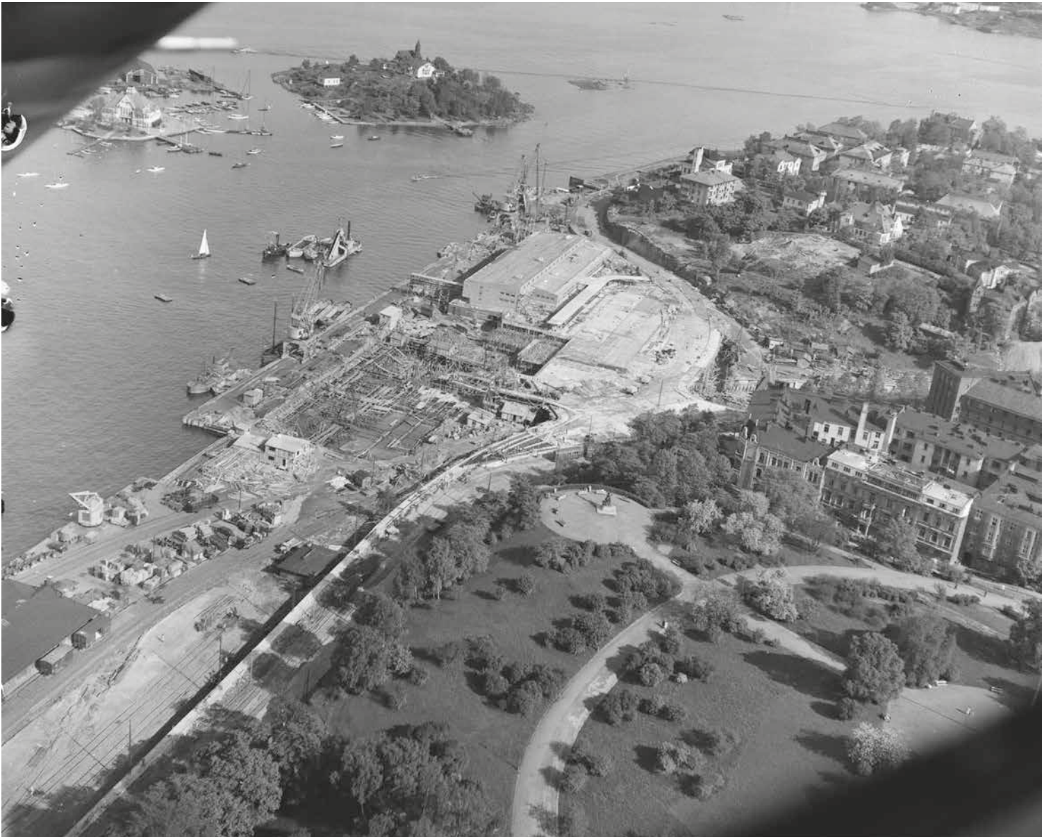
Vuonna 1952 otetussa ilmakuvassa ovat Olympialaiturin ja matkustajapaviljongin rakennustyöt vielä kesken. Hahmottumassa on suuri muutos; luonteeltaan julkisen matkustajaterminaalin valmistuminen yhdessä Ehrenströmintien
