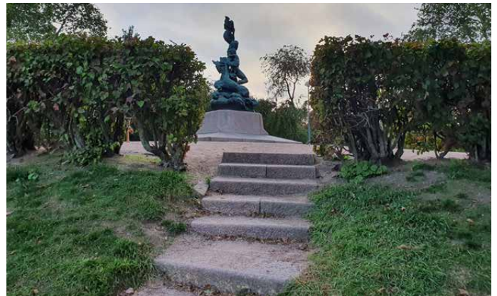
6. Näköalapaikalta pienelle kalliotasanteelle johtavat portaat on toteutettu todennäköisesti 1970-1980-lukujen aikana. Rakenne on yksinkertainen koostuen luiskaan asennetuista porraskivistä.
