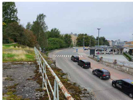
10. Itäreunan kalliioleikkaus, joka toteutettiin Ehrenströmintien rakentamisen yhteydessä.
