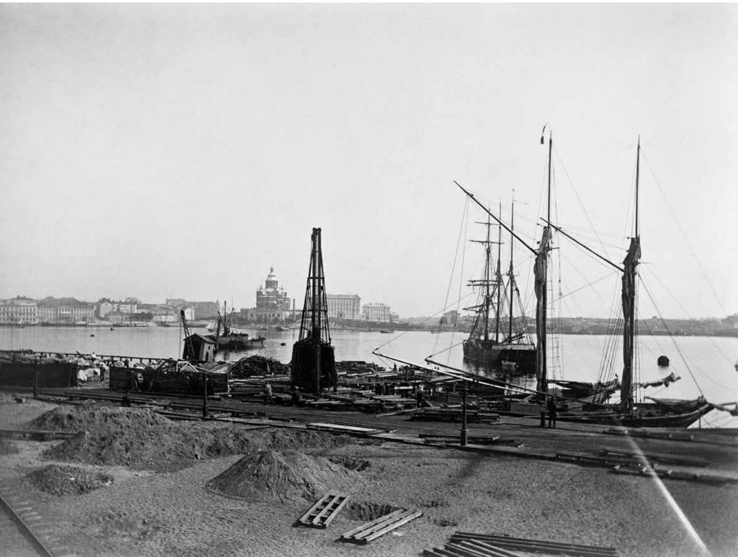
Kuva työmaavaiheesta 1889...: Makasiinilaituria levennetään ja puupaaluja junnutetaan kuvassa keskellä näkyvällä juntauskoneella. Kuvaaja tuntematon. HKM.
