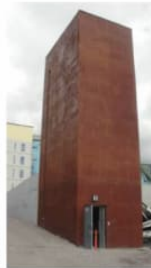
1 Juvanpuiston betoniseinä sai kuparin avulla värin.
