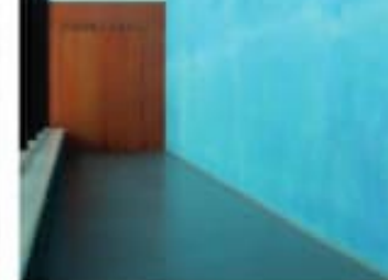
1 Juvanpuiston betoniseinä sai kuparin avulla värin.
