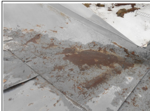
Korroosiovaurioita peltikatteessa
