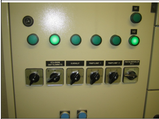
Saattolämmityskaapelin ohjauskytkin
