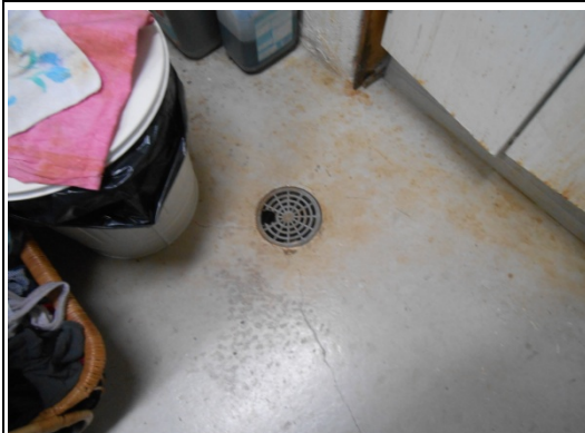
Alapohja ateljeetilan kohdalla, lattiakaivo
