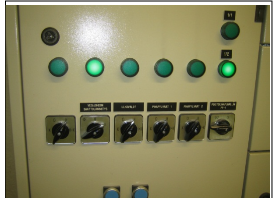
Ulkovalaisimien ohjauskytkimet
