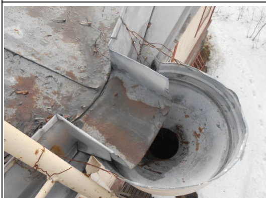
Syöksyputken suppilo, jalkarännin ulosheittäjä
