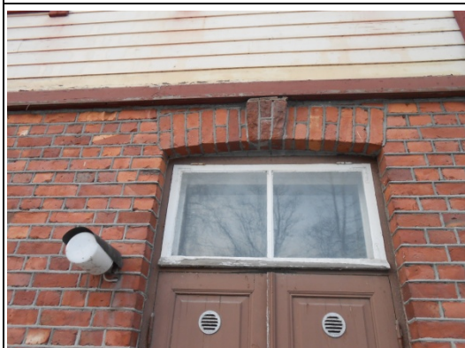
Tuloilmaventtiilit ulko-ovessa
