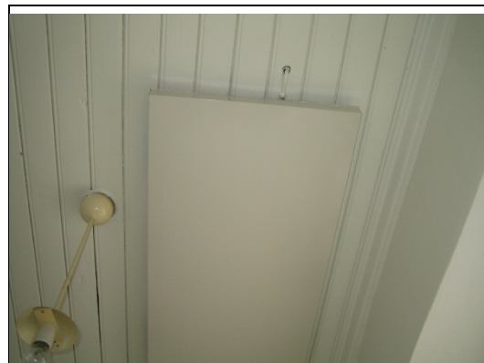
Kattolämmityselementti
