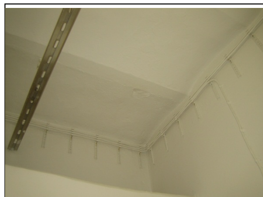
Valaisinripustuskisko ja ankkurikiinnityksiä
