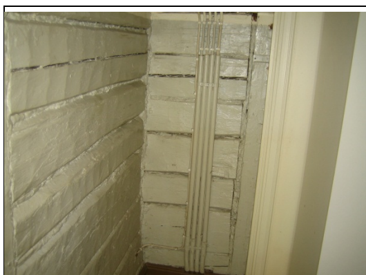
Putkiasennukset seinäpinnassa
