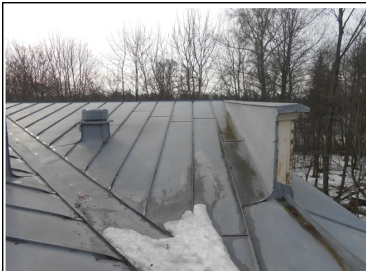
Rivisaumapeltikatteen sisäjiiri
