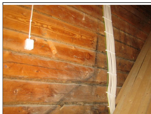
Johtokiinnike-asennuksia
