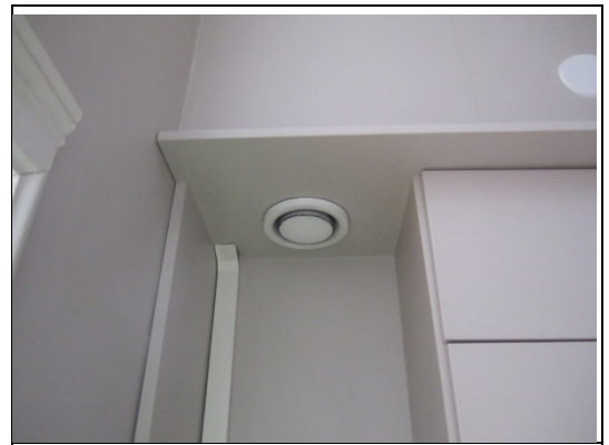
Toimistohuoneen poistoilmaventtiili
