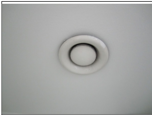
Kellaritilan poistoilmanvaihtventtiili
