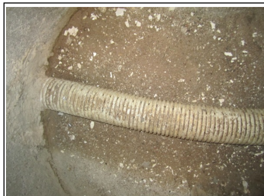
Rakennuksen alapohjan kohdalla olevassa tarkastuskaivossa salaojaputki esillä, salaojaputken ympärillä hienojakoinen maaines
