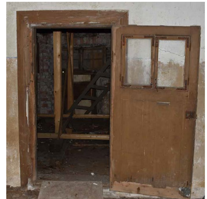
Navetan ja sikalan väliovi, kuvattuna navetan puolelta.
