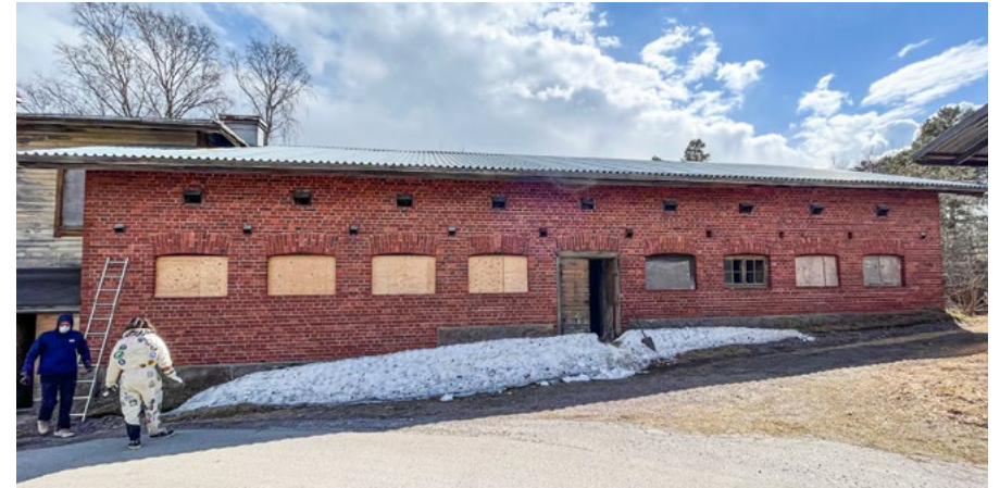
Navetan puolen luoteisjulkisivu, 9 tuloilma-aukkoa ja 10 pientä tuuletusaukkoa.
