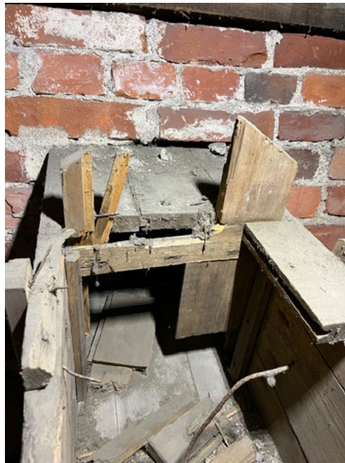
D) Jääne ilmanvaihtolaatikon säätölevystä.
