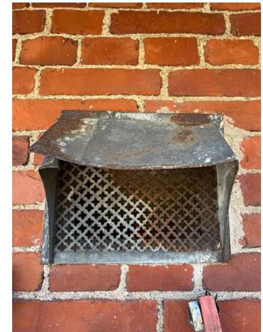
B) Tuloilmakanavan säleikkö julkisivussa.
