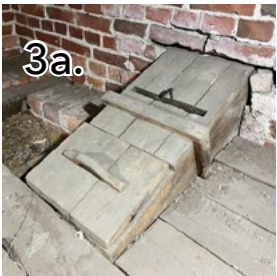
2. tuloilmakanavien säätömekanismi
