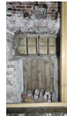
7. Ulompi tippanokallinen puite on siirretty sisäpuolelle
