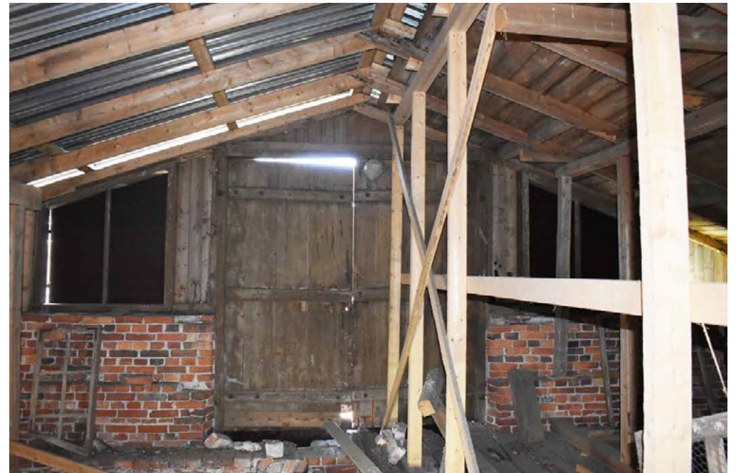
Vintin pääty sisältä
