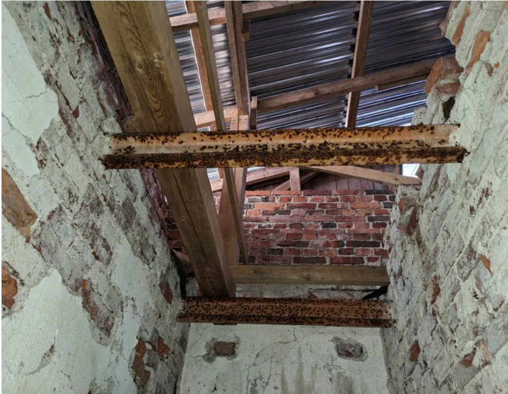
Lantalaan johtavan käytävän yllä on kolme 120 cm välein kiinnitettyä ratakiskoa, jotka ovat ilmeisesti kannatelleet muurattuja kappaholveja.
