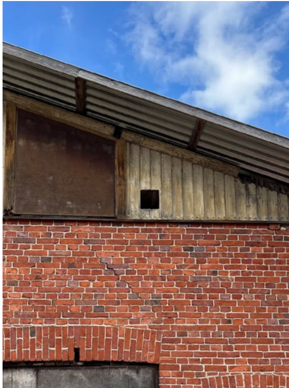
K) Rehuparven tuloilma-aukon suu näkyy lounaispäädyn julkisivun puisessa yläosassa.
