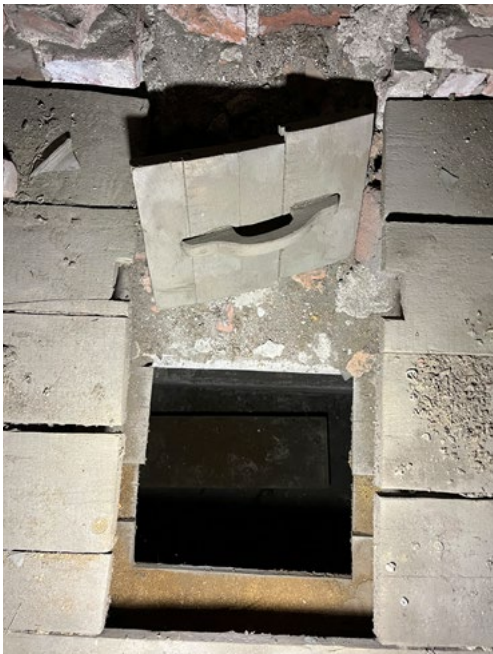
C) Reikä parvelta välipohjan läpi navettaan, järjestelmän laatikko ja luukku purettu.
