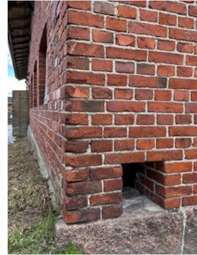
R) Tuuletusrakojen kivijalan tasolla olevat päätyaukot ovat mahdollisesti olleet peitetyinä vuodenajasta riippuen.
