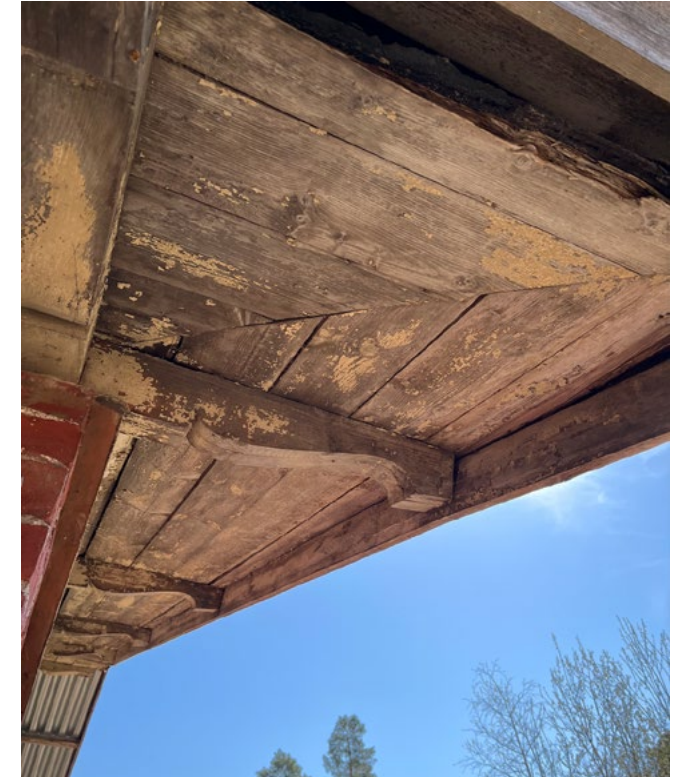
Lounaispäädyn kukkopuut on muotoiltu samaan tapaan kuin selkäpuiden päädyt.
