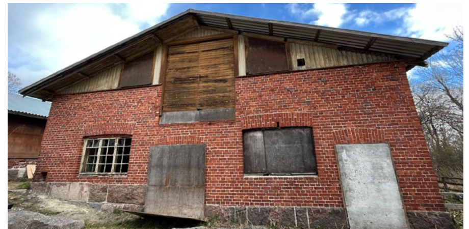
Karjarakennuksen päädyn lounaisjulkisivu, seinän eristeraon päätyaukko ja rehuparven tuloilma-aukko.
