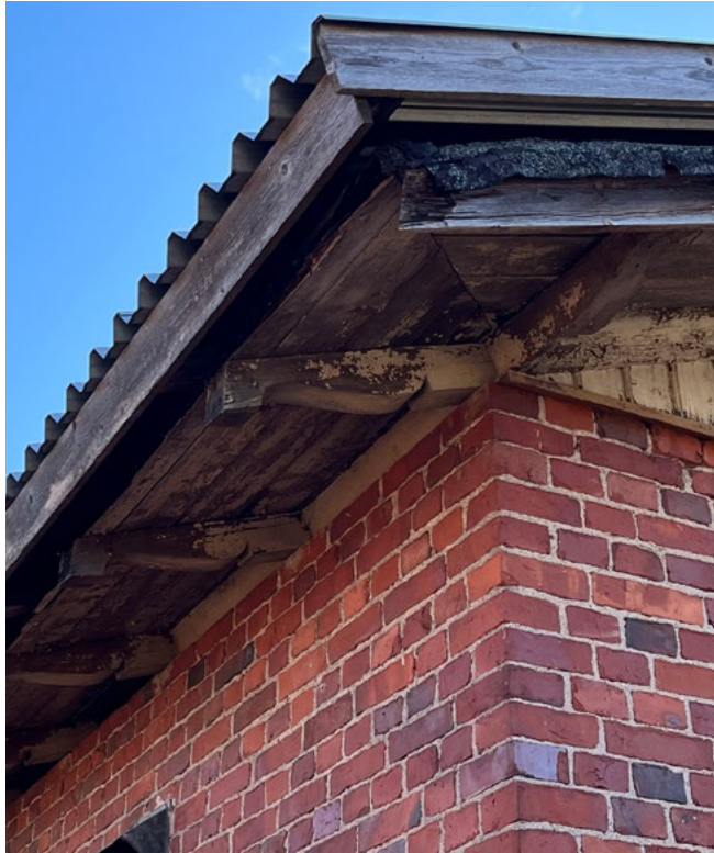
Selkäpuut jatkuvat ulos räystääseen koristeellisina räystääspuina.
