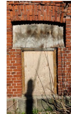
8. Ovi paikattu vanerilla
