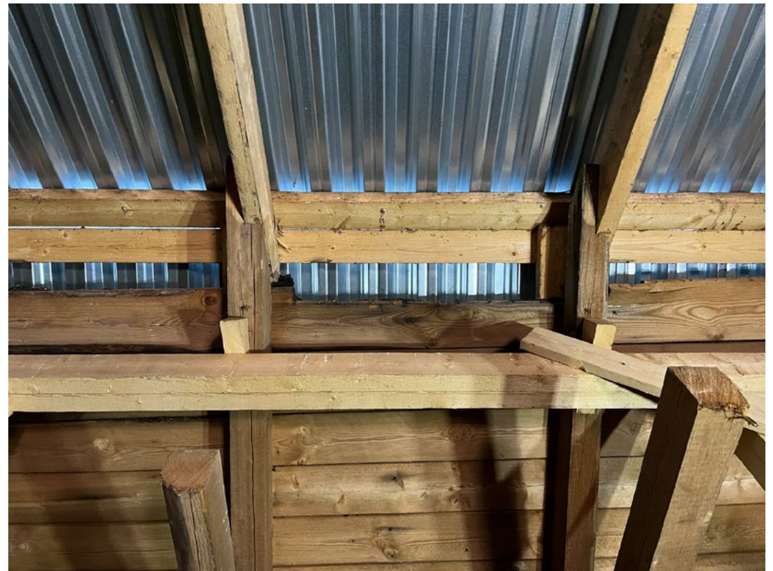
O) Jälkiä poistoilmatorvesta.
