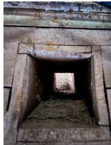
G) Puinen kanava sisältä ulospäin kuvattuna.
