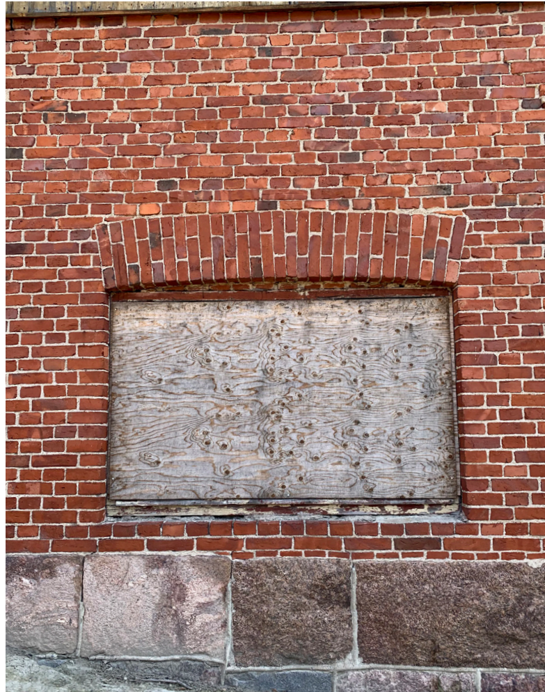
Kuva 12. Aukot tiilimuurissa on toteutettu pääosin holvaamalla lukuun ottamatta ilmanottoaukkoja. Ulkoseinien aukkojen alapinta on mieltein vaakasuora. Tämä valve tunnetaan nimellä venäläinen tiiliholvi (Neuvonen, Malinen & Mäkiö, 2002, 72.).
