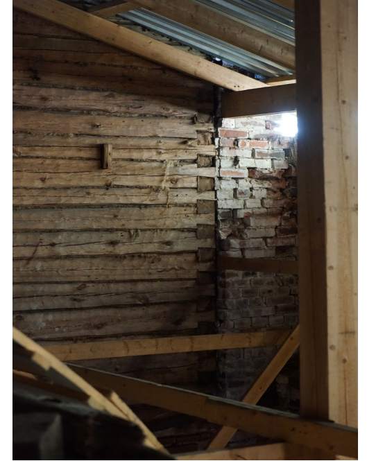
Kuva 19. Näkymä rehuparvelta sikalan ja karjakeittiön välistä hirsiseinää kohti. (Mattila, 2022). Hirsirungon nurkka on toteutettu lohennyrtöliitoksella. (2)
