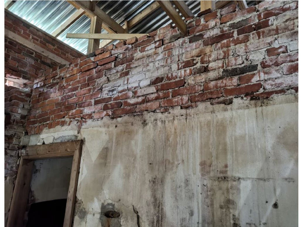
Sikalan lantalan puoleisen päädyn rappauksessa on yhä nähtävissä jäljet samanlaisesta kattolistasta kuin navetan puolella. Toisen päädyn hirsiseinässä vastaava lista on puolestaan säilynyt. Listojen sijainti ilmaisee sikalan entisen huonekorkeuden, joka on matalampi kuin navetassa.
