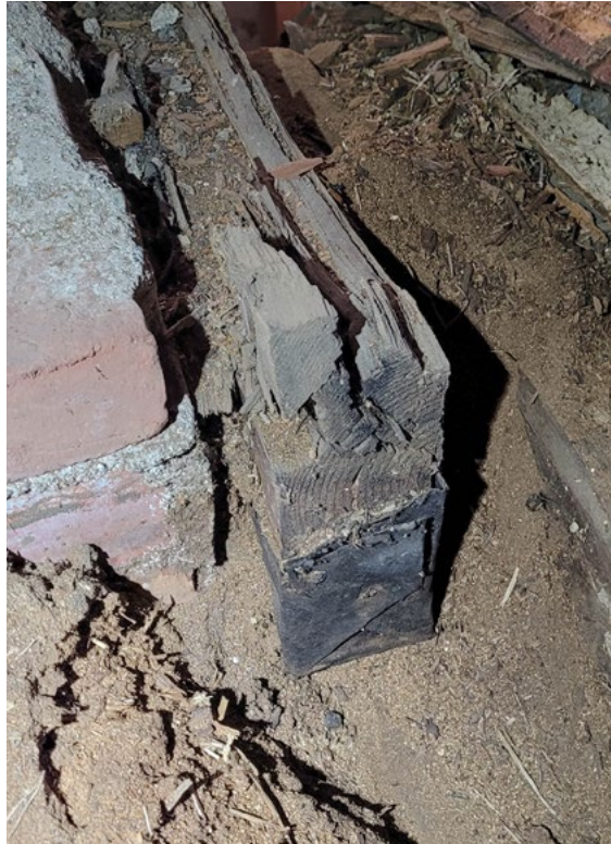
Navetan ylisillä on säilynyt osa välipohjaparrua, jonka pää on paketoitu parrun alle levitettyyn tervapaperiin.
