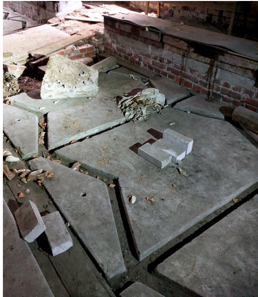
Kuva 28. Navetta-sikalassa on maanvarainen lattia. Avatuilta osin lattialaatan alle sijoittuu maatayttöä, joka vaikuttaa olevan multaa ja soraa. Käytävät ja lattiakourut eli lantalaarit (ks. piirros) on tehty betonista.
