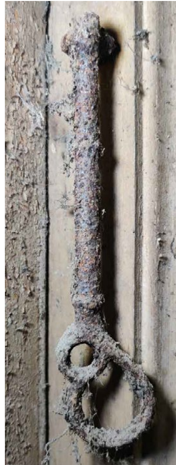
Ikkunan auki pitämiseen tarkoitettu myrskyhaka.
