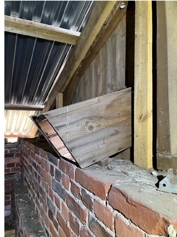
L) Puinen kanava on tuettu ulkoseinän tiilirakenteeseen.
