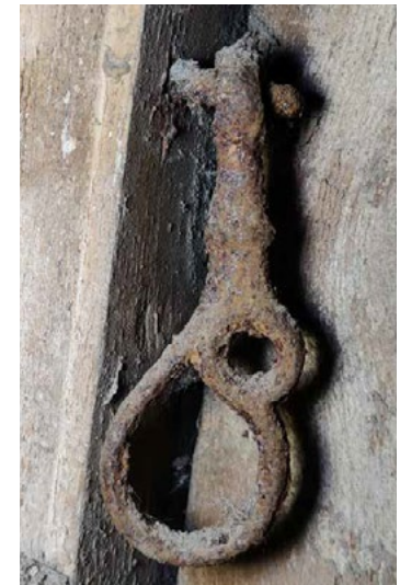
Ikkunan kiinni pitämiseen tarkoitettu myrskyhaka.
