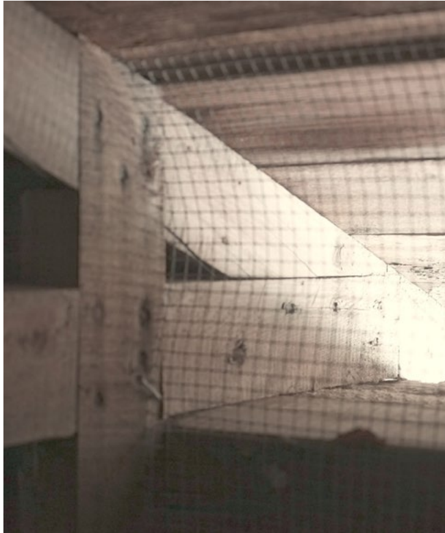
Kontin kaikki liitokset on toteutettu suorina lapaliitoksina. Kuva: Laura Mattila.
