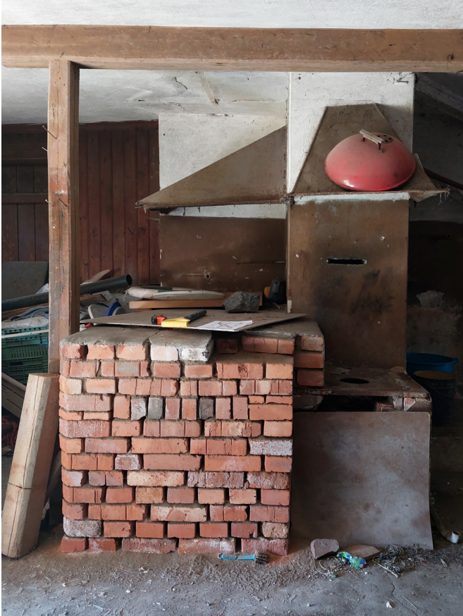
Kuva 20. Valokuvassa näkyy karjakeittiön tulisija. Tulisijan takana on yhden tiilen paksuinen palomuri. Palomuurin ja hirsiseinän (VS3) välissä on ilmarako, jotta palomuri ei missään kohdassa estä hirsiseinän painautumista. Piippu on rapattu. Karjakeittiön lattia on betonia.
