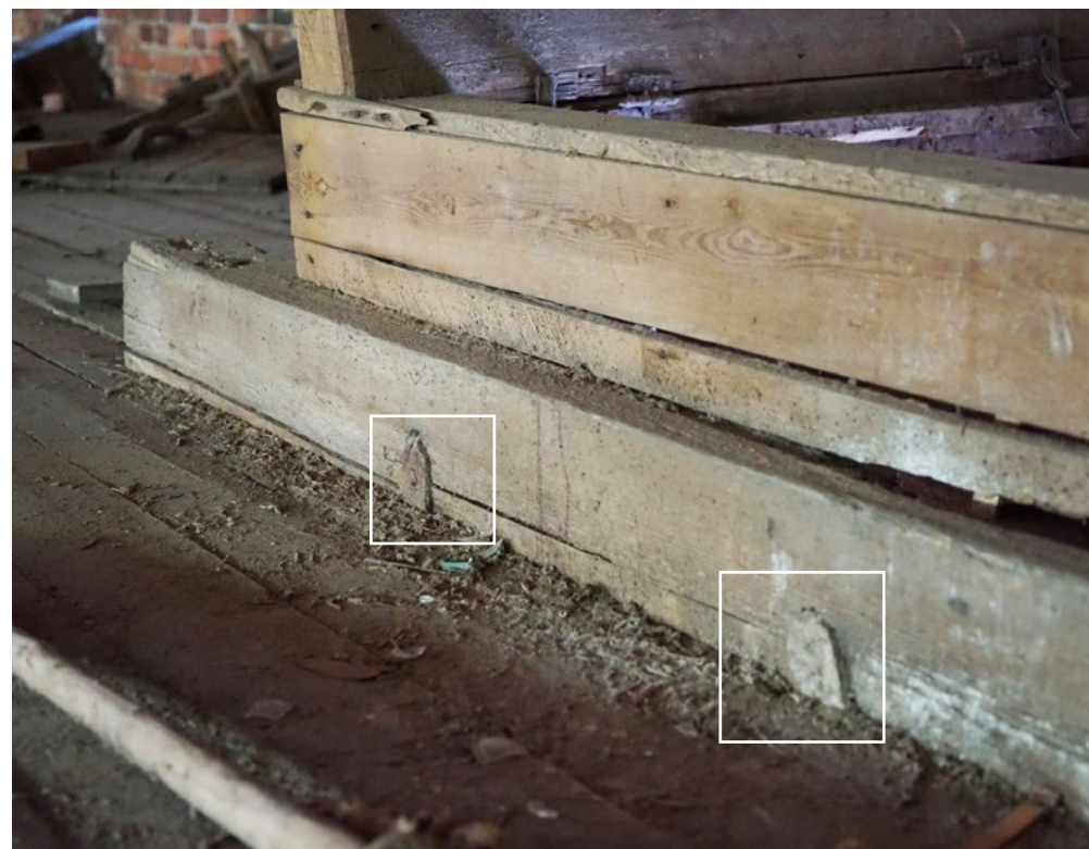
Katkaistut parrut on kiinnitetty tukihirteen metallisilla koukuilla. Kuva: Laura Mattila.
