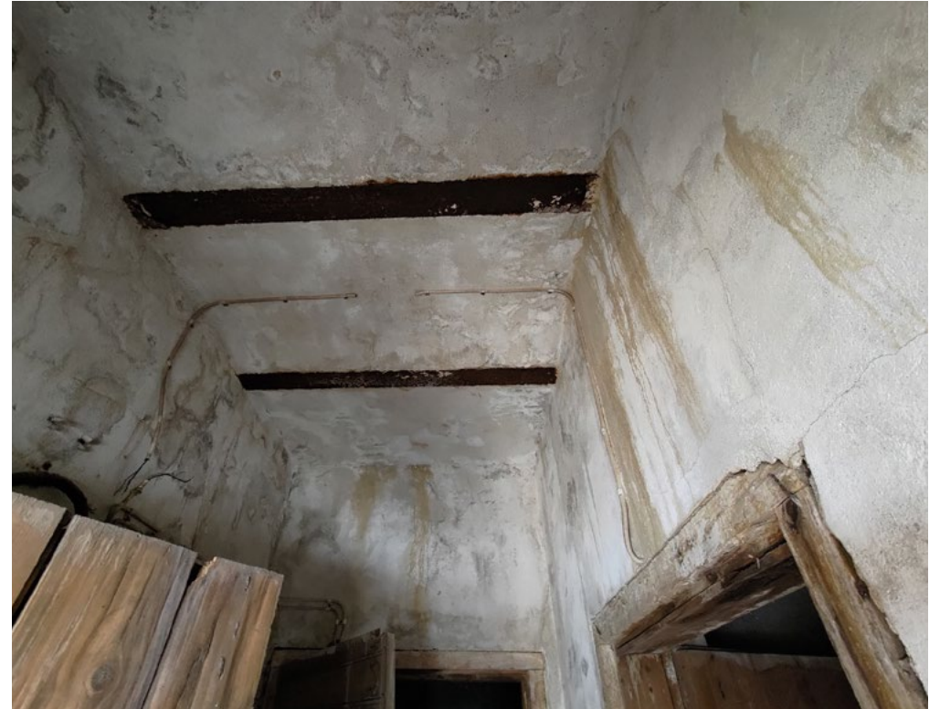
Viereisessä meijerirakennuksessa on ratakiskojen varaan tuettu kappaholvikatto, joka antaa käsityksen lantalaan johtavan käytävän katon mahdollisesta aiemmasta ulkonäöstä.
