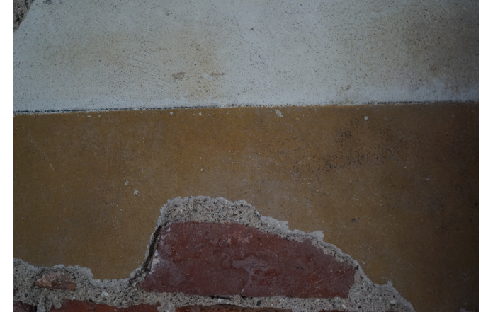
Kuva 22. Lähikuva rapatusta sisäseinästä. (Mattila, 2022). Navettasikala -rakennuksen tiiliseinien rappauksessa ja muurauksessa on käytetty ajan tavan mukaan mahdollisesti kalkkilaastia, joka on tehty seulotusta hiekasta ja sammutetusta kalkista. Rakennuksen rapatut sisäseinät on maalattu mahdollisesti kalkkimaalilla. Maalia on useita kerroksia.
