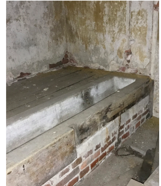
Kuva 30. Betoninen kaukalo eli ruokinta-astia muodostuu puisesta parrusta, jota vasten kaukalo on valettu. Tämä seisoo matalan tiilimuurin päällä. Betonisen kaukalon sisäpinta on sileäpintainen.
