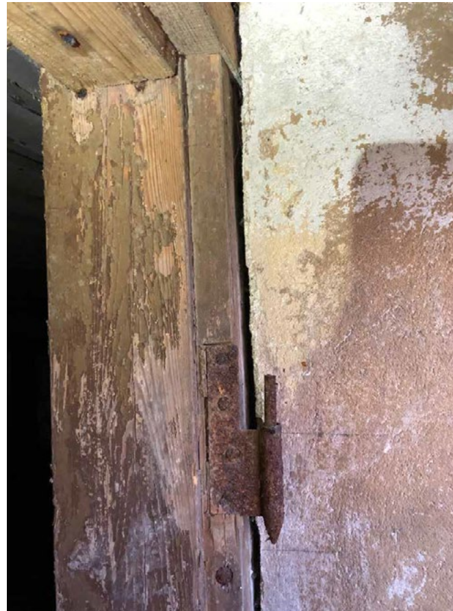
Sisäpuolista karmia ja vanha nostosarana
