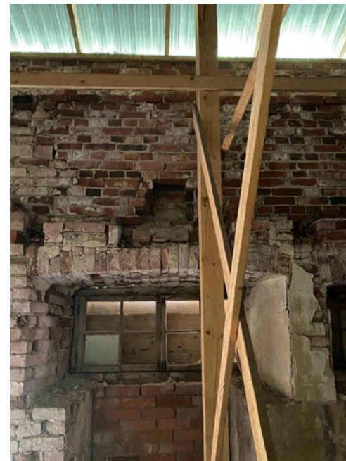
I) Osittain sortunut tuloilmakanava näkyy sikalan seinässä välipohjarakenteiden sorruttua.
