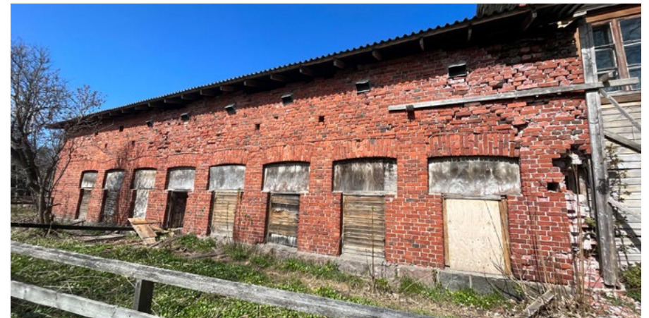
Sikalan puolen lounaisjulkisivu, 8 tuloilma-aukkoa ja 9 pientä tuuletusaukkoa, joista yksi on muurattu umpeen
