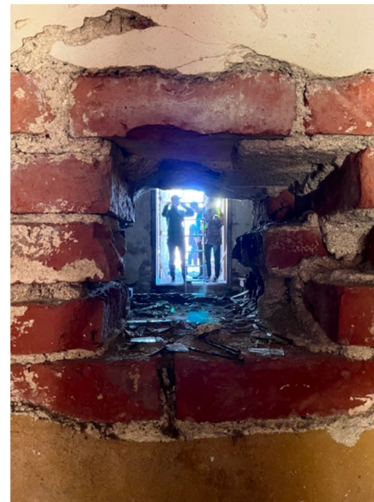
N) Navetan ja sikalan väliseinään tehty aukko.
