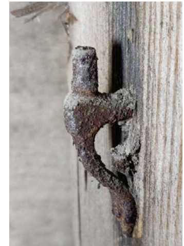
Ikkunan karmissa oleva sormihaka joihin (puitteisiin kiintetyt) myrskyhaat kiinnittyvät, lukiten puitteen position.
