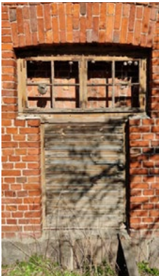
1. Ikkuna muurattu sisäpuolelta umpeen, puitteet jätetty ulkopuolelle
