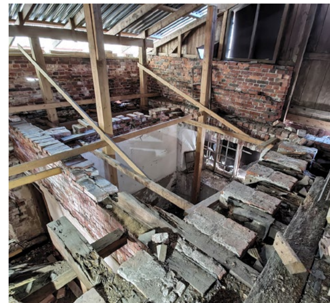
Karsinan kohdalla väliseinä kannattelee sekä karsinan että navetan välipohjaparruja. Karsinan puoleiset parrut ovat ohuempia (ks. periaatekuva sivulla 16). Parrut on muurattu tiiviisti paikoilleen ja niiden päät on suojattu huolellisesti tervapaperilla.
