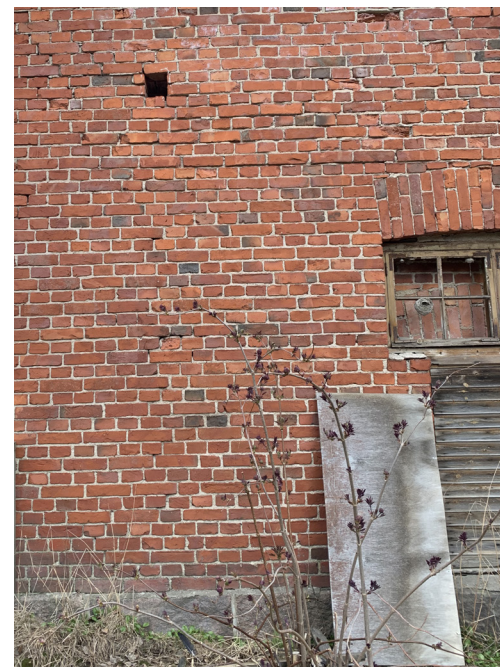
Kuva 9. Ulkoseinien täystiiliseinät on muurattu ristilimitykseen. Joka toisessa tiilikerroksessa on vain juoksukiviä ja joka toisessa sidekiviä. Ylemmän juoksukivikerroksen sauma kohtaa alemman kerroksen tiilen kiven keskellä. (1)
