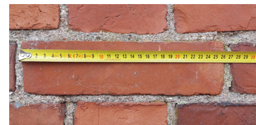
Kuva 11. Tiilen mitta on 270mm x 130mm x 60mm ja sauma vaihtelee 10mm ja 20mm välillä.
