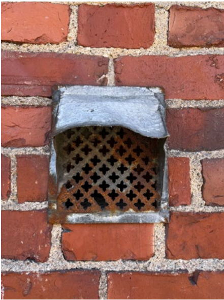
P) Tuuletusrakojen kanavissa on tuloilma-aukkojen tapaan julkisivulla selkeästi näkyvä ilmanvaihtosäleikkö.
