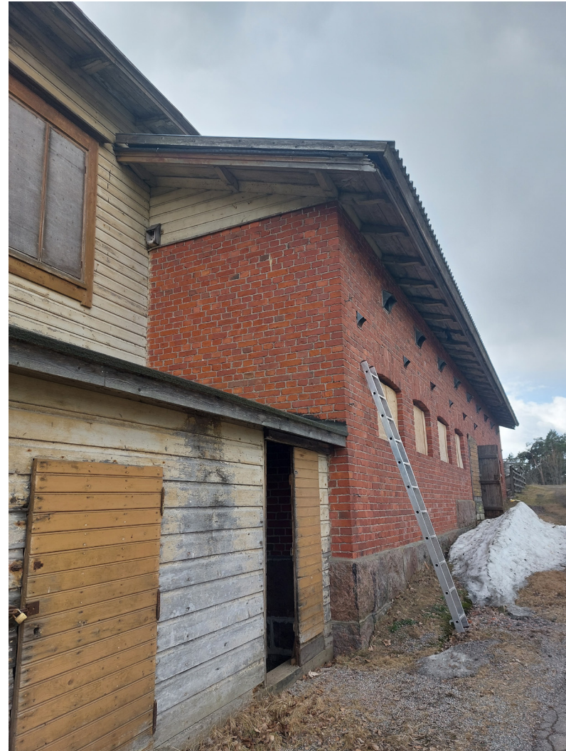
Kuva 8. Julkisivupääty koilliseen jossa navetta-sikalan tiiliseinä liittyy viereiseen hirsirakenteiseen karjakeittiö-asuinosaan.
