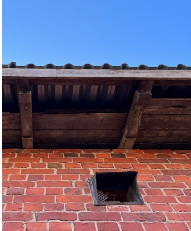
Alkuperäisen vesikaton suojaksi on rakennettu uusi profiilipeltikate.
