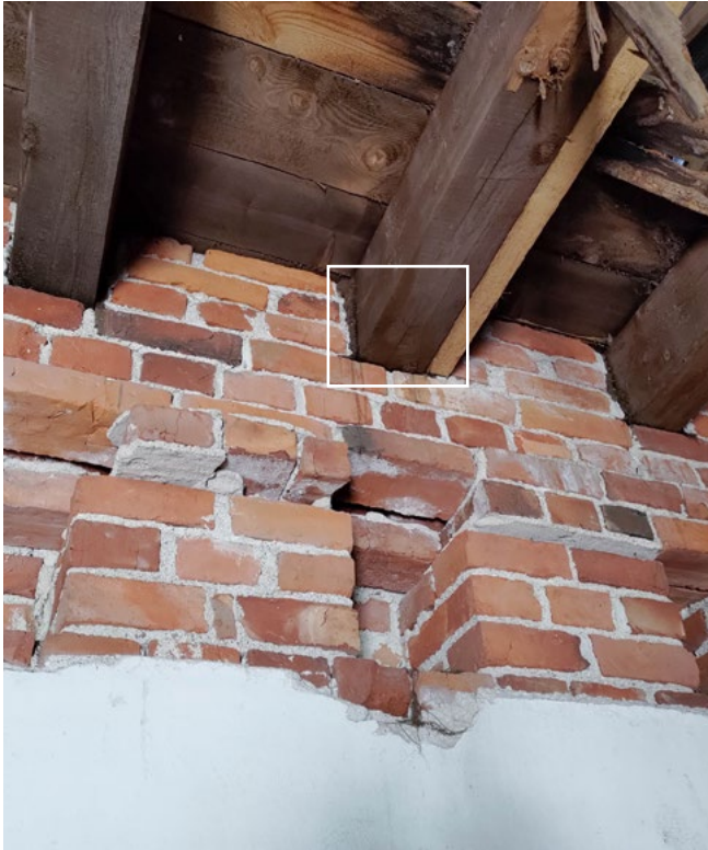
Tiilimuurauksen ja puuparrujen kosketuskohdissa näkyy tervapaperia, jolla palkit on eristetty tiilimuurista.
