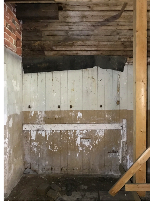
Kuva 18. Hirsiseinä on paneloitu sikalan puolella 2300 mm korkeuteen asti, minkä jälkeen hirsiseinä jatkuu suojaamattomana. Panelointi on maalattu samalla periaatteella kuin rappaus viereisillä seinillä. Yläosa on maalattu valkoiseksi ja alaosa tummemmalla kellertävällä okran sävyllä. (1)
