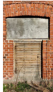
5. Oviaukko muurattu sisältä
