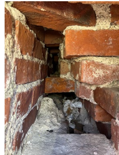
S) Lounaispäädyn tuuletusraon alaosa kivijalan yläpuolella.
