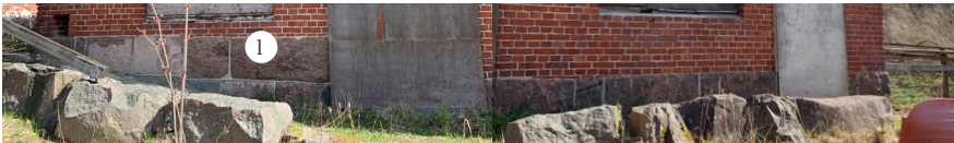
Kuva 23. Valokuvassa näkyy maaston ja kivijalan korkeusero navetta-sikalan lounaisjulkisivussa.
