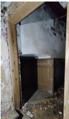
1. Ikkuna muurattu sisäpuolelta umpeen, puitteet jätetty ulkopuolelle
