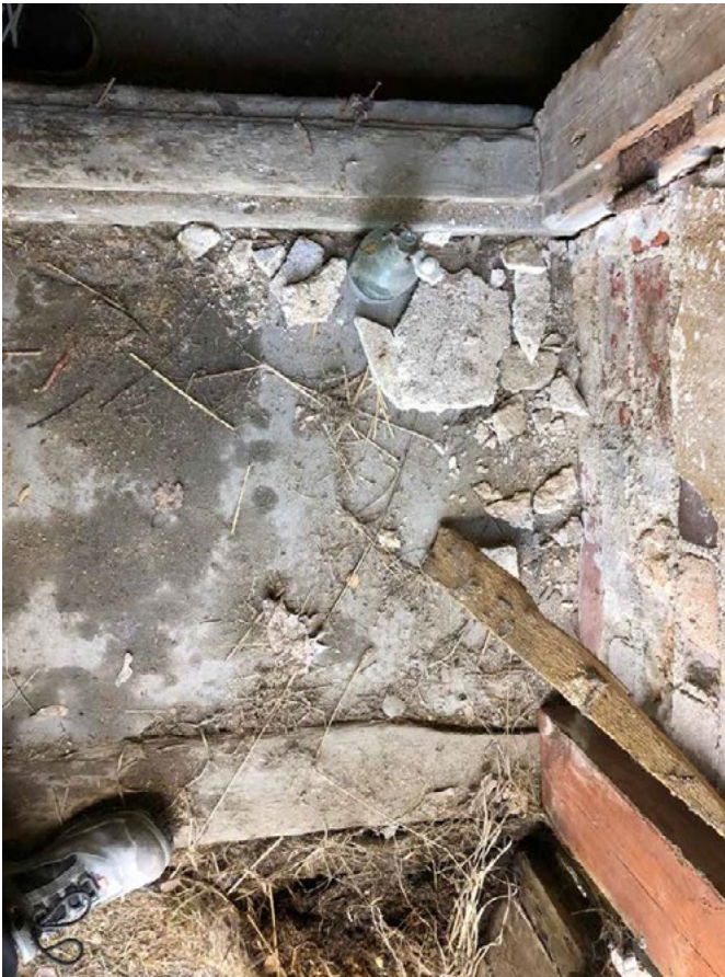
Kynnykset, ylhäällä sisäpuoli, alhaalla ulkopuoli
