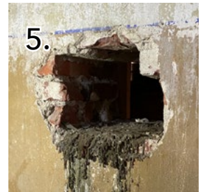
5. sikalan ja navetan väliseinän aukko
