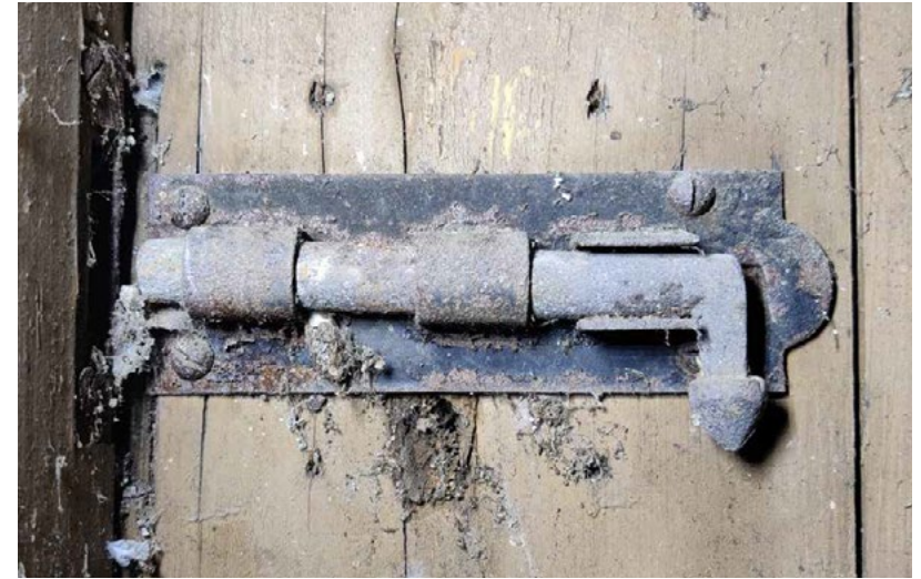
Sikalan ulospäin avautuvien ovien sisäpuolella oli salvat ovien lukitsemiseksi. Salvat muoto muuttuu pyöreästä (kuvassa vasen pää) nelikulmaiseksi (kuvassa oikea pää)
