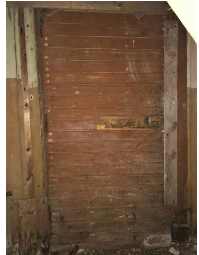
Sikalan ja karjakeittiön väliovi, kuvattuna sikalan puolelta.
