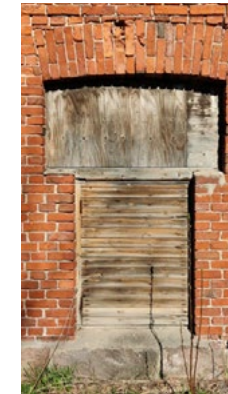
7. Ulompi tippanokallinen puite on siirretty sisäpuolelle
