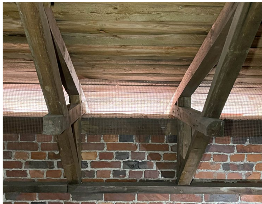
Konttipuu, selkäpuu ja käpälä tukeutuvat pitkittäisiin jalasparruihin 830–980 mm välein. Kuva: Laura Mattila.
