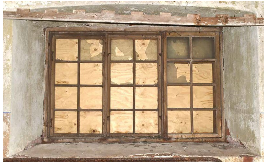
Ikkunatyyppe 2 sisältä. Ikkunasta oli säilynyt ainoastaan oikean puoleinen sisäpuite sisältäpäin katsottaessa.
