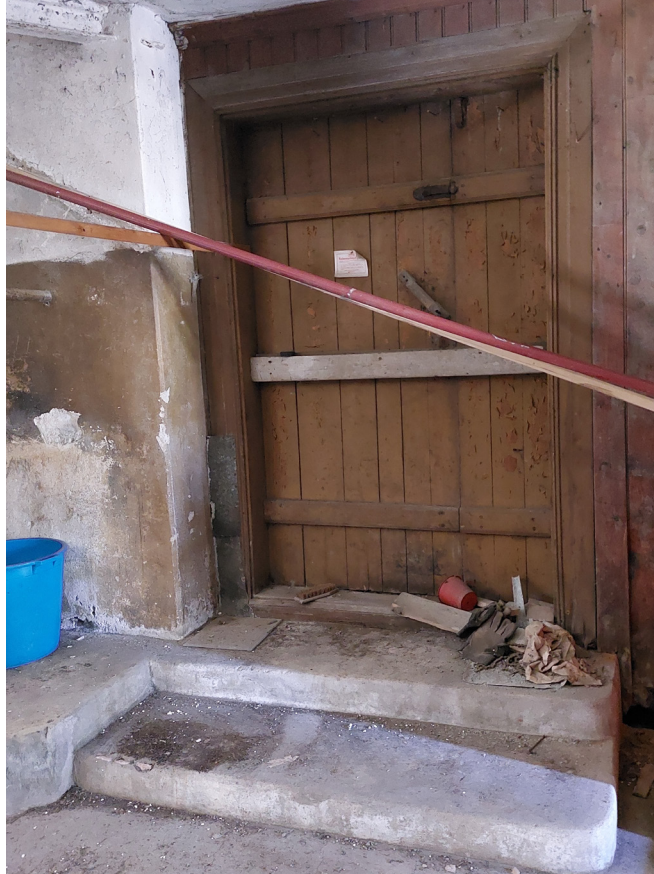
Kuva 21. Valokuvassa näkyy karjakeittiön ja navetan välinen väliovi. Hirsiseinän panelointi on koko huoneen korkuinen (noin 2630 mm) karjakeittiön puolella. Rapattu palomuuriseinä on maalattu. Sen yläosa on maalattu valkoiseksi ja alaosa tummimmalla keltaokran sävyllä.
