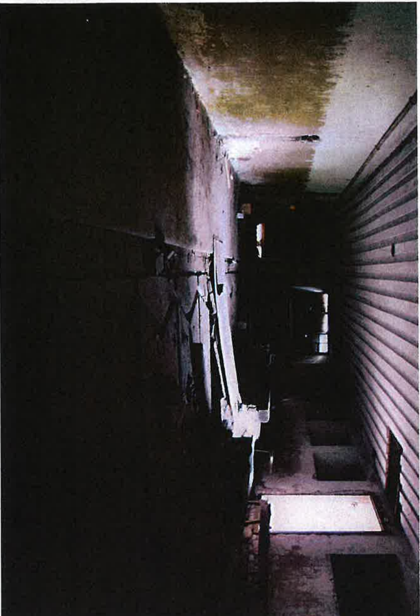
Navetan valettu lattia on edustanut aikansa navettarakentamisen huippua. C2. TUUKKA PÄIVÄRINNE
