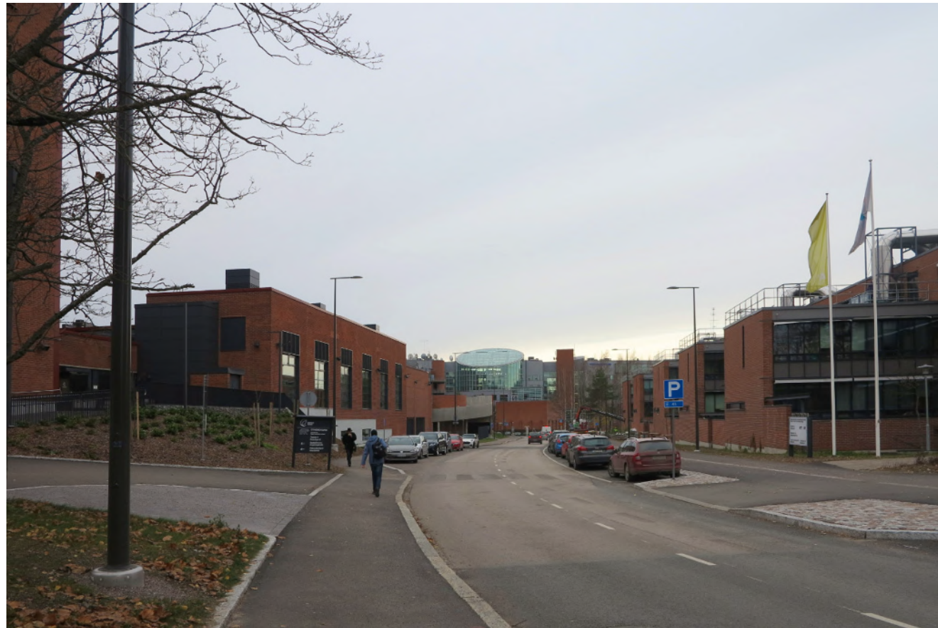
Tietotien kaupunkikuvaa rytmittävät ja rajaavat punatiiliset matalahkot rakennukset. Tien päätteenä idässä korostuu Innopoli I aulan lieriömäinen lasirakenteinen valokatto.
