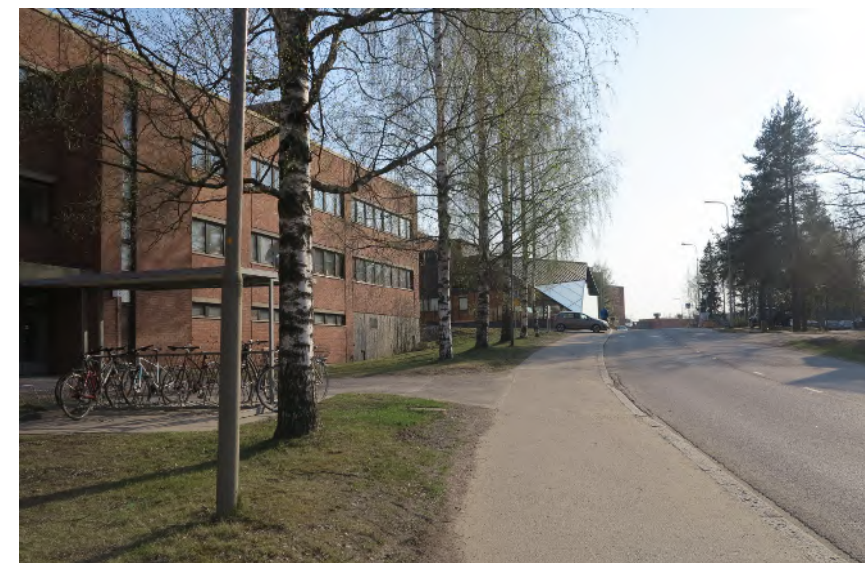
Tietotien varressa taustalla näkyy metroaseman pohjoinen sisäänkäynti.
