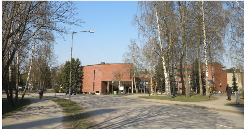
Sähkötekniikan korkeakoulun rakennuksen kaartuva pääty on katukuvassa tunnusomainen.
