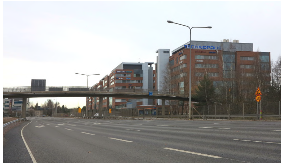
Innopoli 3(c), nykyinen Technopolis muodostaa Kehä I suuntaan muurimaista rakennetta
