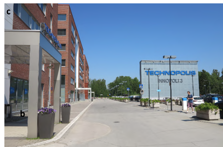
Innopoli 3 sisäänkäynnit avautuvat kansipihalle.
