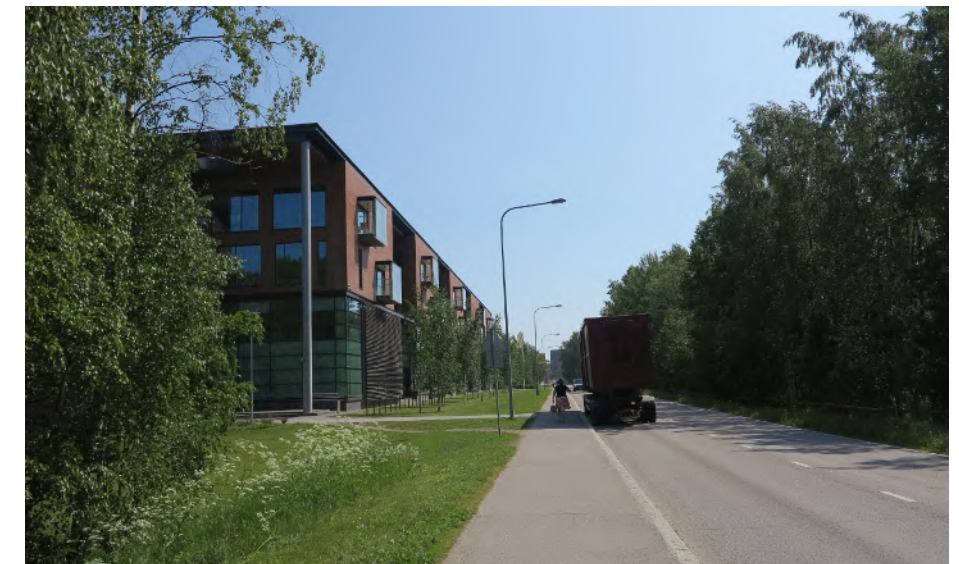
Maarintietä pitkin avautuu pitkä näkymä TKK:n päärakennusta kohden.
