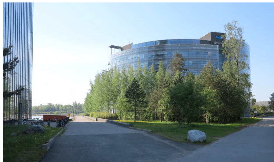
Rakennuksen pohjoispuolella on pieni hyvin tiivis metsikkö.
