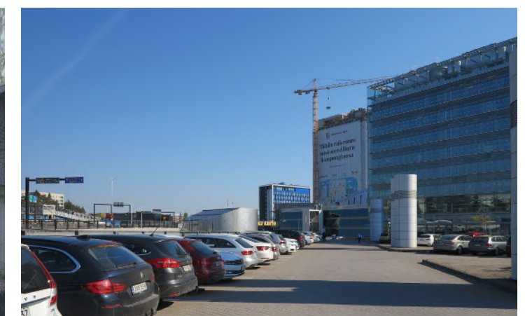
Rakennusten välissä on laajoja pysäköintikansia. Taustalla näkyy Radiolinjan ja Nesteen rakennukset.
