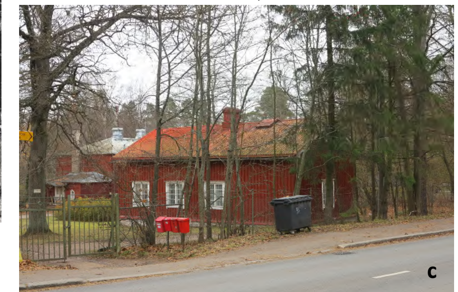
Tekniikantien varressa on vanha pieni asuinrakennus, ns. Torpet.
