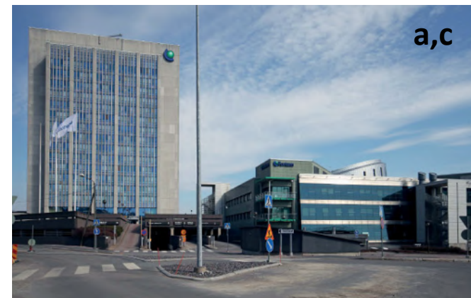
Nesteen torni ja Keilasatama 2 vuonna 2014. Vuonna 2019 oli Nesteen tornissa meneillä laaja julkisivukorjaus ja koko rakennus oli peitetty suojakankain.
