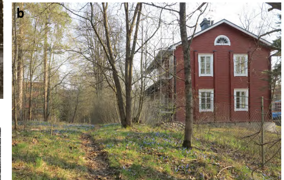
Pihan länsireunan osittain kaksikerroksinen työväenasunto.
