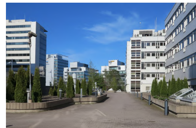
Valokehän laajaa kansirakennetta jakavat istuskaukalot ja korttelien välinen aitarakenne.
