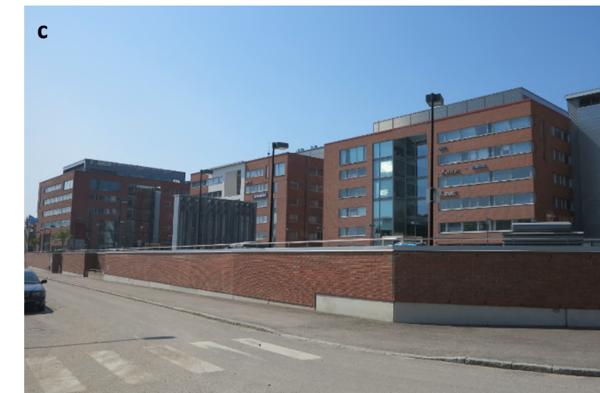
Vaisalantietä rajaa Innopoli 3:n kansipihan punatiilinen seinämä.
