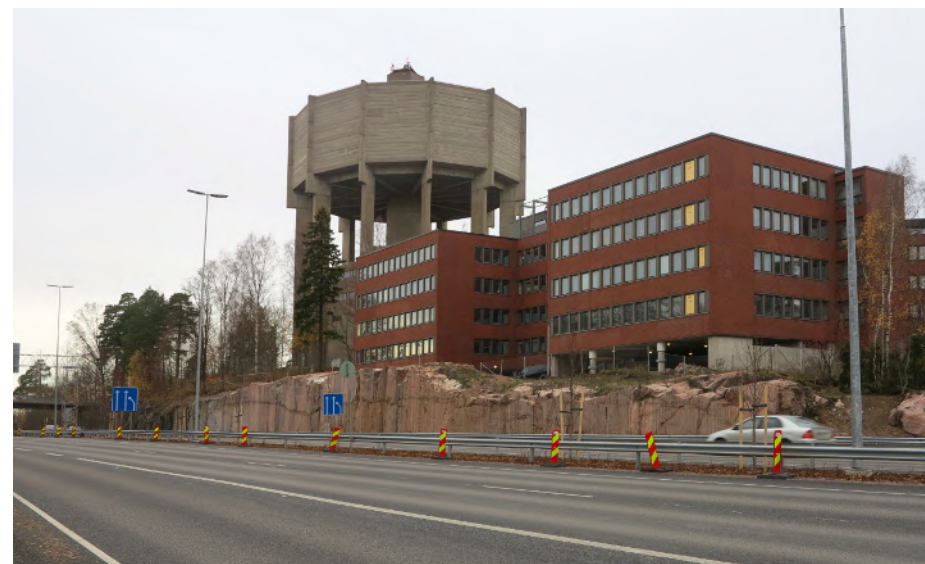
Alueen eteläosa rajautuu kalliroleikkauksena Kehä I suuntaan. Näkymää hallitsee korkea massiivinen vesitorni.
