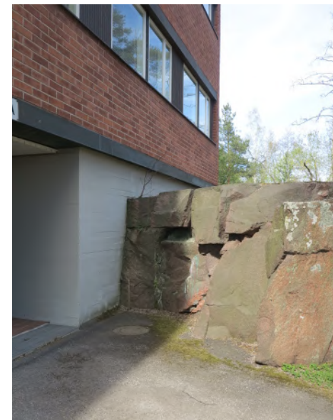
Kalliota on paikoin säilytetty aivan rakennusten seinustoilla.
