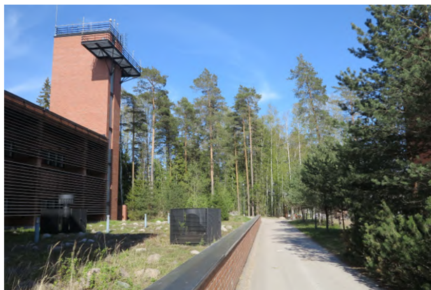
Tunnelma alueella on paikoin metsäinen, joskin edustan puusto on harva ja siten muutoksille herkkä. Mittatekniikan keskuksen torni parvekkeineen on paikallinen maamerkki. Näkymä Tutkijanpolulta.
