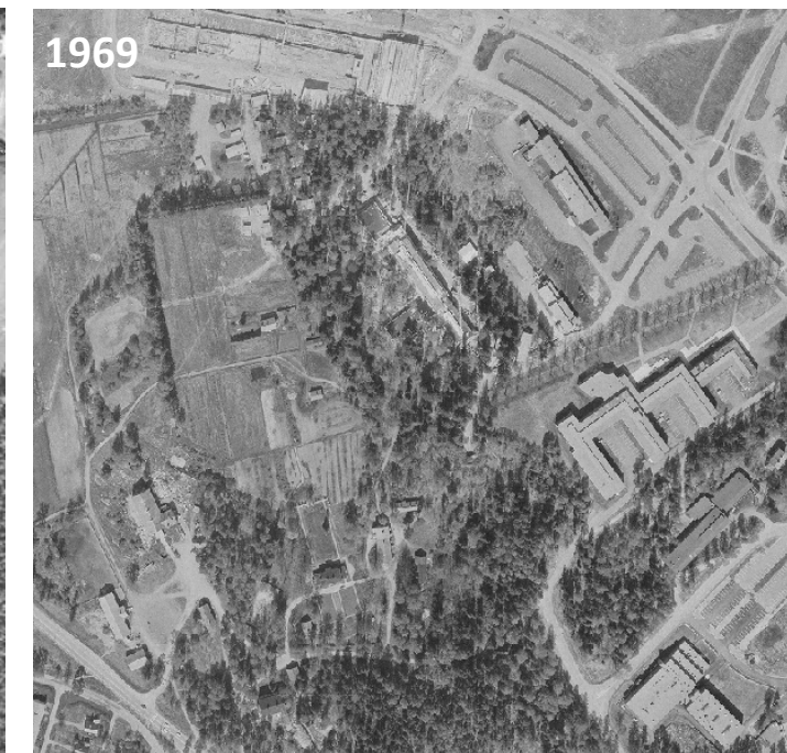
Edelleen vuonna 1969 oli Hagalundin kartanon ympäristössä paljon talousrakennuksia, mutta itäpuoliset alueet olivat jo täysin muuttuneet kampusalueen rakentamisen myötä.
