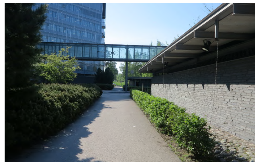
Pihaan tuo pienempää mittakaavaa runsaat istutukset ja sitä rajaava matala pyöräkatos, johon liittyy harmaa muurattu seinä ja ulkoneva katos.
