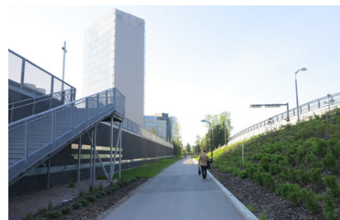
Kevyen liikenteen väylää rajaa tiiviisti pysäköintikannen rakenteet ja Hagalundintien pengerrakenteet.
