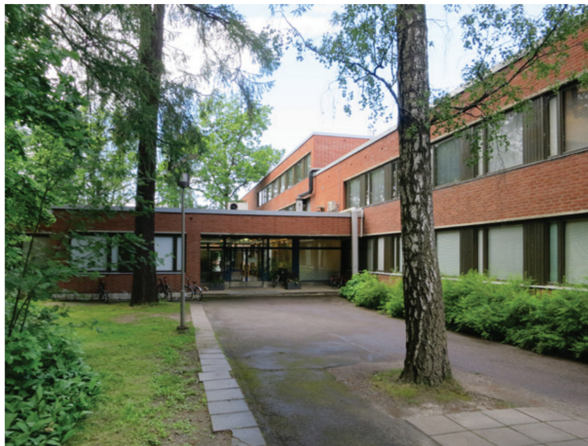
V7. VTT:n kemiallisteknisen laboratorion eli kemian laboratorion pääsisäänkäynti ja julkisivua Hagalundinpuiston suuntaan vuonna 2014.
