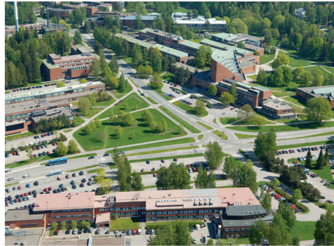
Korkeakouluaukio ja entinen TKK:n päärakennus vuoden 2010 ilmakuvassa, jossa etualalla VTT:n alue. AYA.
