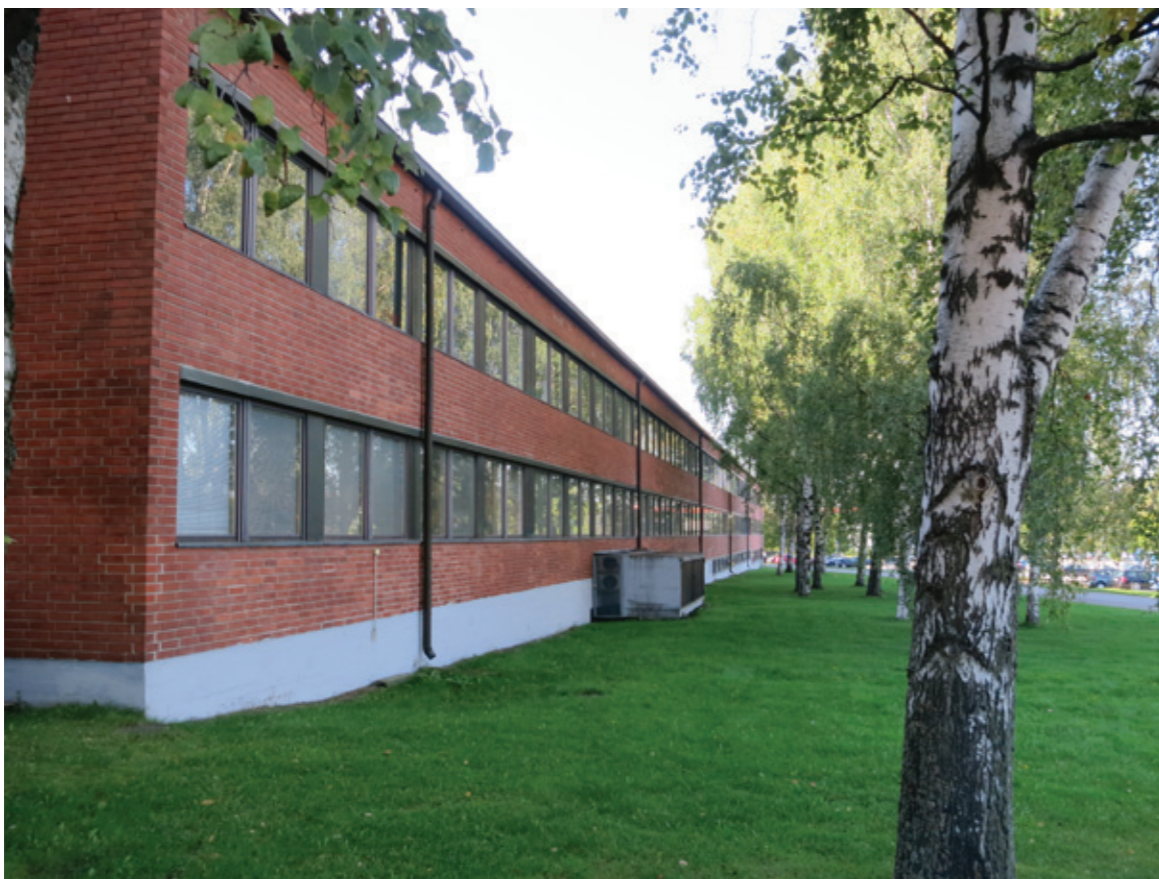
V3. VTT:n entisen elintarvikelaboratorion Otaniementien-puoleinen julkisivu vuonna 2014.
