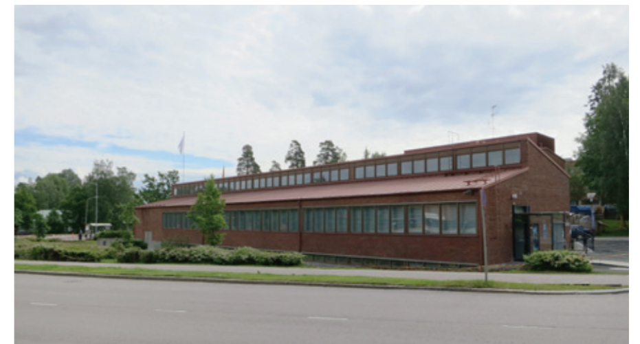
V1. VTT:n vuoritekniillisen laboratorion Vuorimiehentien-puoleinen julkisivu vuonna 2014, jolloin rakennuksessa sijaitsevat VTT:n esittelytilat ja viestintä. Rakennus tunnetaan myös VTT Valimona.
