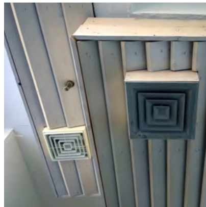
Neliömäisiä säleikköjä puualakatossa.
