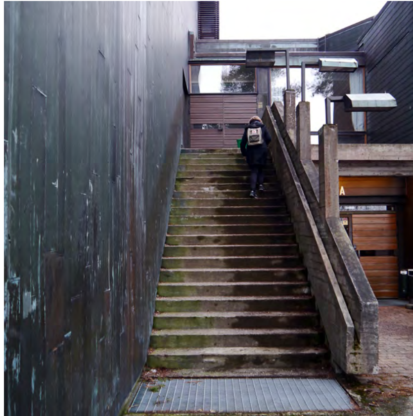
Porras Luolamieheen ja juhlasalin poistumiskäytävään. Käsijohteet on muotoiltu betonista.
