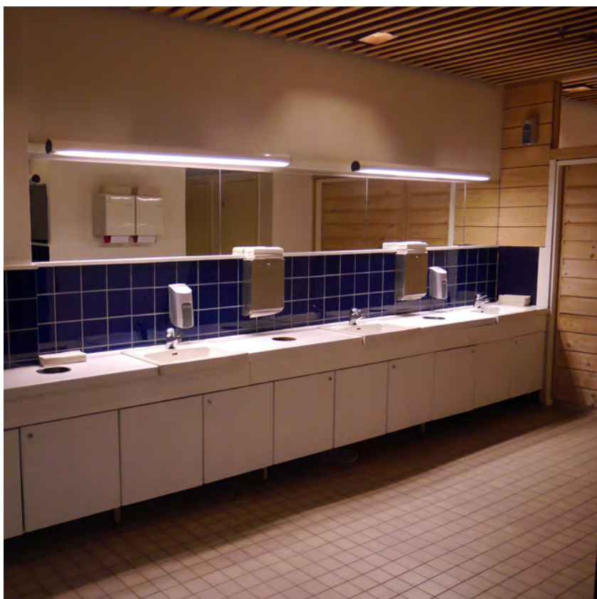
Yleisö-wc-tilojen kalusteet ovat luultavimmin 80-luvulta.
