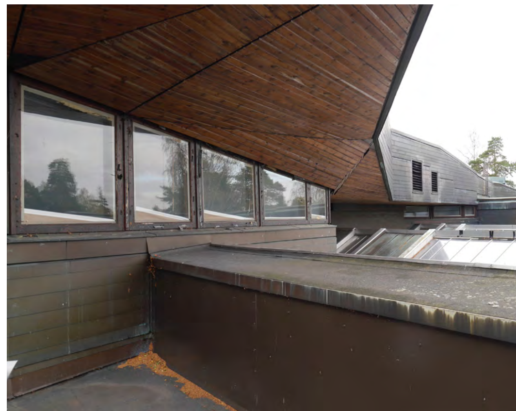
Suurten salien yläikkunat alemman katon päällä ovat pääosin alkuperäisiä.
