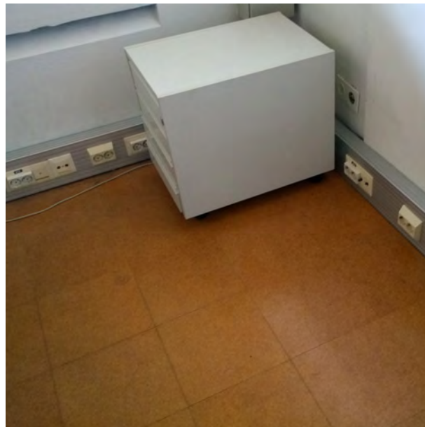
Toimistohuoneisiin on lisätty johtokouruja, jotka ovat usein lattianrajassa.
