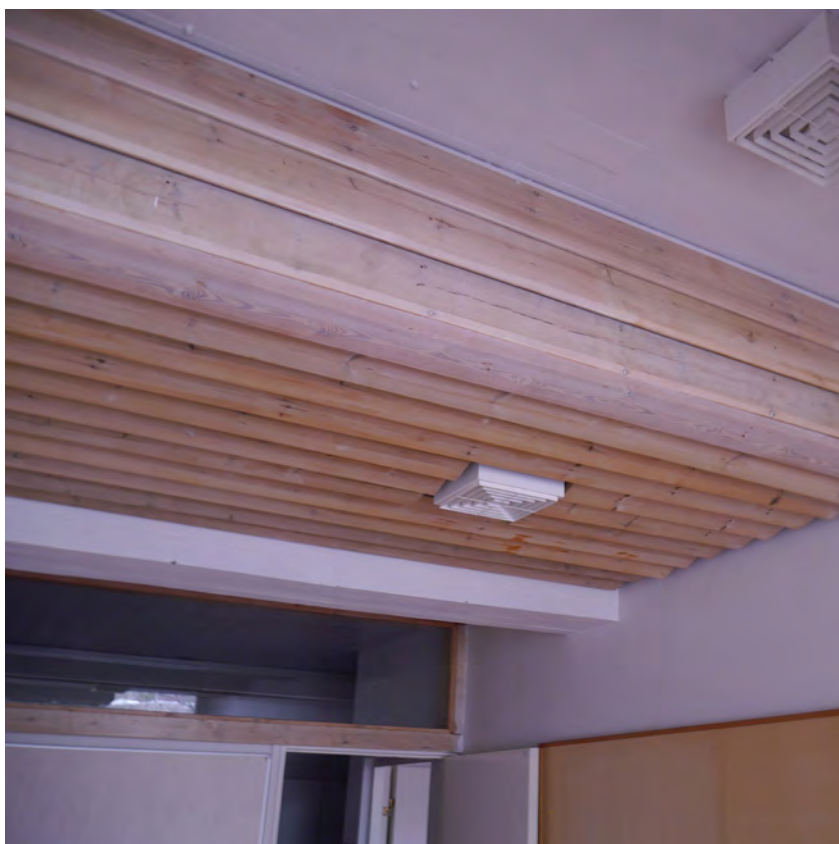
Esimerkki toimistotilojen puualakatosta. Tässä kohtaa otsapinnat ovat profiililautaa.
