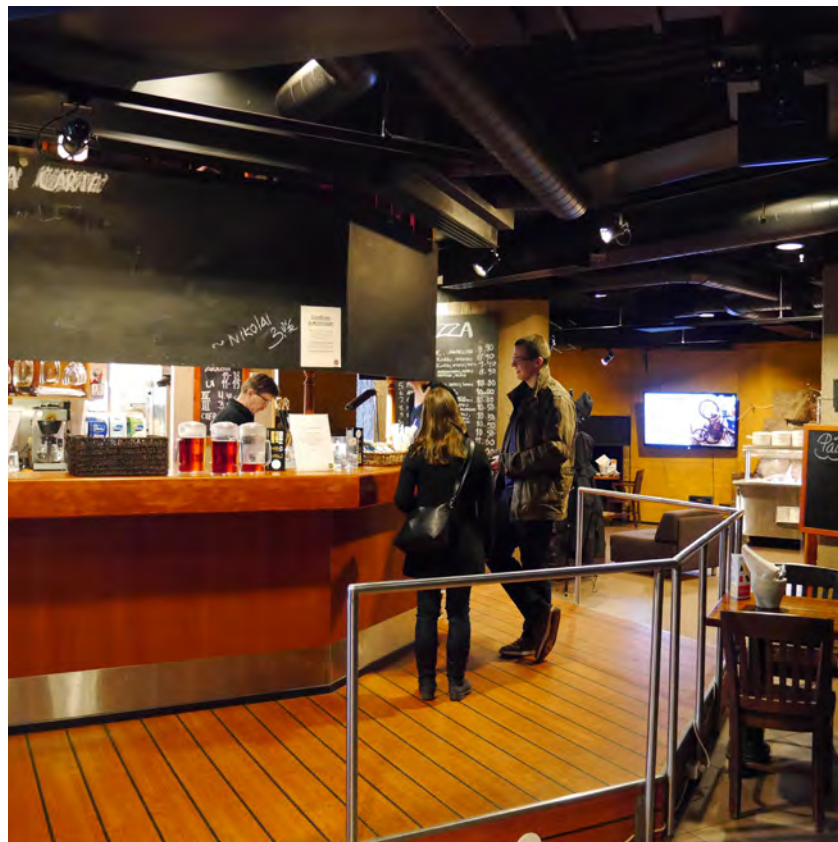
Kaljakellarista on purettu alkuperäinen puualakatto. Sen nykyinen asu on vuodelta 2002.
