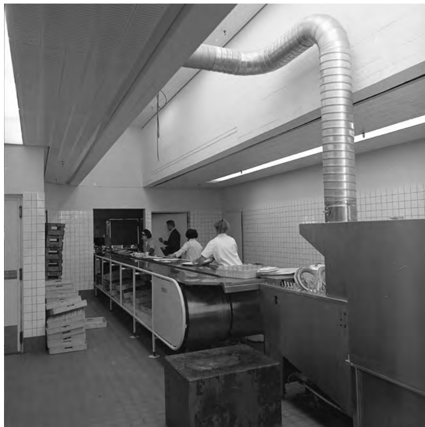
Astianpalautuksen liukuhihnajärjestelmä.
