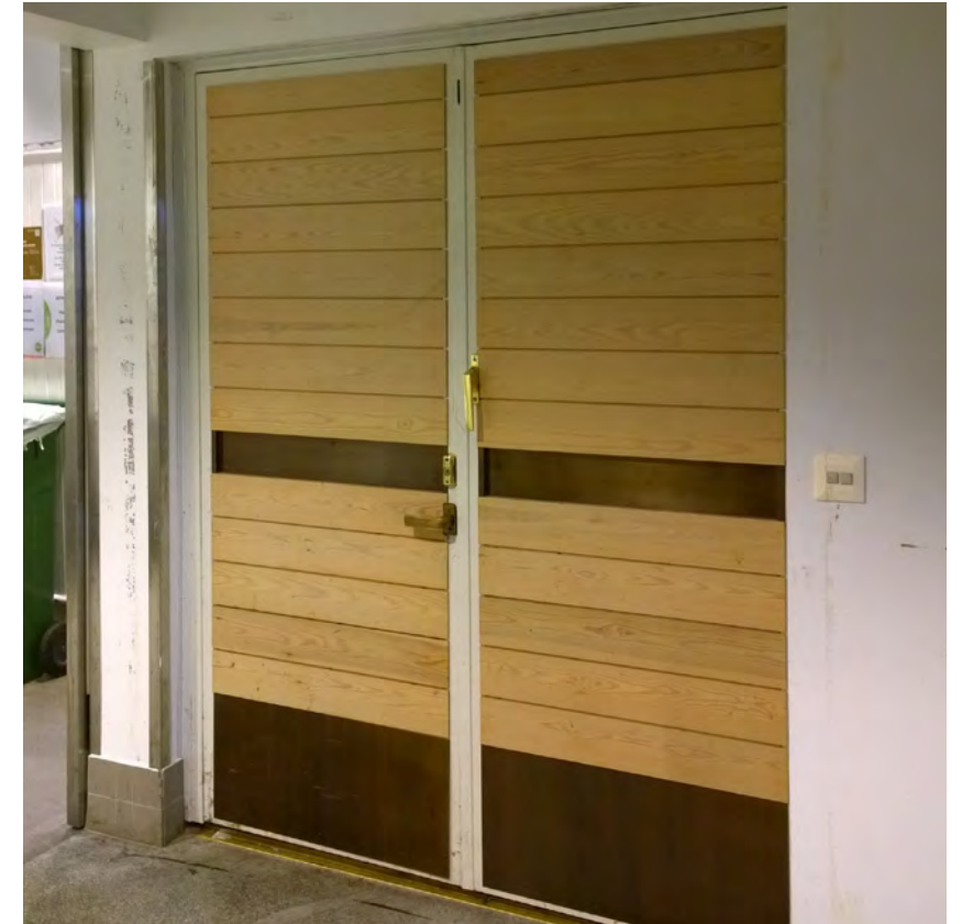
Vuoden 1993 muutostöissä lisättiin alkuperäisiä OH2-ovia muistutavia uusi ovia.
