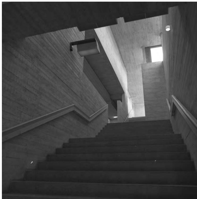
Porras aulasta toisen kerroksen kokoustiloihin. Porras jatkui katon tasolle asti.
