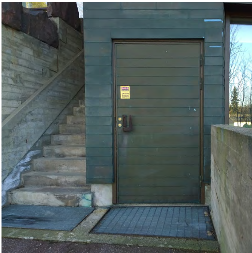
OUPK-ovet on päällystetty samanalisella kupariverhouksella kuin julkisivut.
