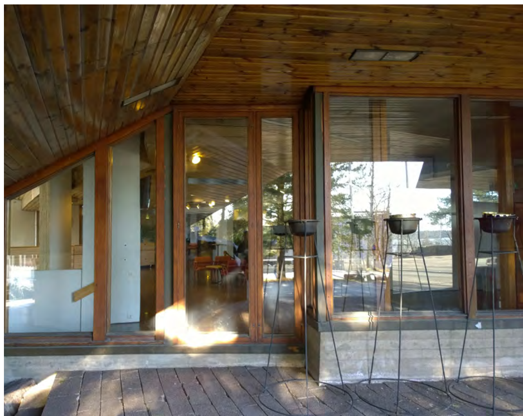
Itäisen pääsisäänkäynnin vieressä olevia alkuperäisiä ikkunoita. Näissä on säilynyt myös alkuperäinen kuultokäsittely sekä kupariset listat lasin alareunassa.
