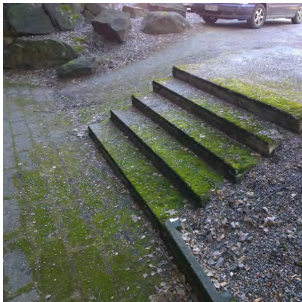
Tyypillinen pesubetonilaatoilla päällystetty ulkoporras.
