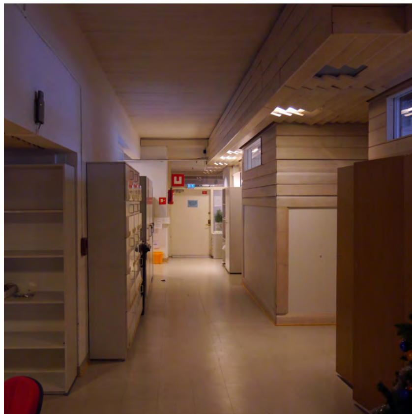
Kiltahuoneiden ikkunoita käytävälle on laitettu umpeen.
