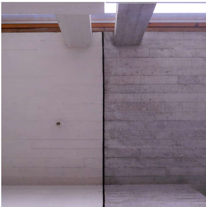
Alkuperäinen kuultokäsitelty ja nykyinen peittomaalattu betonipinta.
