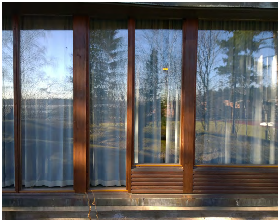
Uusittuja ikkunoita koillisjulkisivussa.
