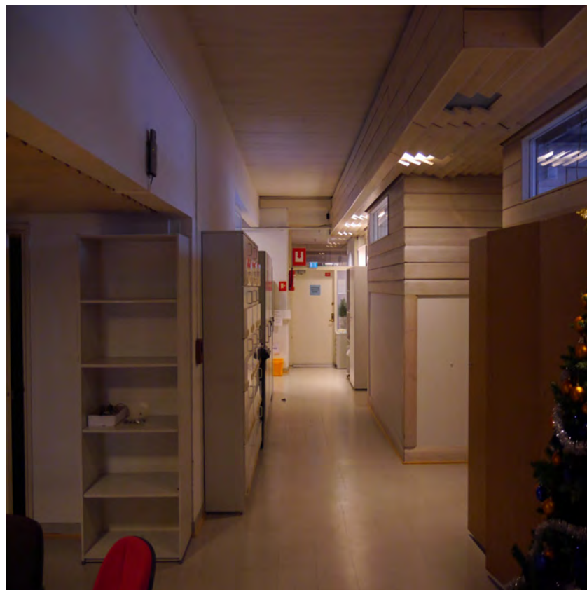
Entisten kiltahuoneiden yläkunoissa on myöhempiä lisälaseja.
