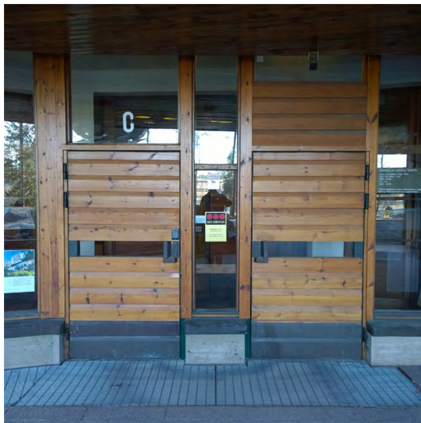
OUT-tyyppisiä ovia eteläisessä pääsisäänkäynnissä.
