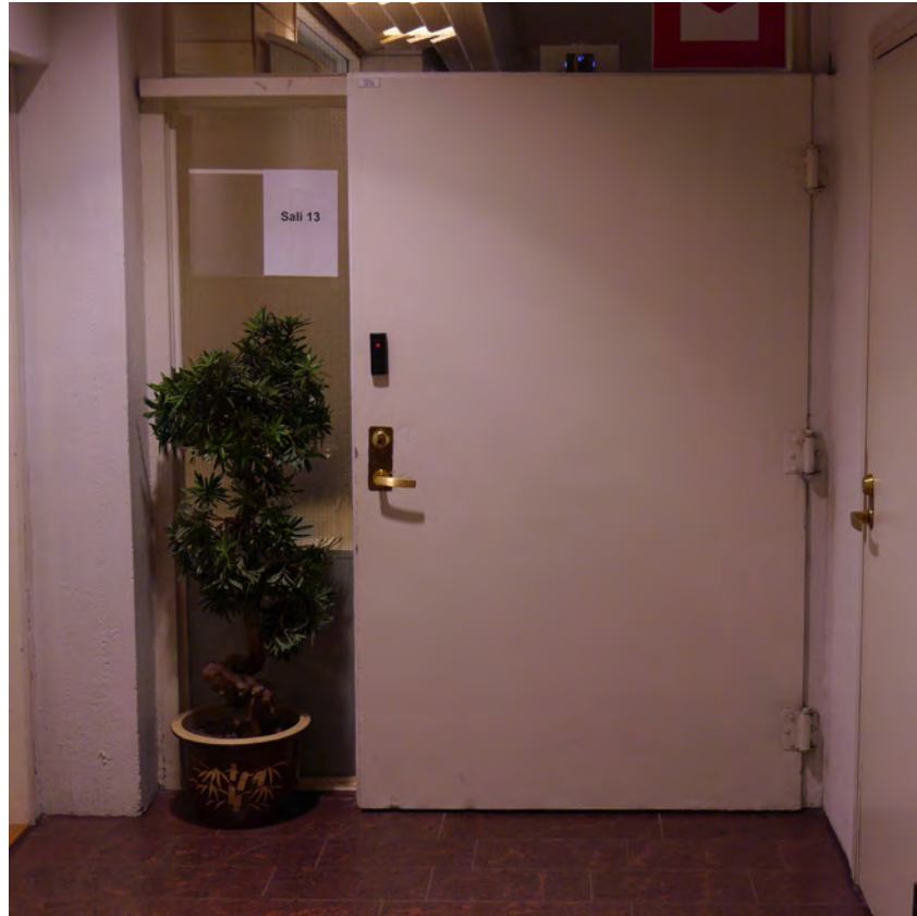
Palo-ovet ovat ajalle tyypillisiä standardiovia.
