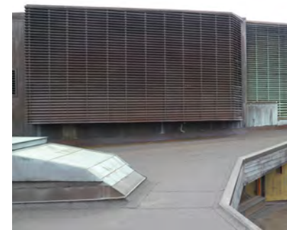
Lauhduttimen vuonna 1998 lisätty säleikkö.
