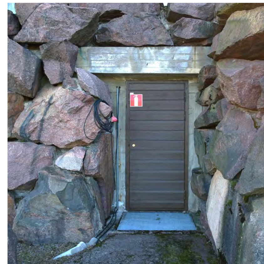
Teatterisalin projektorihuoneen ovi on tyyppiä OUP. Siinä on puiset karmit eikä siinä ole ikkunaa.
