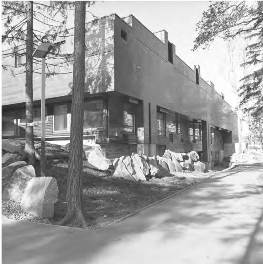
Pohjoisen toimistosiiven julkisivua.
