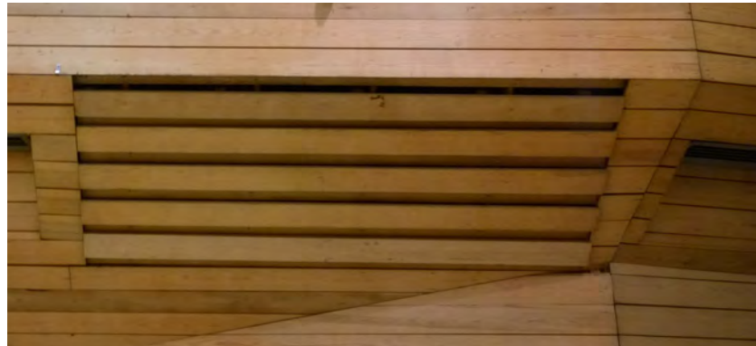
Juhlasalin parven laudoista rakennettu säleikkö.
