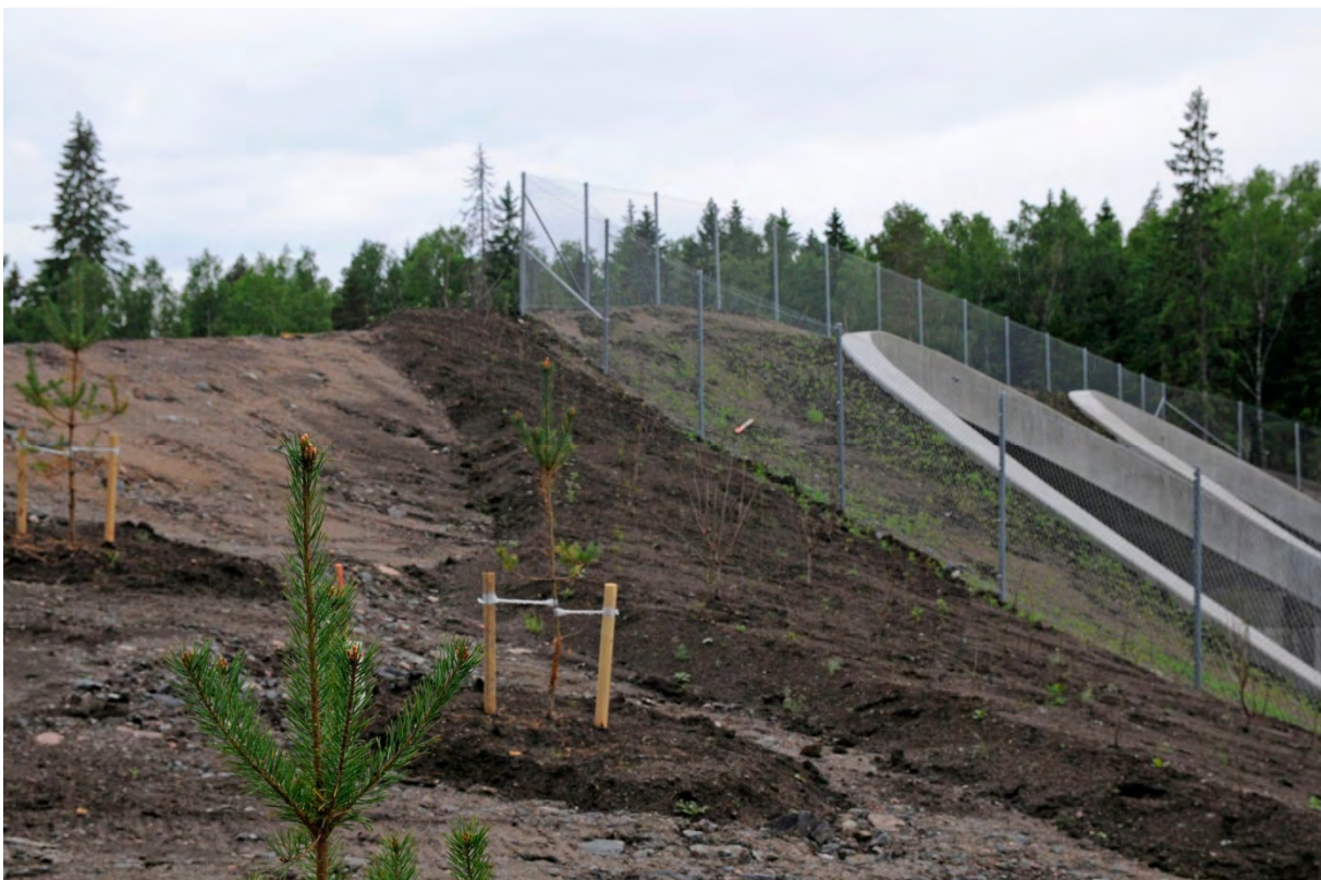
Kuva 8. Vihersillalle on tärkeää istuttaa riittävästi suojaavaa kasvillisuutta, jotta eläimet uskaltavat käyttää sitä kulkureittinään. Kuvassa Finnträskin vihersilta Kirkkonummella. (Kuva: Liikennevirasto, Indav/Kimmo Häkkinen 2013).
