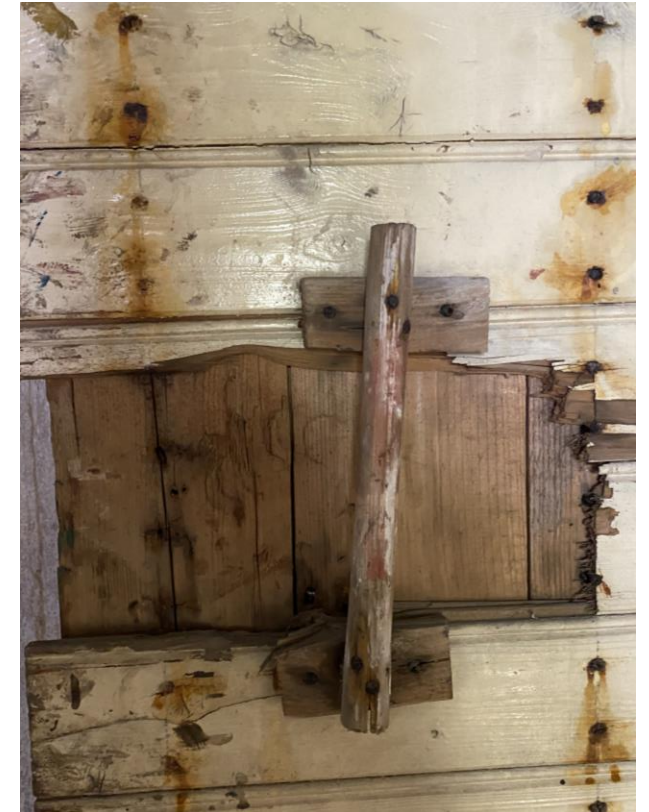
Oven kahva poikkeaa meijerin muista ovista. Vaakalaudoituksen halkeaman kohdalla on mahdollisesti ollut lukko.
