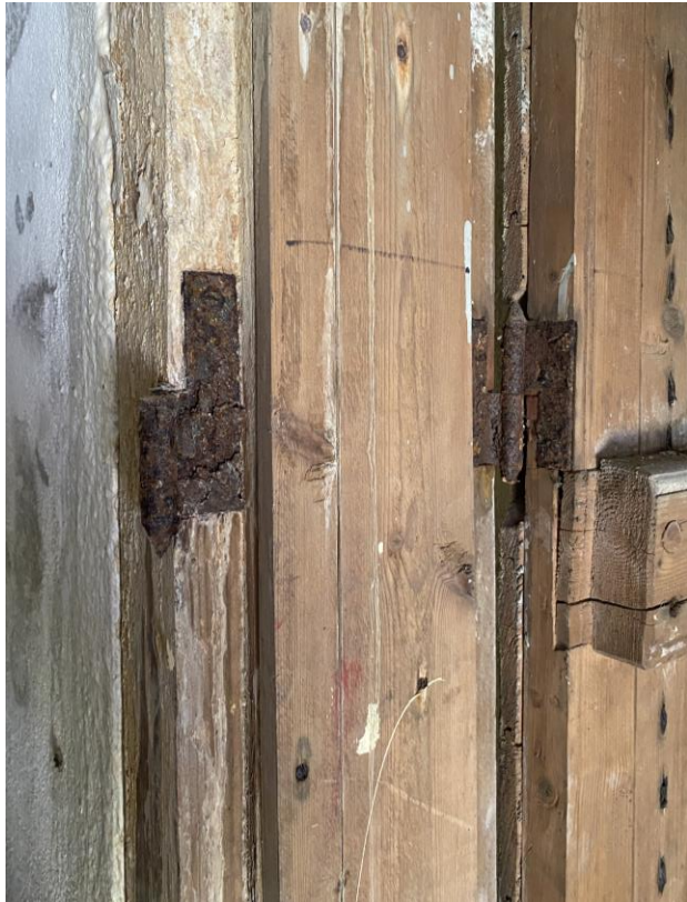
Etuhuoneen oven karmin ulkopuolella olevista saranoista voidaan päätellä, että ovia on alun perin ollut kaksi.
