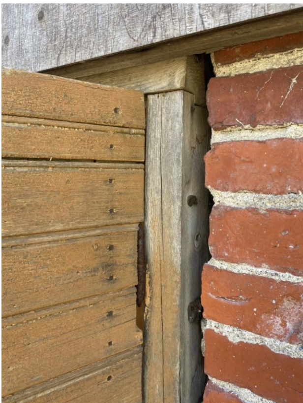
Oven karmen ja muuratun seinän väliin jää leveä tila. Huullokseen kiinnittyvät saranat ovat ruostuneet.
