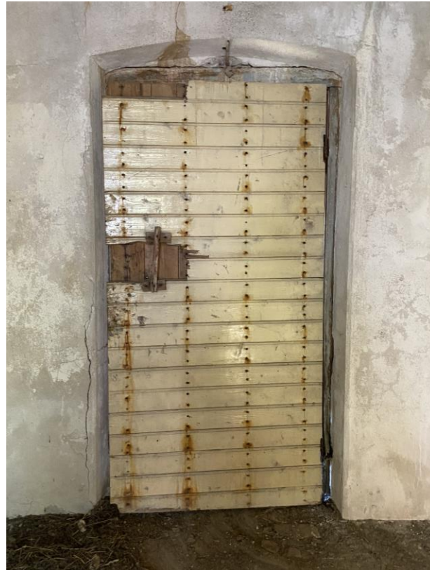
Etuhuoneen vaakalaudoitus on maalattu vaalealla maalilla. Seinä karmin yläpuolella on holvattu,
