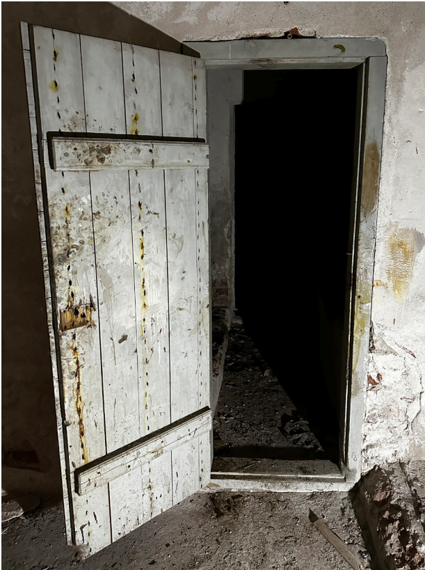
Allashuoneen ovi avattuna. Karmi ja ovi pienoineen on maalattu siniseksi. Ovilehdessä näkyvillä lukon paikka.
