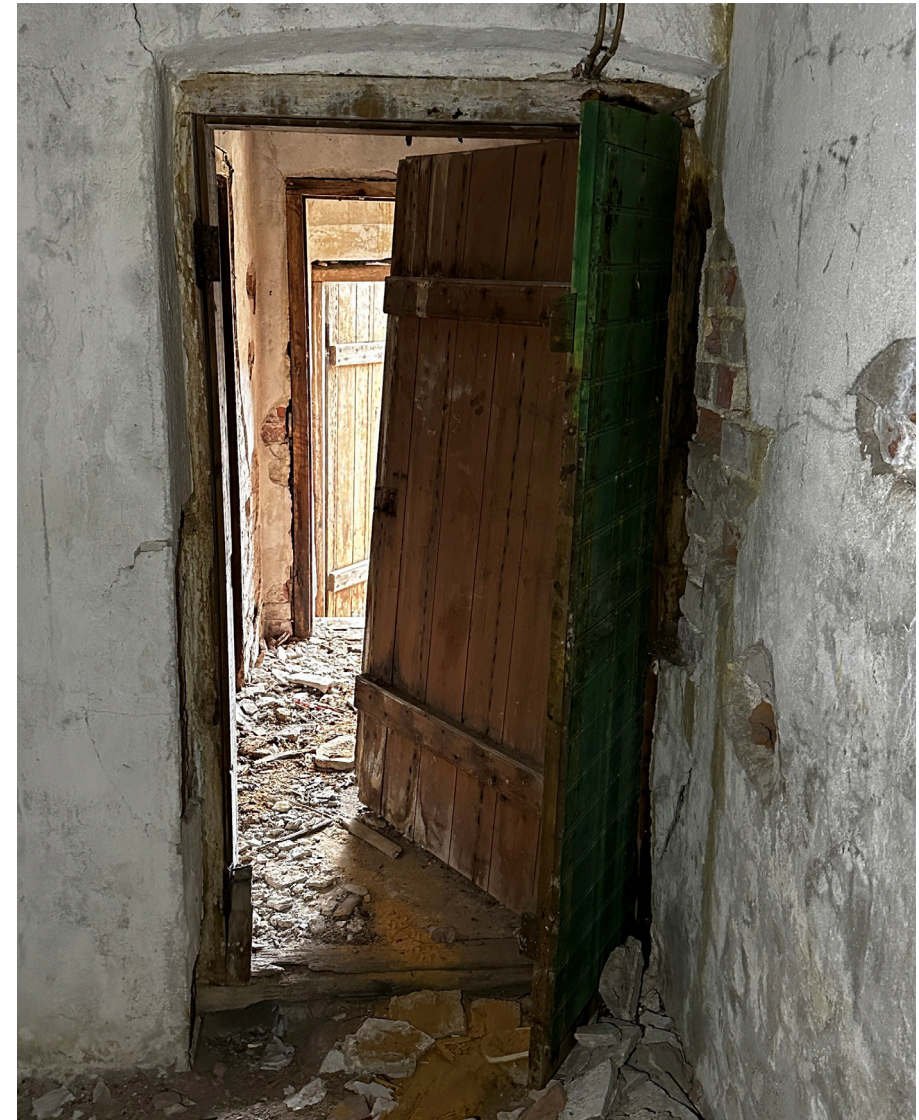
Pariovi meijerisalista kuvattuna. Karmin toisella puolella eteishuoneen ovi.
