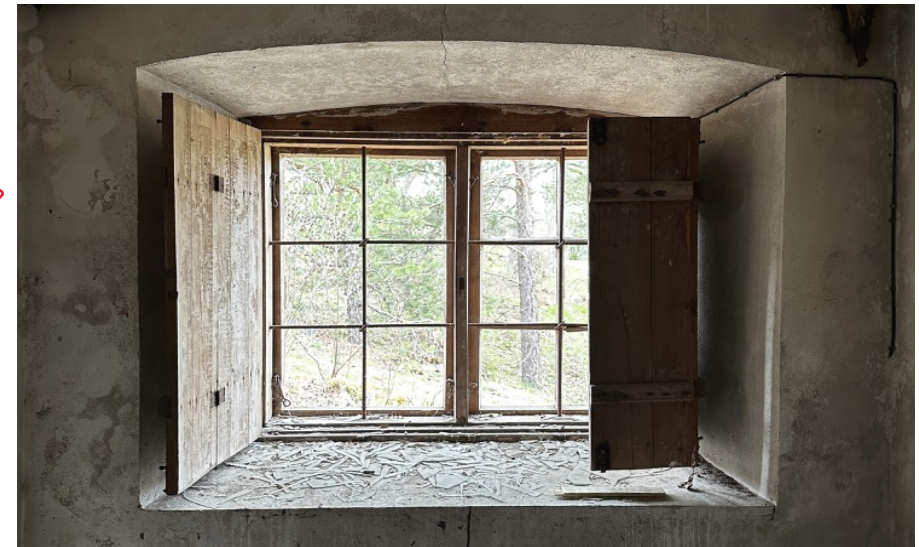
Pohjoiseen avautuva ikkuna sisä- ja ulkopuolelta kuvattuna toukokuussa 2023
