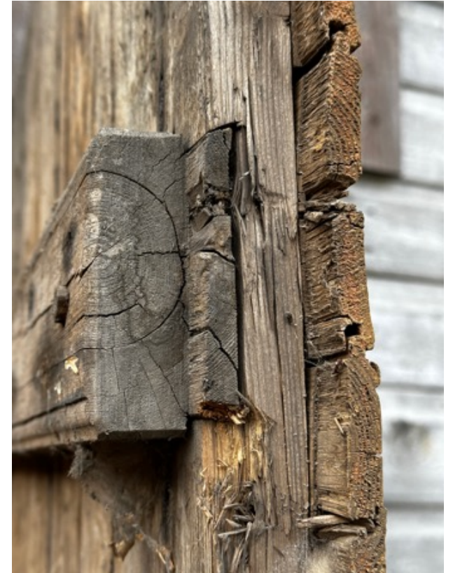
Pienan ja vaakalaudoituksen rakenne on yhdenmukainen rakennuksen kaikissa ovissa.
