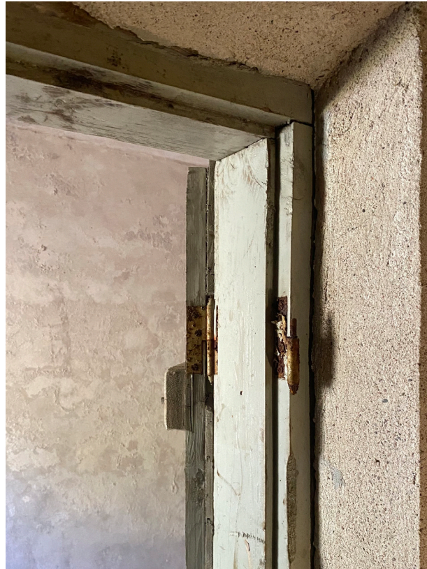
Allashuoneen oven karmi. Karmiin kiinnitetystä saranoista on tulkittavissa, että ovilehtiä on ollut kaksi.
