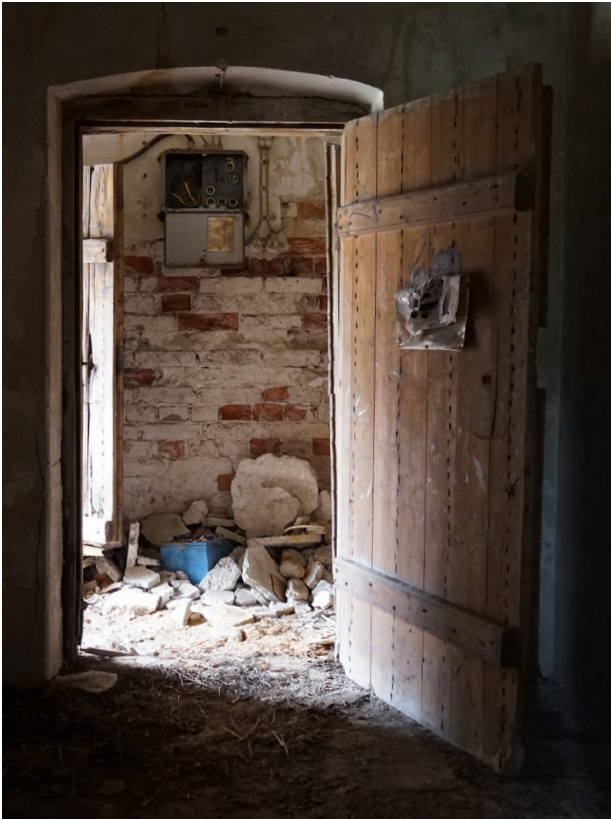
Sivuhuoneen ovi avattuna. Seinä on holvattu karmen yläpuolelta.
