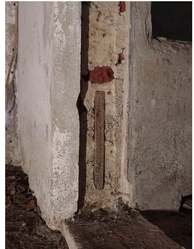
Karmin pystyrakenne ja kynnyks. (?)
