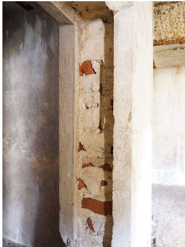
Puuttuvan karmin upotus seinärakenteessa. Karmin rakenne on luultavasti vastannut allashuoneen toisen oviaukon karmia.
