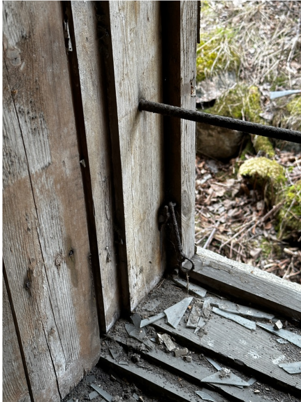
Ikkunankarmi sisältäpäin, jossa kynte mahdolliselle irroitettavalle talvipuitteelle .
