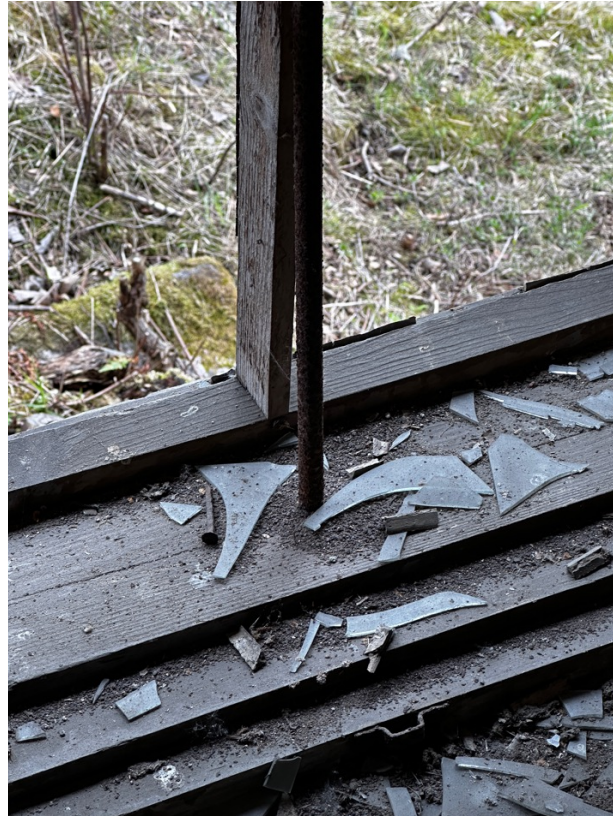
Oikeanpuoleisen ikkunalehden karmissa nähtävissä rautakaltherin ja pystypuiteiden noudattama jako, sekä kiväärisalvan lukkopesä.
