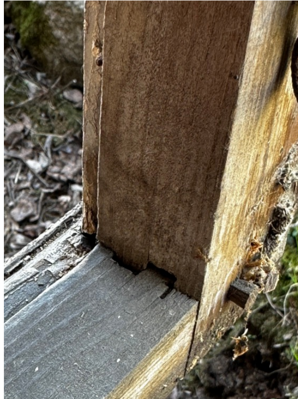
Ikkunan puitteessa kaksitappisen litsin sahauksessa syntyneet jäljet, sekä puutapit jotka kertovat ikkunalehden valmistuneen ennen 1930-lukua. Mikkola, J. & Böök, N. (2011), s.81
