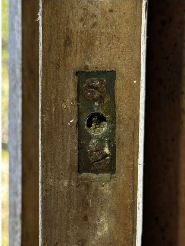
Sisäpuolella kuvatussa postipuussa oleva kierrehela mahdolliselle talvipuitteelle.
