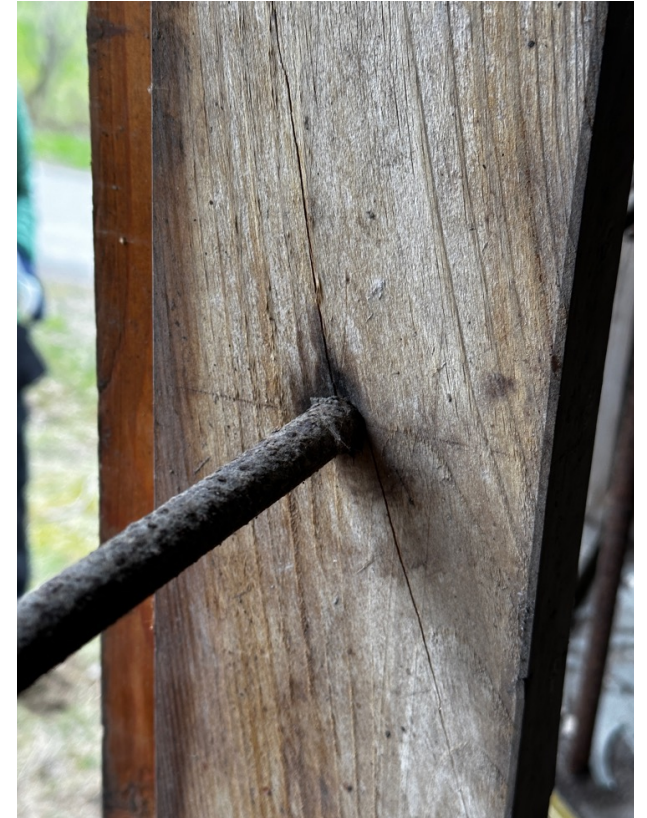
Postipuun keskelle kiinnittyvä rautakalteri. Takalalla näkyvä punertava kynte antaa viitteitä erityisen tiviiksi tehdystä ikkunasta joka on valmistettu ennen moderneja tiivisteitä.
