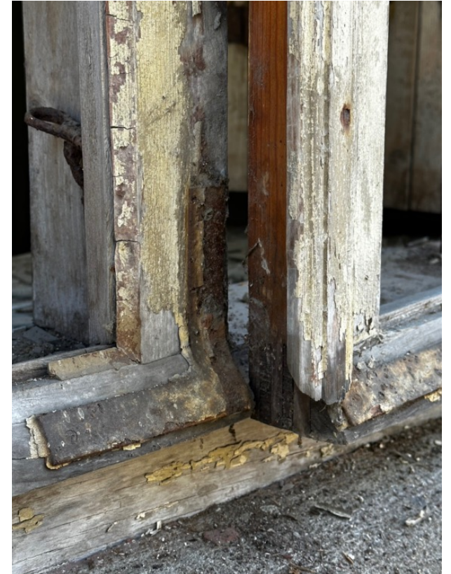
Profiloitu rakolista peittää metallisen kulmaraudan.
