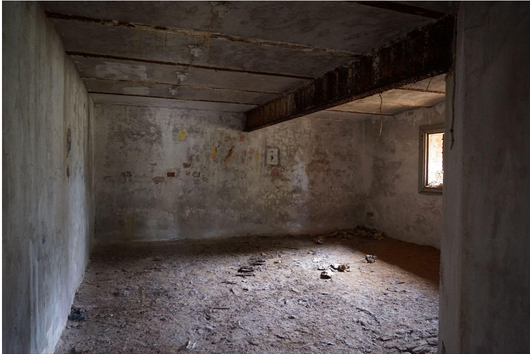
Meijerin suurimmassa tilassa ratakiskoja kannattalee jännevälin keskeltä jakava kookas I-palkki. Kuva: Laura Mattila
