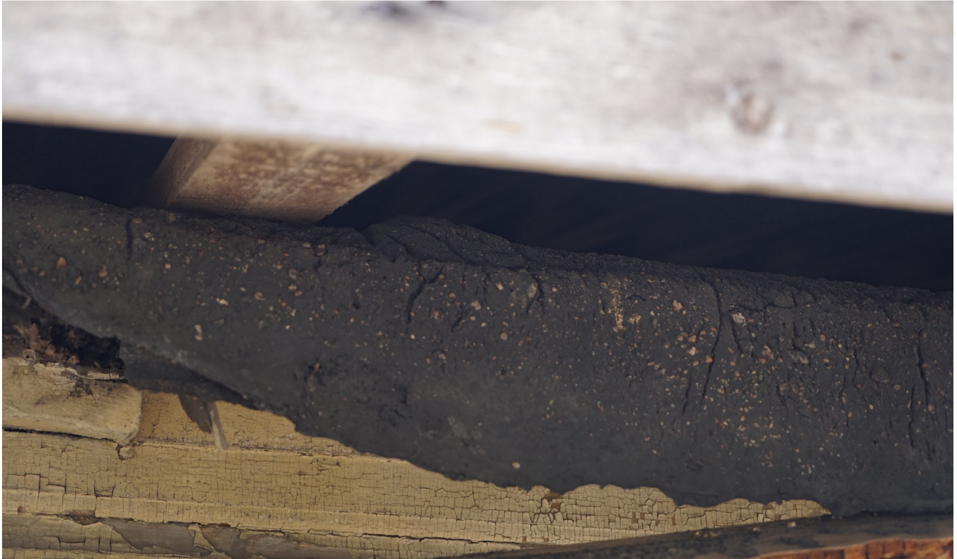
Vanha vesikatto on päällystetty huovalla, jonka alla on kolmiorimat (kohouma kattuhuovassa kuvan keskivaiheilla). Kuva Laura Mattila.
