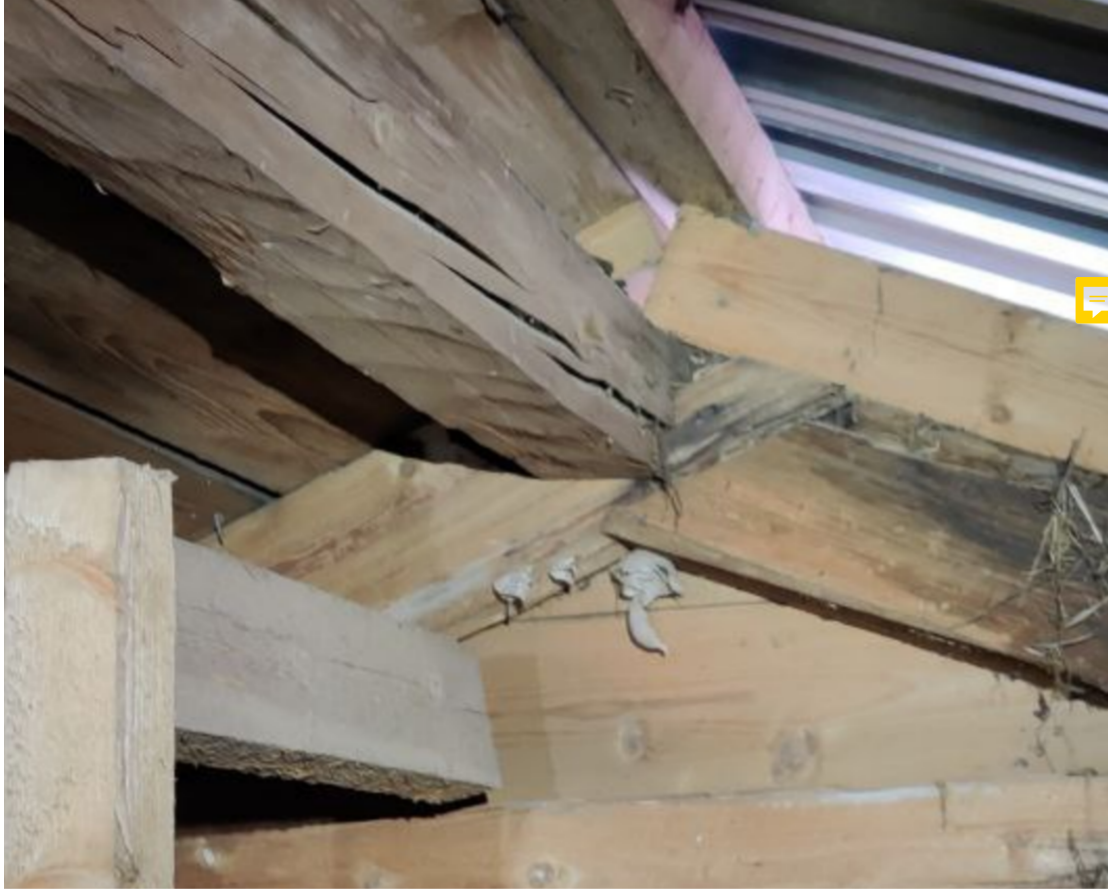
Selkämpuiden liitos sekä niiden läpi kulkeva kukkopuu. Päällä uuden katon rakenteita. Kuva Sameli Sivonen.
