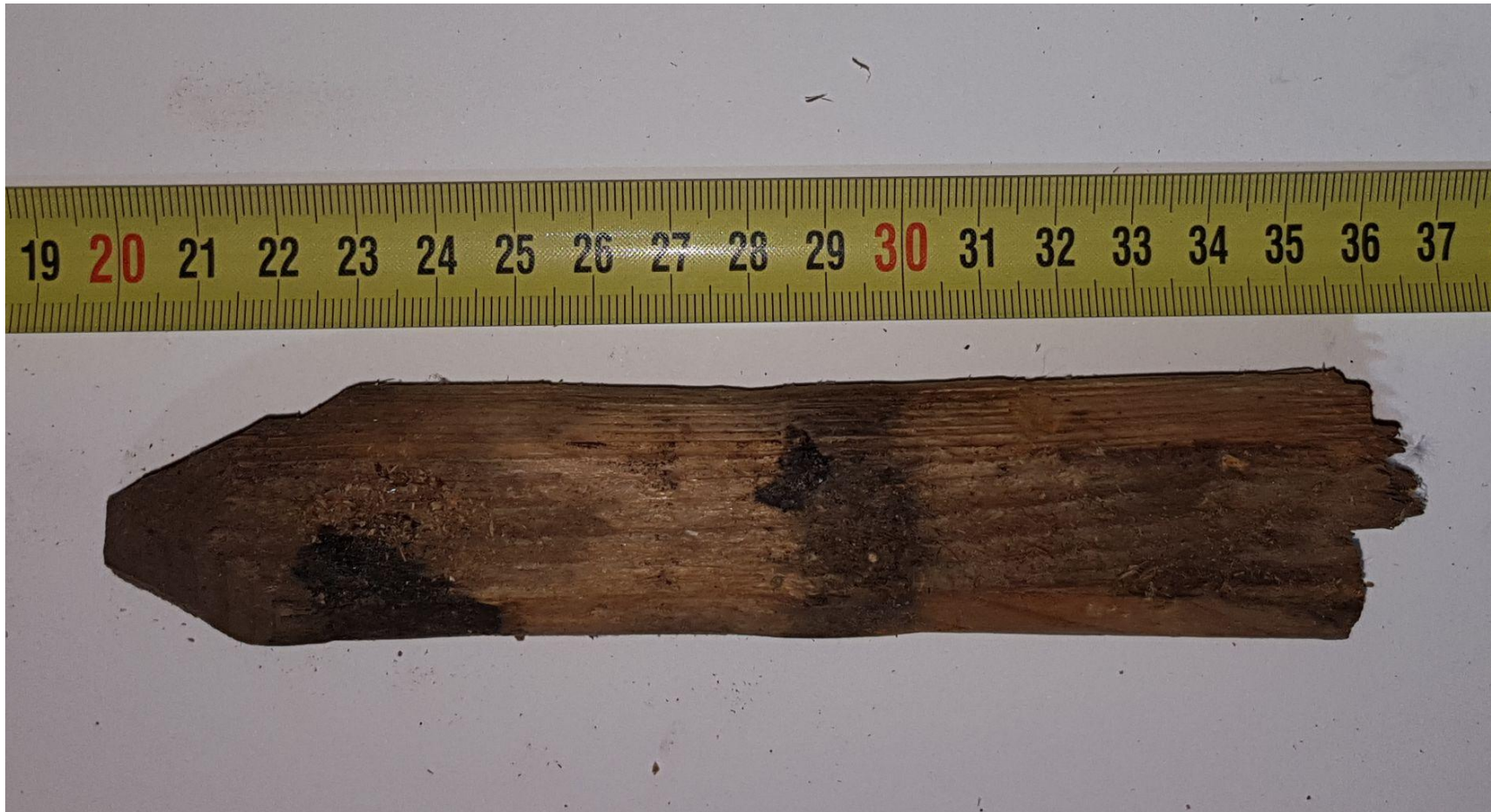
Uuden peltikatteen rakennustöiden jäljiltä alkuperäisiä kattotuolien kuusikulmaiseksi veistettyjä puutappeja on säilynyt ullakolla. Kuva: Juhani Laaksonen
