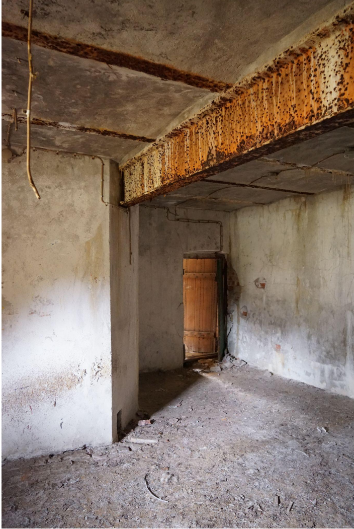
I-palkki ulottuu ulkoseinältä väliseinän päälle. Kuva: Laura Mattila
