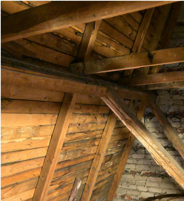
Vinotuet kannattelevat pitkittäissuuntaista vuoliaista. Kitapuut tukeutuvat vuoliaiseen ja liittyvät selkäpuihin naulaliitoksella.
