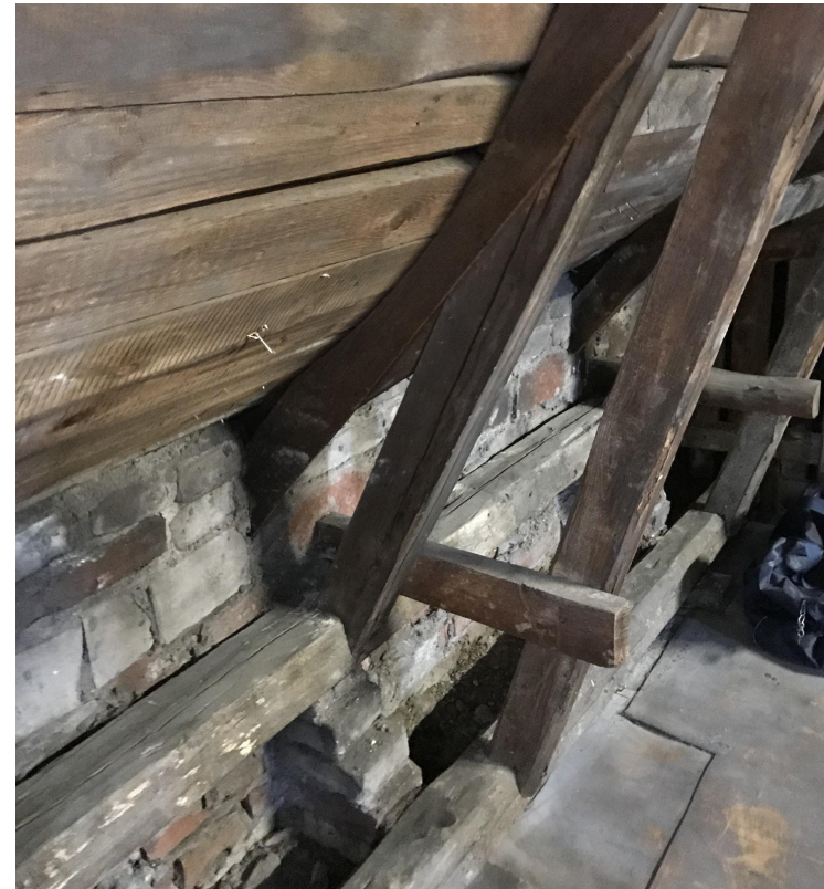
Vesikaton lappeen kaareutuvan muodon hahmottaa ullakolla hyvin. Kaareutuvaa aluslaudoitusta tukee selkäpuuhun kiinnitetty laudanpätkä.
