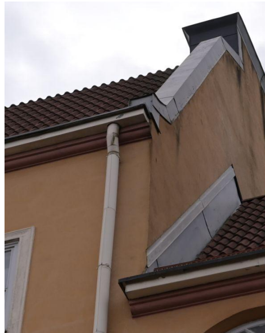
Vesikouru on naamioitu osaksi räystäään koristelua. Katon lape kaareutuu räystäään kohdalla.
