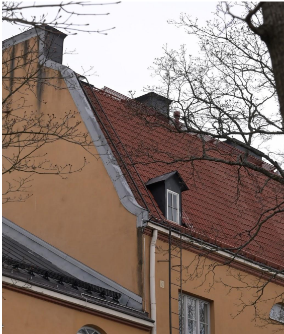
Katossa on tiilikate, jolle on ominaista jyrkkä kattokulma verrattuna peltikatteeseen. Korkean mansardikattoisen osan päädyn palomuuuri erottaa siihen liittyvän matalamman osan. Kuva on otettu pihan puolelta.
