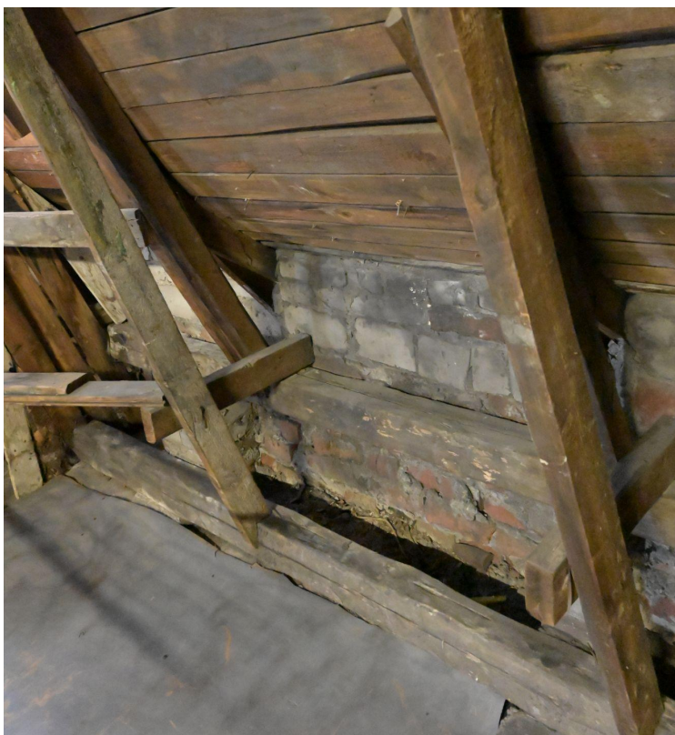
Kontti on toteutettu hyvin kapeana kolmiona. Selkäpuuhun ja jalasparruun tukeutuva kattotuolirakenne toistuu noin metrin välein.
