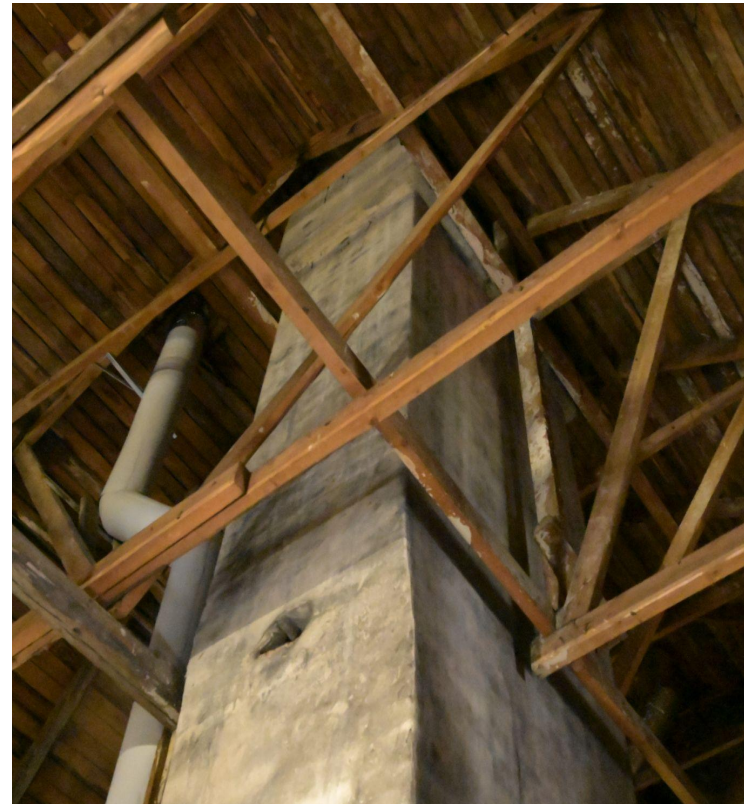
Puurakenne kiertää piipun. Vekselpalkit sitovat kattotuolit toisiinsa piipun molemmin puolin.
