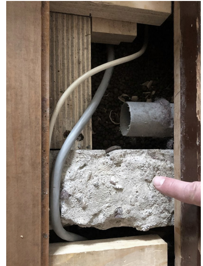
Valokuva välipohjan betonipalkista, Hauhontie 4G 41.
