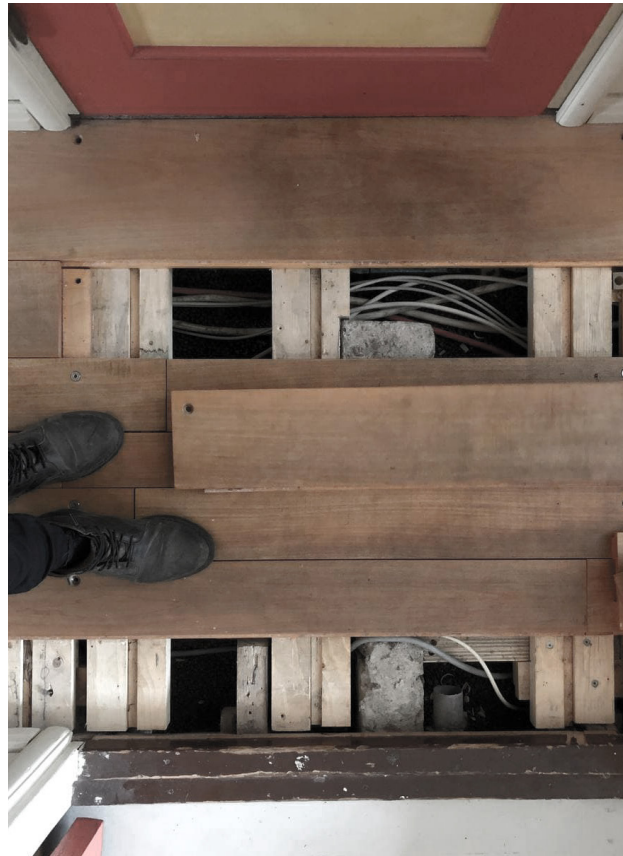
Valokuva asunnon välipohjasta, Hauhontie 4G 41.
