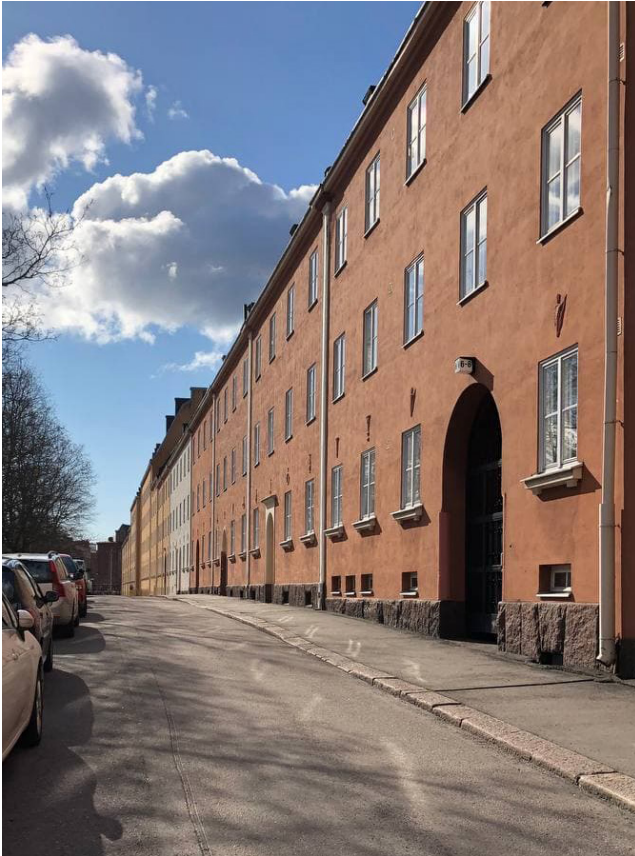
Valokuva Hauhontien puoleisesta julkisivurappauksesta.
