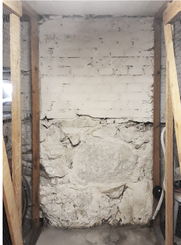
Valokuva perustuksista, Hauhontie 8.
