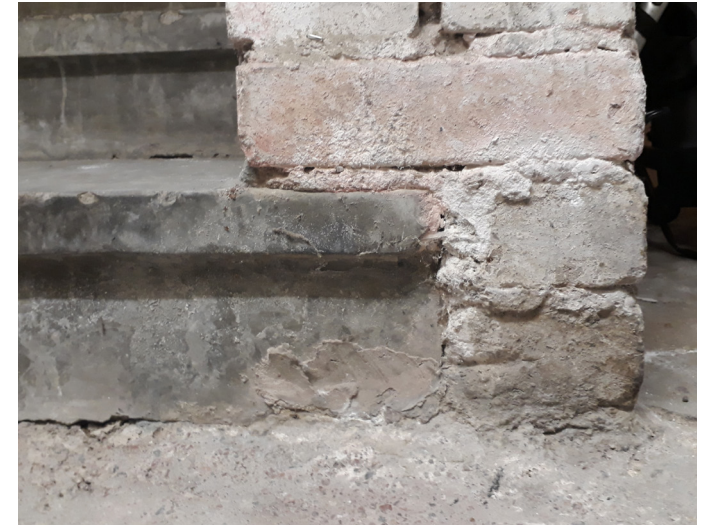
Valokuva kellariin johtavasta portaasta, Hauhontie 8 (F-porras).
