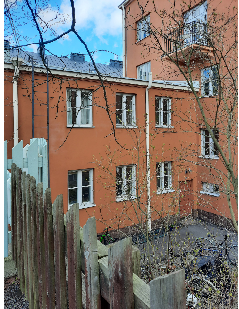
Näkymä Inarintieltä naapuritontilta. Porrashuoneiden lisäksi päädyissä Eurantielle ja Keiteleentielle jatkuvat massat ovat vaikuttaneet julkisivusommitelmaan.
