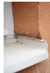
Ikkunapelti käännetty seinän viertä vasten ulkopuolella
