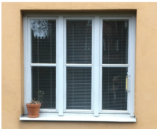
Asunnon 8F 33 olohuoneen ikkuna kuvattuna pihan puolelta
