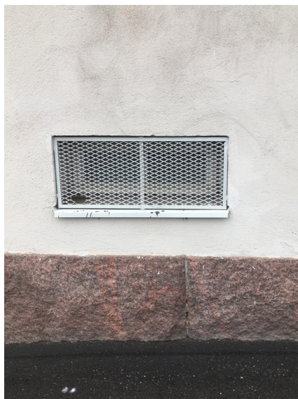
Kellarin vaakasuuntainen ikkuna Hauhontieltä. Ikkunan edessä on säleikkö.
