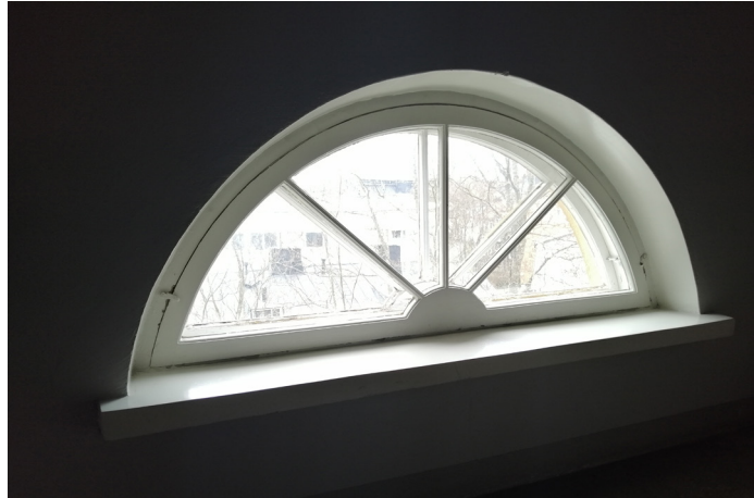
Porrashuoneen 8 F lunetti-ikkuna sisältä kuvattuna.
