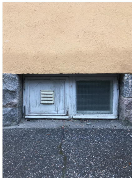
Kellarin vaakasuuntainen ikkuna Hauhontieltä. Ikkunassa on pystyvälikarmi.
