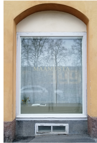
Liikehuoneiston ikkuna kaarisyvennyksellä ja kellari-ikkunalla Hauhontielle
