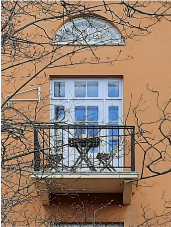
Porrashuoneen lunetti-ikkuna ulkoa kuvattuna.
