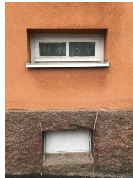
Kellarin vaakasuuntainen ikkuna Hauhontieltä. Ikkunassa on pystyvälikarmi.
