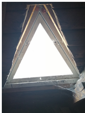
Ullakon uusittu kolmioikkuna sisältä kuvattuna.
