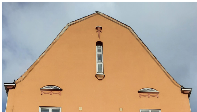
Ullakon kaksi lunetti-ikkunaa ja korkea pystyikkuna Keiteleentieltä kuvattuna.
