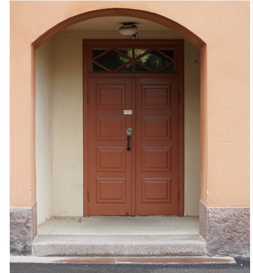
M-portaan pääovi Hauhontiellä.
