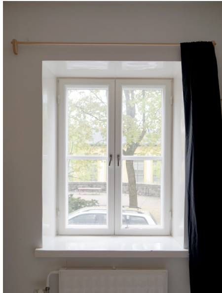
Asunnon 8F 33 makuuhuoneen ikkuna kuvattuna asunnon sisältä
