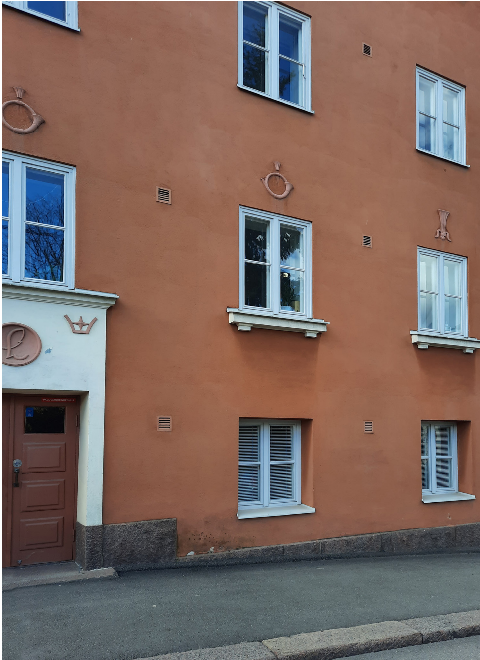
Näkymä Hauhontieltä L-portaan edustalta. Ensimmäisen kerroksen ikkunat ovat sisäänvedetyt, kun taas ylemmissä kerroksissa ikkunat ovat julkisivupinnan kanssa samassa tasossa.
