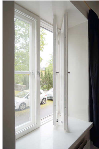
Kaksijakoinen, yhdellä pystyvälikarmilla varustettu kaksinkertainen sisään-sisän aukeava ikkuna
