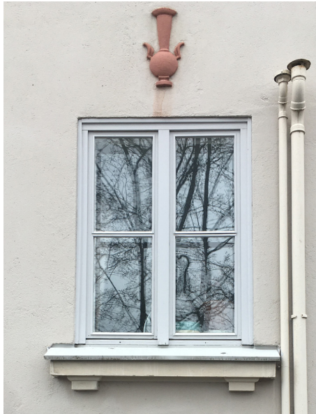
Asunnon 8F 33 makuuhuoneen ikkuna kuvattuna Hauhontieltä
