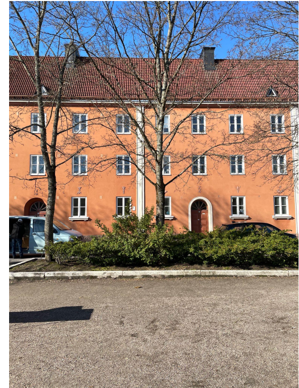
Näkymä Hauhontie 6-8 julkisivusta Hauhon puistosta katsottuna.
