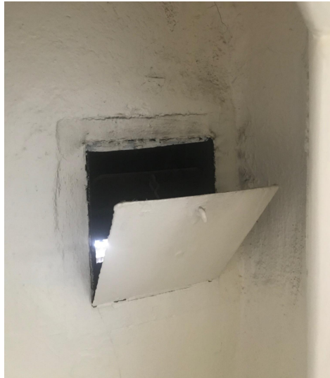
(2, Laura Mattila) Vanhanmallinen korvausilman kippiventtiili kiintokomeron sisällä. Hauhontie 8 F 33.
