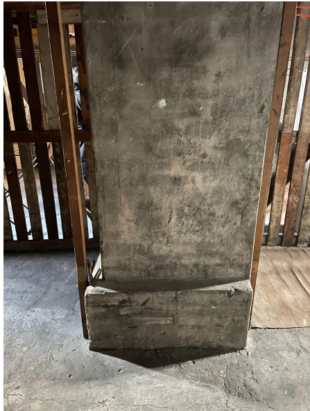
Hauhontie 6 A ja 6 B rappujen välissä sijaitsevan piipun läpivienti eristetyn yläpohjan kohdalla (kapeampi sivu).
