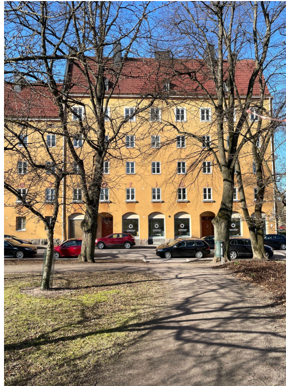
Näkymä Hauhontie 4 julkisivusta Hauhon puistosta katsottuna.
