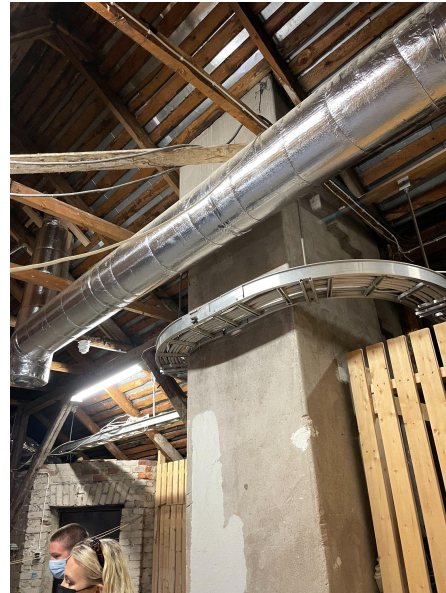
Piipun läpivienti vesikaton kohdalla.
