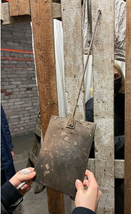
Ullakolta löytyneitä purettujen kaakeliuunien osia. Kuvassa kaakeliuunin sulkupelti.
