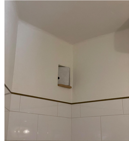
Kylpyhuoneessa on asukkaan toimesta vaihdettu poistoilmaventtiiliin keraaminen luukku. Hauhontie 4 G 41.
