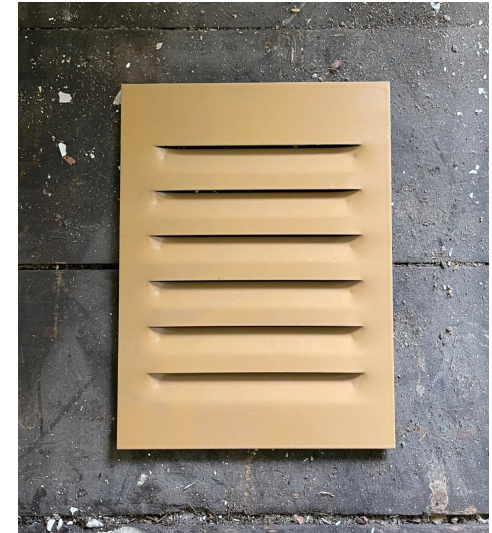
Uusi, peltinen ja julkisivun sävyyn maalattu korvausilmaventtiilin ulkoilmasäleikkö. Osa säleiköistä on vaihdettu vuosina 2012-2013 tehdyn linjasaneerauksen aikana. Kuvattu irtonaisena taloyhtiön verstaatilassa.
