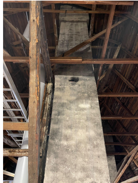
Piipun läpivienti vesikaton kohdalla.
