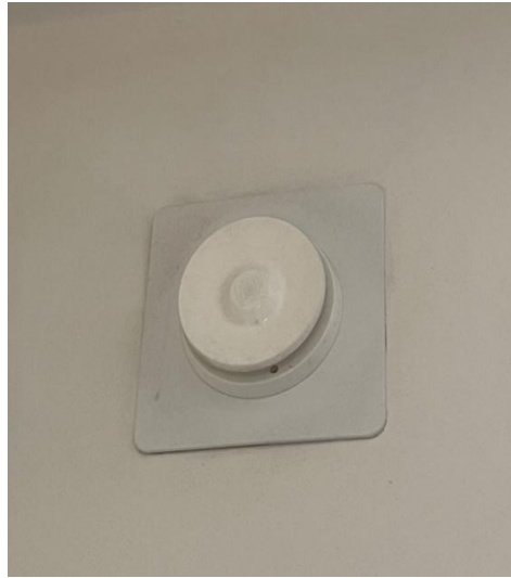
Asuinhuoneen uusi, itsesäätyvä korvausilmaventtiili vaatii asukkaalta vanhaa mallia vähemmän toimenpiteitä. Uudenmallisessa luukussa on myös korvausilman suodattimet, jotka vähentävät sisäilmaan kantautuvien pienhiukkasten määrää. Suodatin tulee vaihtaa säännöllisin väliajoin korvausilman hyvän laadun ylläpitämiseksi. Hauhontie 8 F 33.
