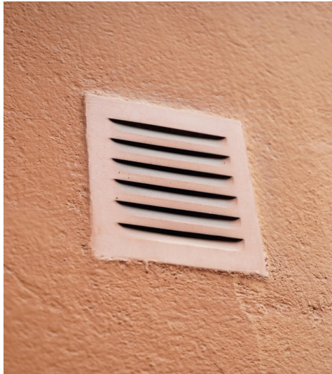
(3, Laura Mattila) Julkisivun väriseksi maalattu korvausilmaventtiilin ulkosäleikkö.
