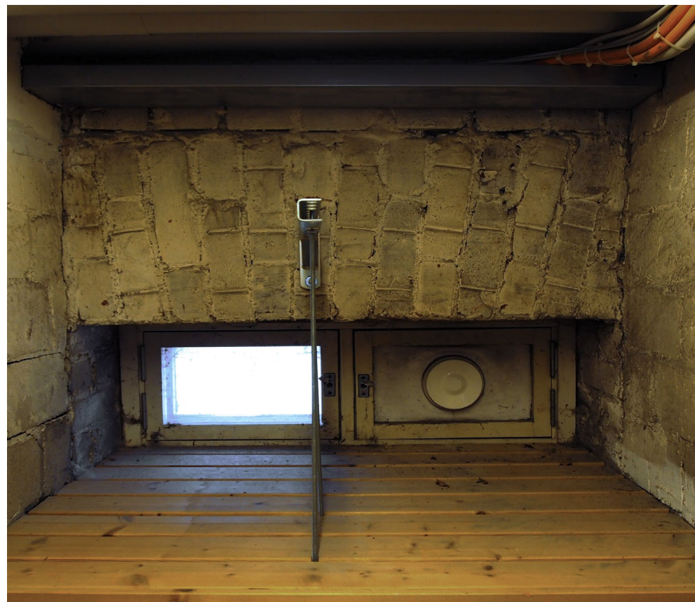
Pihan puolen ikkuna 8 F kellarissa. Ikkuna-aukkojen yläpuolelle on muurattu tiiliholvit. Muottia vasten tehdyn holvin alapinta on vaakasuora. Kuvassa näkyvät myös irtainvarastojen syrjätiiliseinät.
