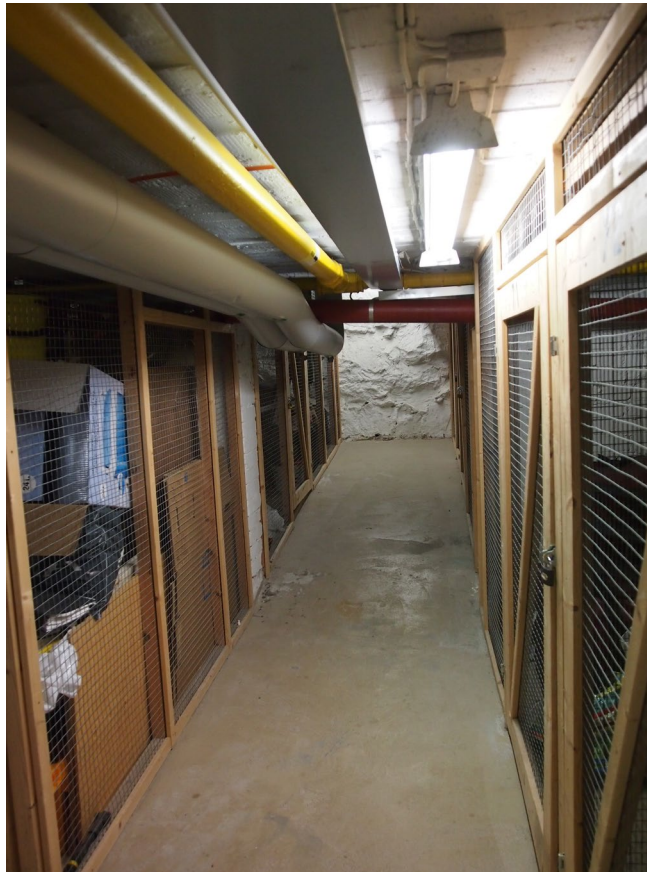
Näkymä 8 L kellarin kaakkoispäättyyn. Lattia myötäilee maanpinnan muotoa. Lattia on maalattu.
