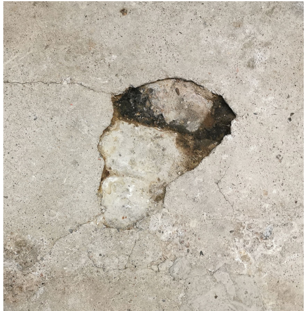
Kuvat 8 G kellarin lattiapinnasta portaikon edessä. Kuvissa näkyy sama halkeama lattiassa. Maanvaraisen lattian alta näkyy kiviainesta tai kalliota. Betonivalu vaikuttaa ohuelta. Lattiaa ei ole maalattu.
