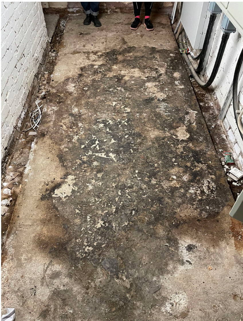
Kosteus on nostanut suoloja (valkoinen hyhmä) esille seinän ja lattian yhteenliittymässä.
