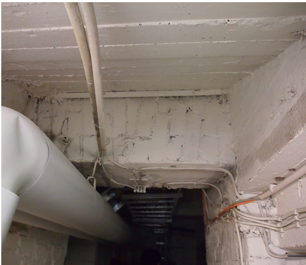
6 C kellarin kulkuaukon yläosa. Kellarin kantaviin seiniin tehtyjen kulkuaukkojen päällä on tiiliholvaus. Muottia vasten tehdyn holvin alapinta on vaakasuora.
