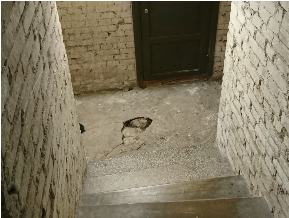
Kuvat 8 G kellarin lattiapinnasta portaikon edessä. Kuvissa näkyy sama halkeama lattiassa. Maanvaraisen lattian alta näkyy kiviainesta tai kalliota. Betonivalu vaikuttaa ohuelta. Lattiaa ei ole maalattu.
