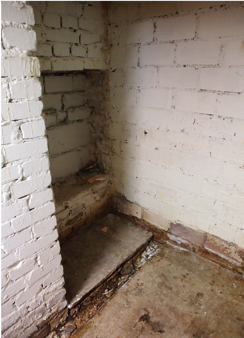
Tüliseiniä 6 B sähköpääkeskuksessa. Syrjä- ja lapetiilimuuraus vaihtelevat. Maali puuttuu seinän alaosasta, ja vaikuttaisi siltä, että seinässä on käytetty sekä puna- että kalkkihiekkatiliä.
