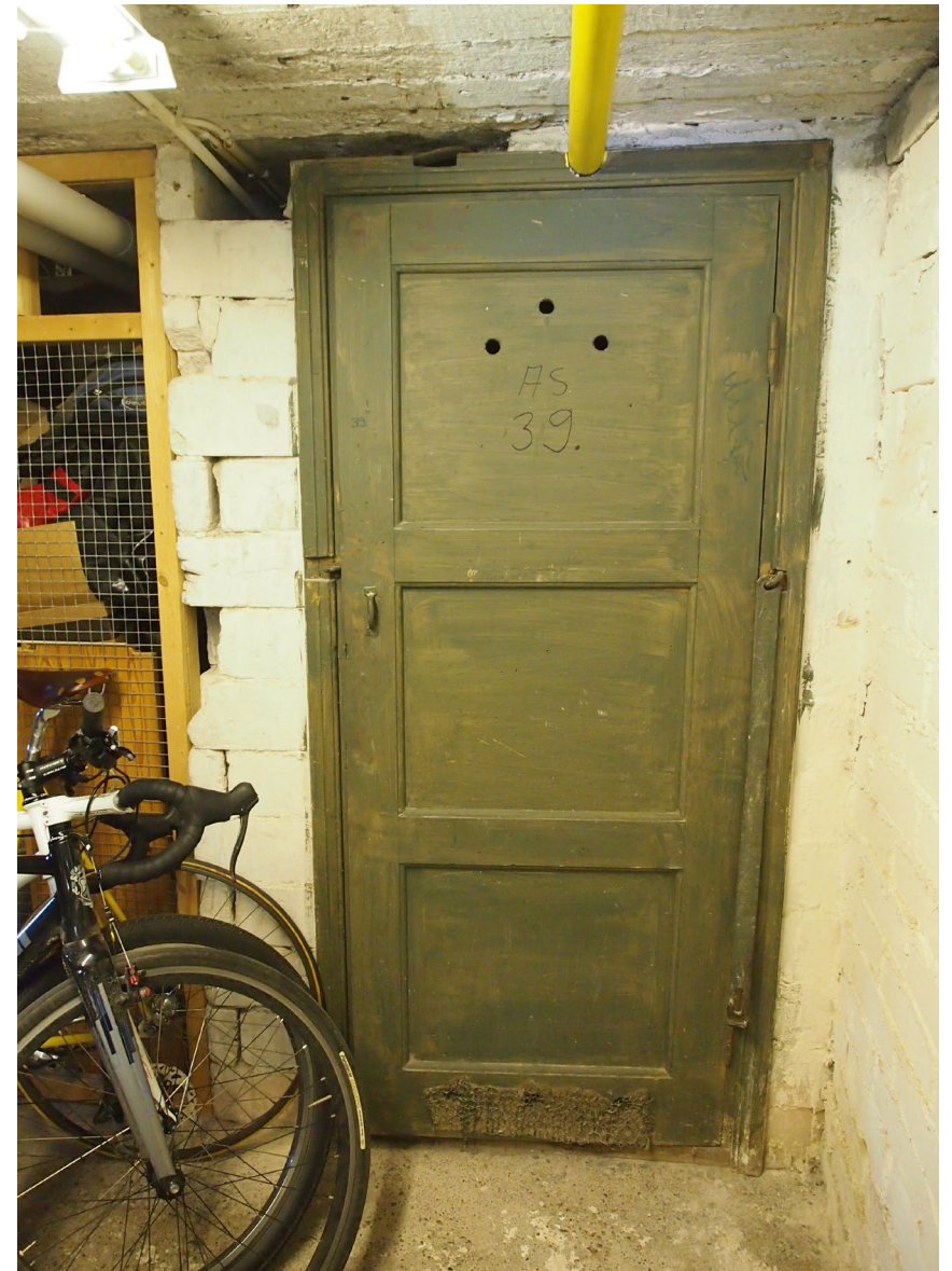
Irtainvarastoja 8 G kellarissa. Syrjätiilimuurauksella on totutettu esimerkiksi irtainvarastojen kevyitä väliseiniä. Varastoja on rajattu myös verkkoseinillä. 8 G kellarissa on vielä jäljellä alkuperäinen varaston puinen ovi.
