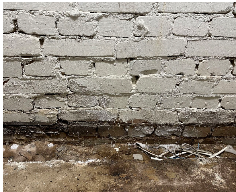
Kosteus on nostanut suoloja (valkoinen hyhmä) esille seinän ja lattian yhteenliittymässä.
