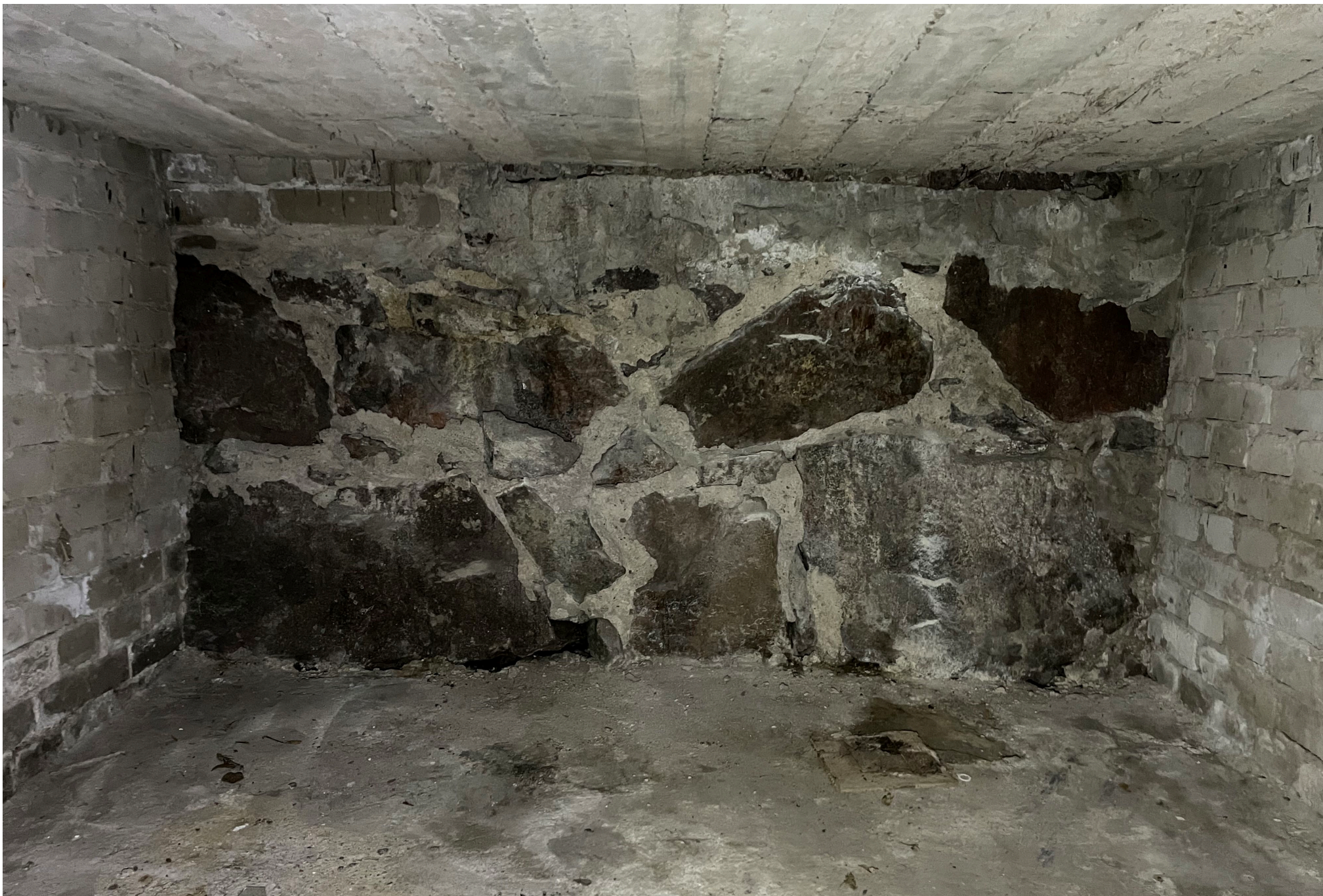
Perusmuuri 8 F sisäänkäynnin alla. Katonrajassa näkyy kaistale tiiliseinä kivenlohkareiden päällä.
