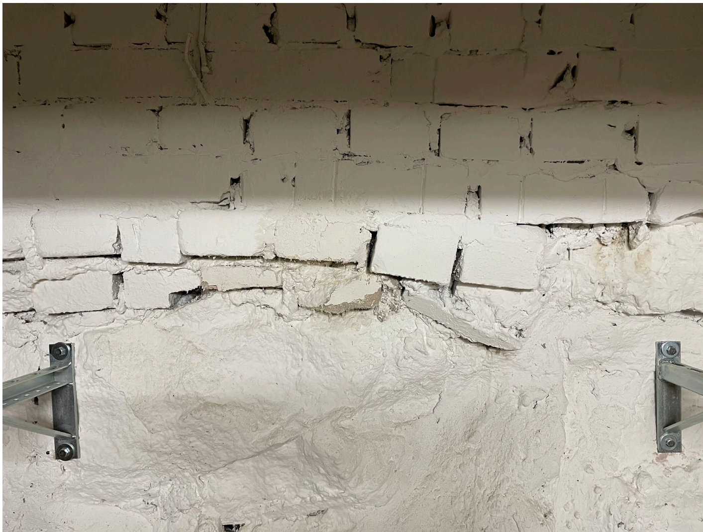
8 L-N portaikon välisen kellarin perusmuurin graniittilohkareita vasten muuratut tiilet on lohkottu ohuiksi, jotta ylemmät tiilirivit on saatu muurattua suoriksi.
