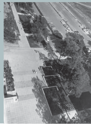
Tapiolan viimeistelyä detailimallina, suunnittelijana Jussi Jännes. Kuva: Suomen rakennustaitteen museo, Eero Troberg.
