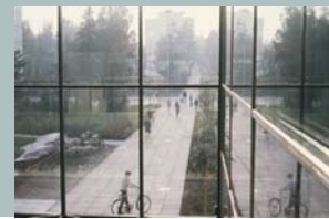
Betonilaatitusta Tapiolan keskustan raitilla. Kuva: Asuntosäätiön arkisto.
