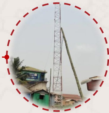
Airtel Tigo Mast
