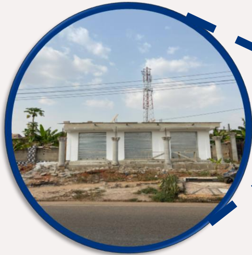
AIRTEL TIGO Mast
