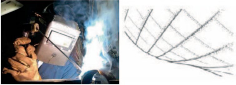
Fig. D.15 Welding
