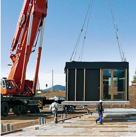
9, 10 vorinstallierte Apartmenteinheiten aus Beton, Studentenwohnheim Sant Cugat del Vallès, Barcelona, 2012 Architekten: dataAE & Harquitectes
