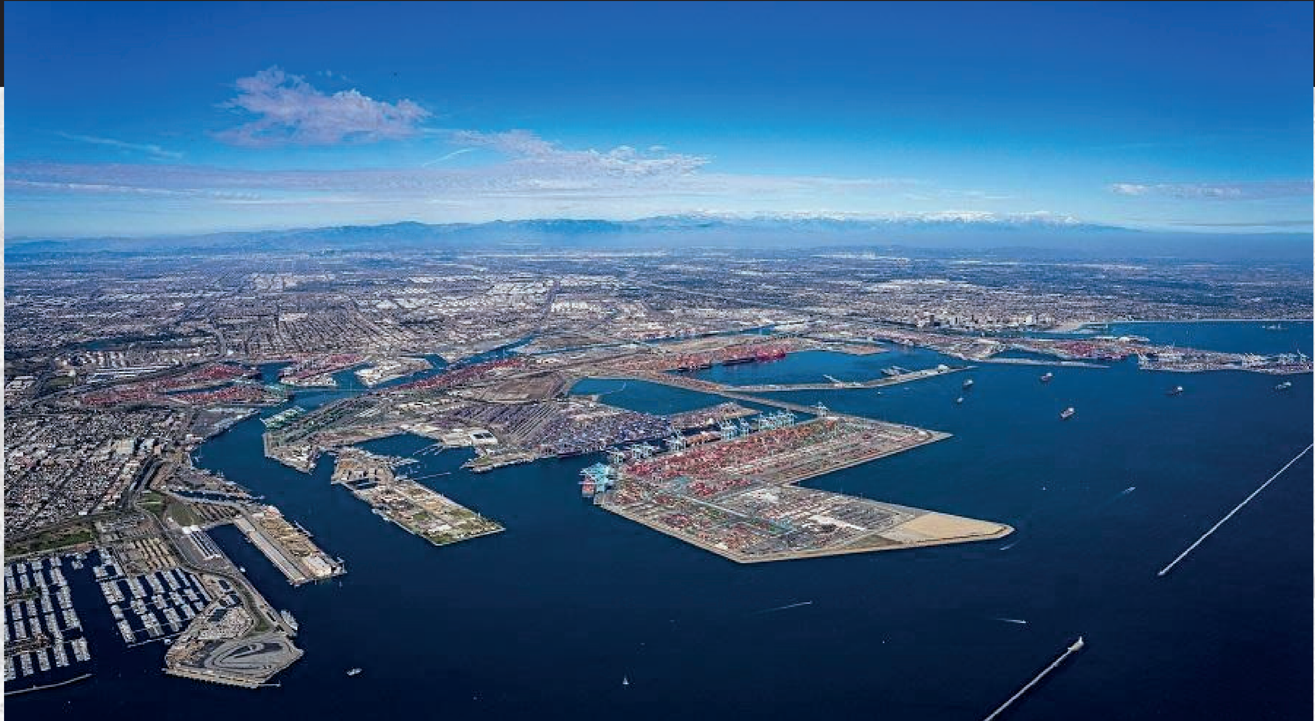
Port of Los Angeles, California.
