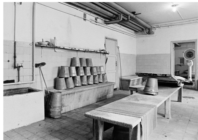
Yleisen saunan pesuhuone, Mäkelänkatu 45 (Anderson, 1973).
