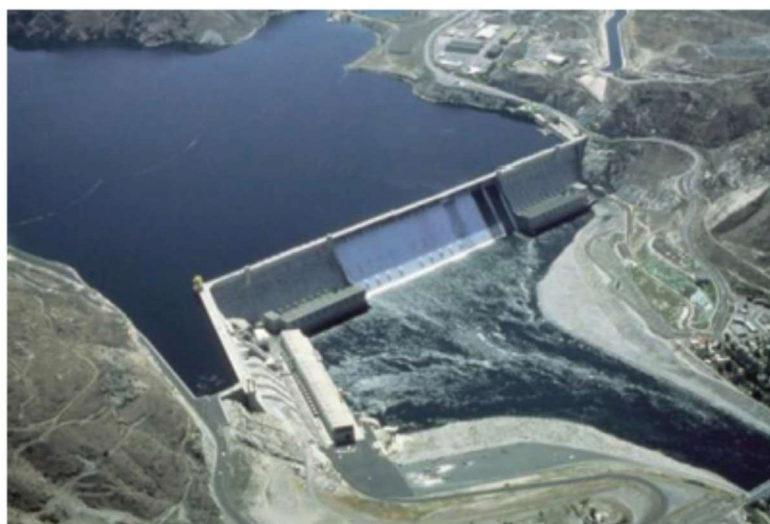
Kuva 1: Grand Coulee Dam ja siihen liittyvä tekojärvi USAssa lähellä Kanadan rajaa oli pitkään maailman suurin vesivoimalaitos (7 GW), ja se on rakennettu jo 1942. Padon korkeus on 170 m ja pituus 1,6 km.
