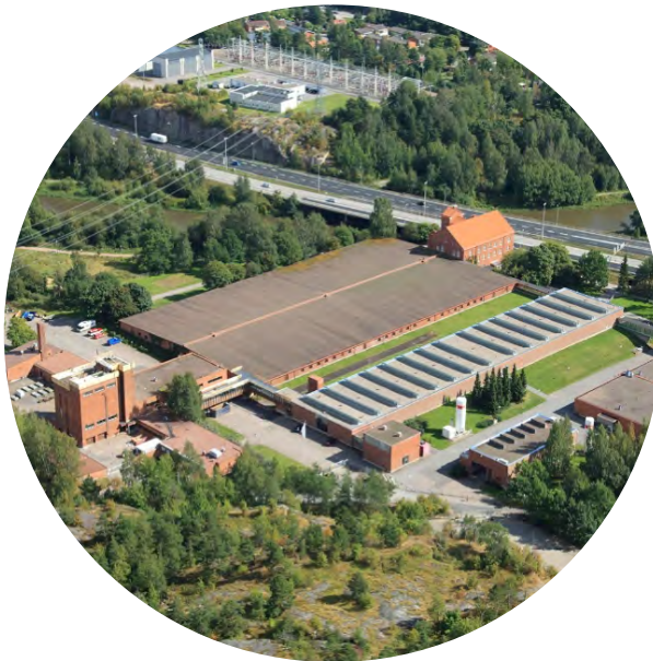
Vanhakaupunki water treatment plant
