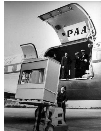
Kuva 6.9. IBM:n viiden megatavun muistiyksikkö vuodelta 1956, paino yli 1000 kiloa. 267
