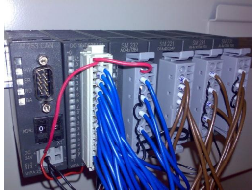
Kuva 4 CANopen IO moduuli, vasemmalla väylämoduuli, oikealla eri IO tyyppien lisämoduulit (AI, AO, DI, DO)
