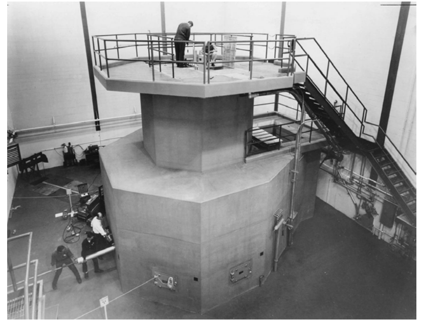
Triga Mark II tutkimusreaktori, toimi myös Otaniemessä
